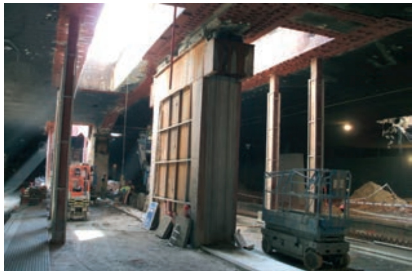
Figuras 16 y 17. Sustitución de aparatos de apoyo
