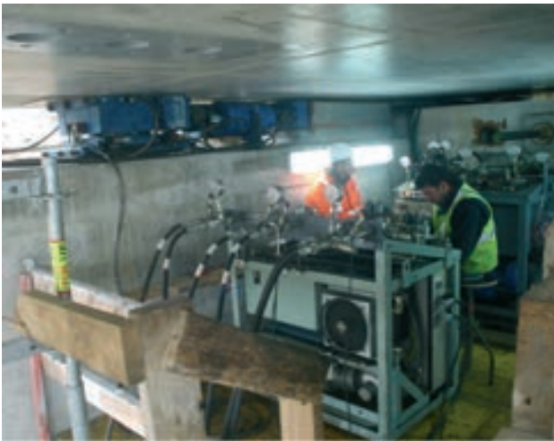
Figura 24. Gatos de fricción
