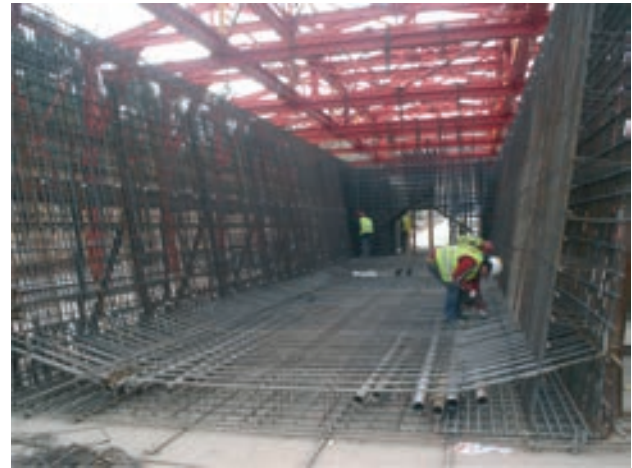
Figura 12. Ferrallado de una de las dovelas
