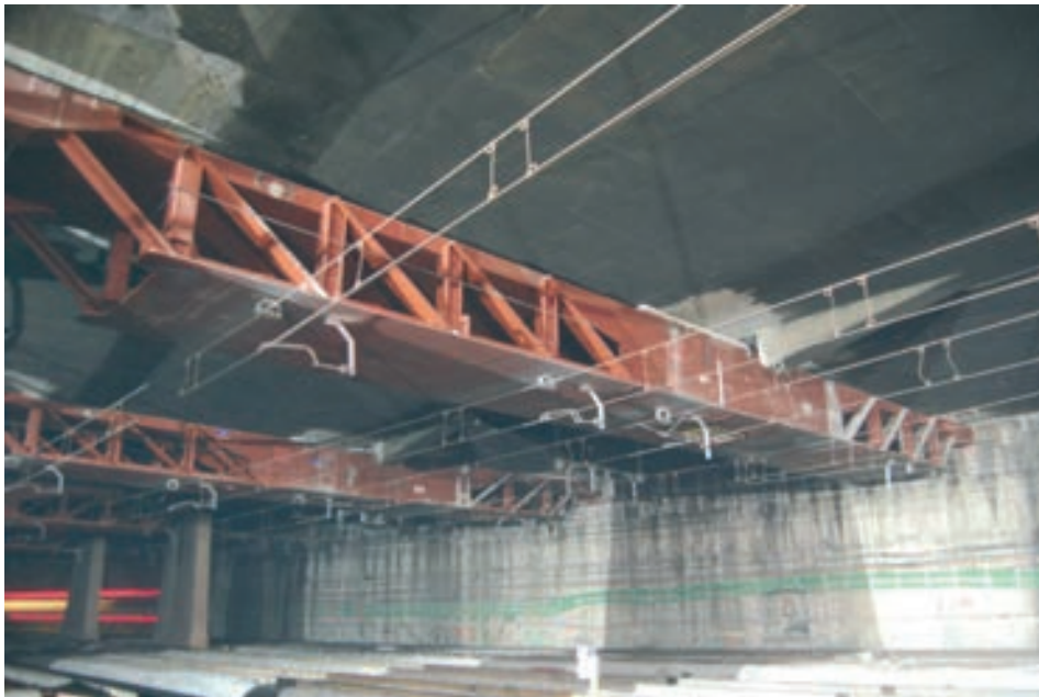
Figura 26. Pórtico situación final
