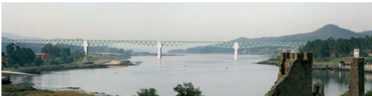
Figura 26. Vista del Viaducto sobre el río Ulla
