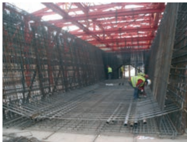
Figura 12. Ferrallado de una de las dovelas
