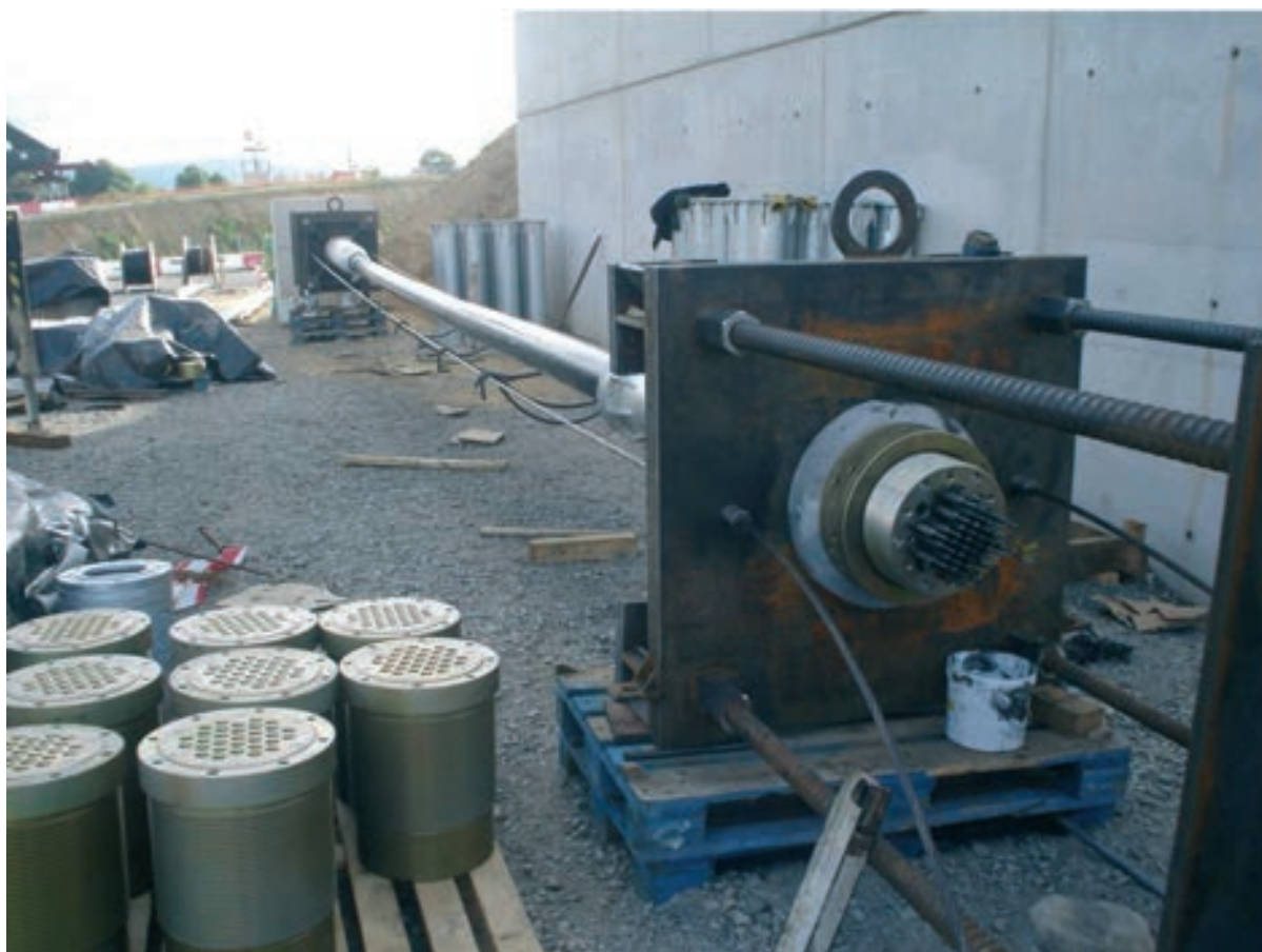
Figura 11. Bancada para tesado de péndolas
