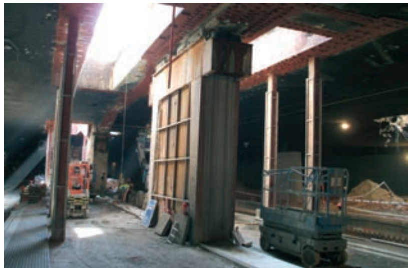
Figuras 16 y 17. Sustitución de aparatos de apoyo
