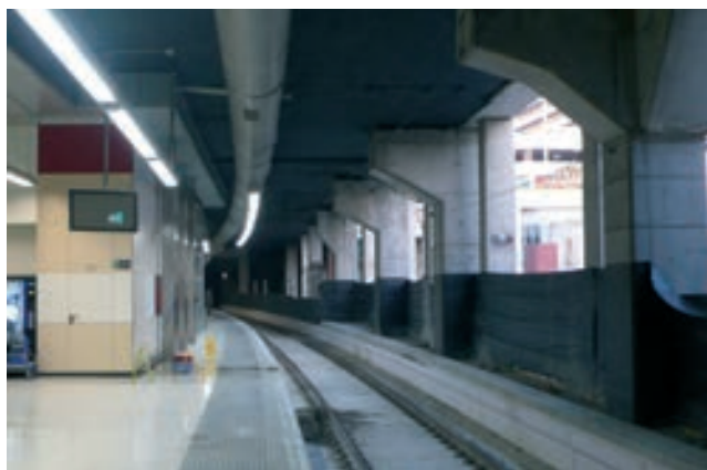
Figura 40. Vista pilares ménsula y andén
