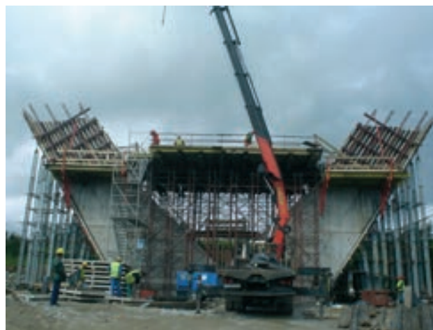
Figura 7. Pila 3 durante la construcción
