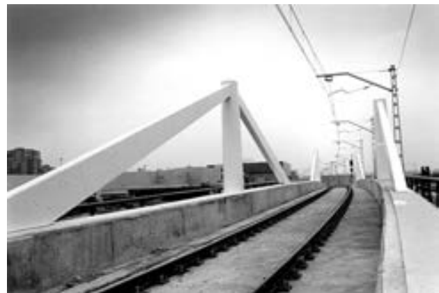
Figura 4. Vista superior del puente
