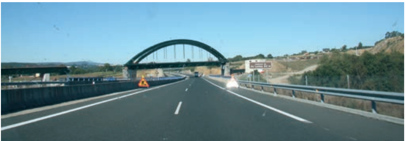
Figura 5. Vista del arco esviado desde la autopista
