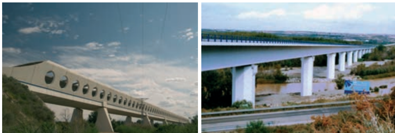
Figura 1. Viaductos sobre el río Ebro y sobre el río Cinca en la L.A.V. Madrid-Barcelona
