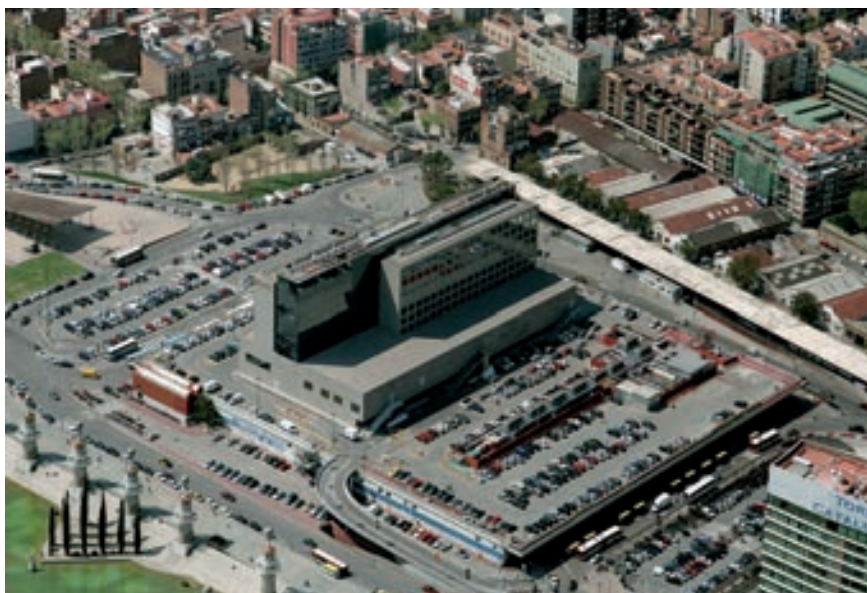
Figura 1. Vista general de la Estación de Sants
