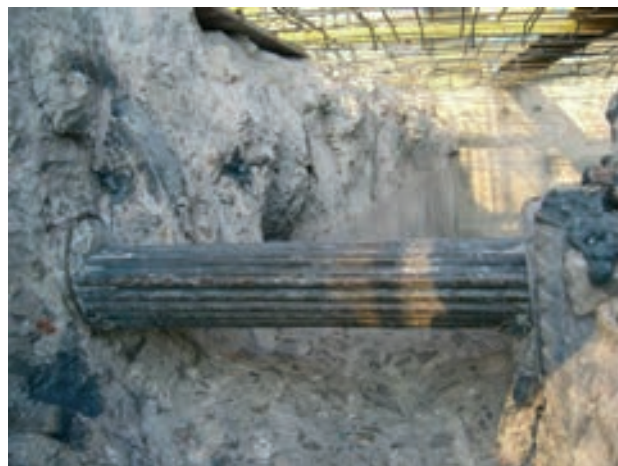
Figura 9. Pretensado de losa al descubierto
