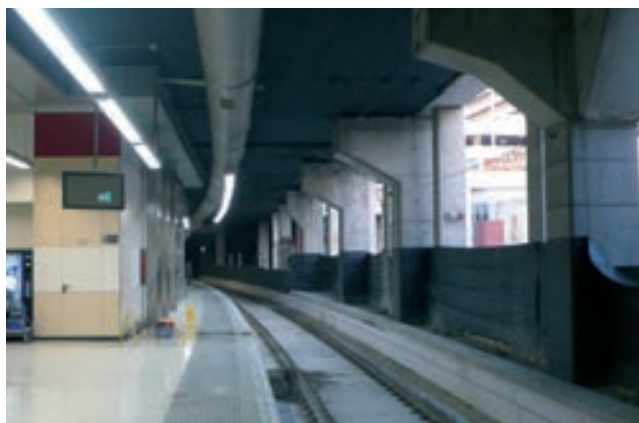
Figura 40. Vista pilares ménsula y andén
