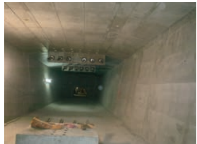
Figura 16. Pretensado de continuidad
