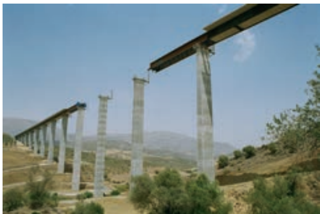
Figura 12. Vista inferior del viaducto durante el empuje
