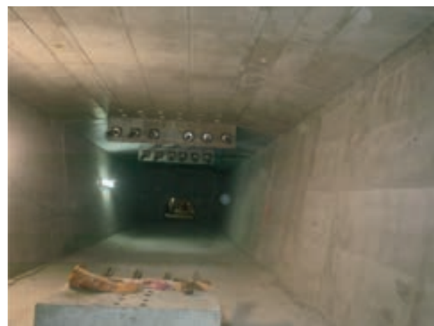
Figura 16. Pretensado de continuidad
