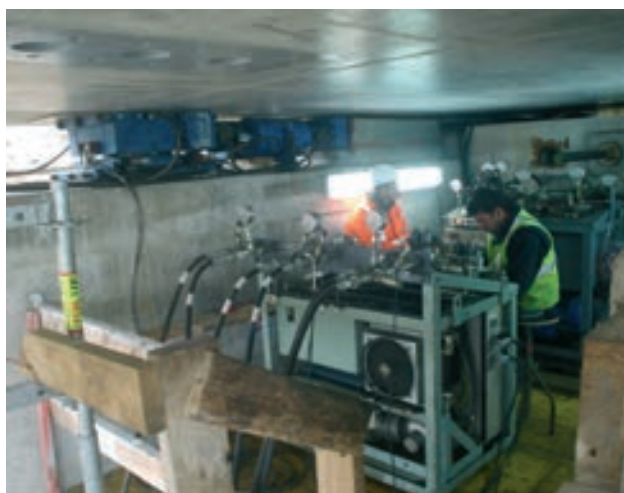
Figura 24. Gatos de fricción
