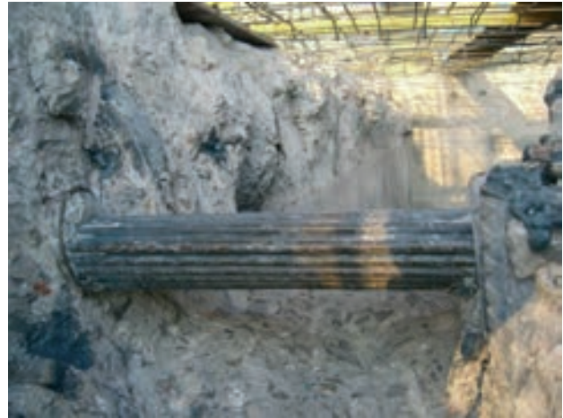
Figura 9. Pretensado de losa al descubierto
