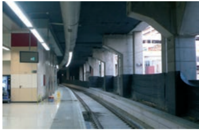
Figura 40. Vista pilares ménsula y andén
