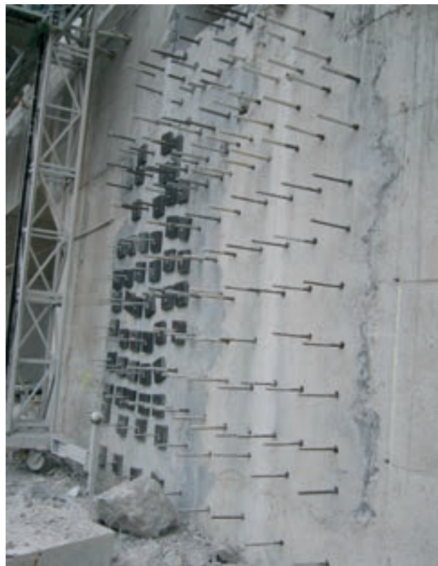
Figura 29. Refuerzo de muro
