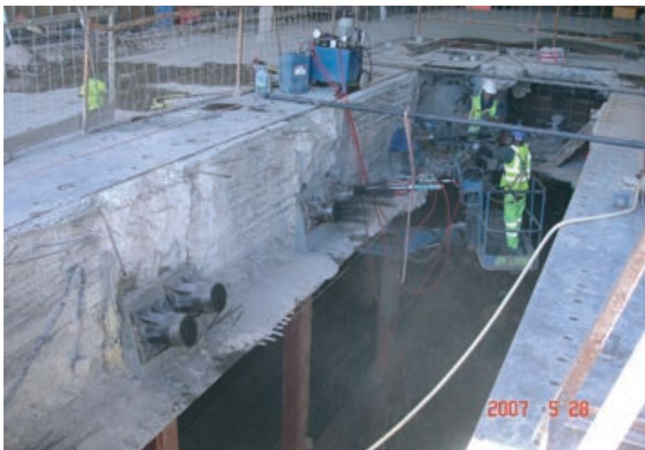
Figura 10. Retesado de los tendones de pretensado
