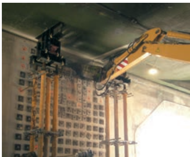
Figura 30. Refuerzo de muro
