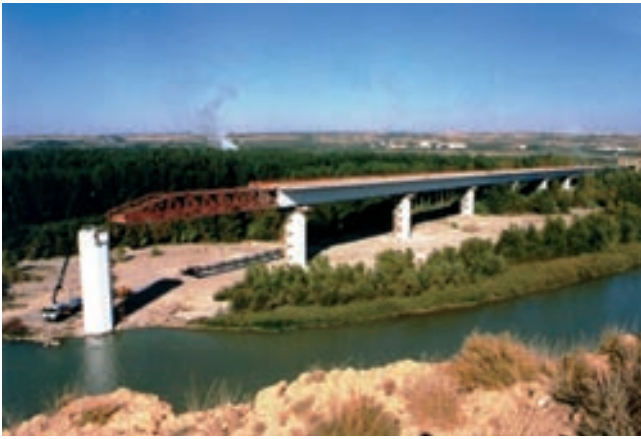
Figura 2. Viaductos empujados del Cinca (880 m) y Ginel (1.228 m)
