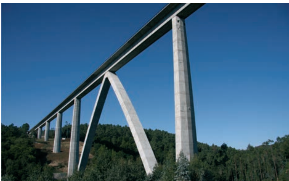
Figura 10. Arco del viaducto sobre Río Deza
