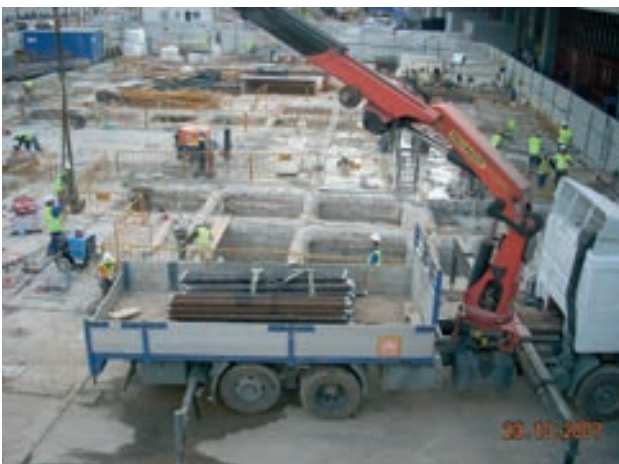
Figura 4. Huecos en la losa vista superior
