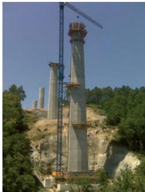
Figura 5. Construcción de la pila 12 del viaducto sobre Río Deza, de 96,50 m de altura
