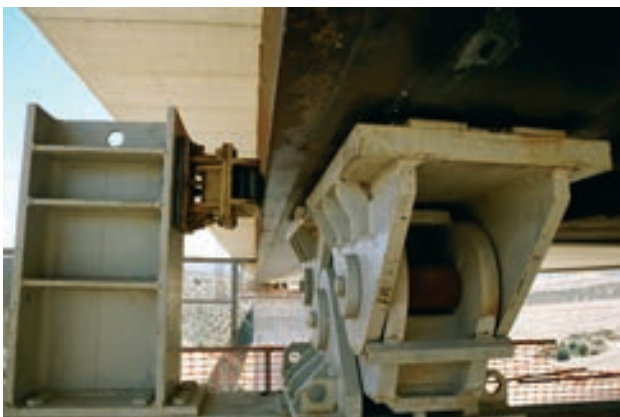
Figura 13. Detalle de apoyos deslizantes con topes laterales durante el empuje
