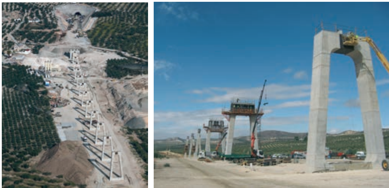
Figura 19. Vista de las pilas durante la ejecución
