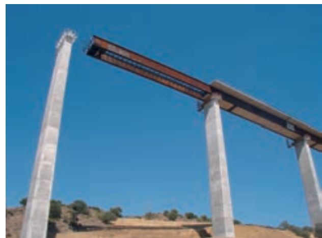
Figura 15. Vista del voladizo antes de llegar a la pila
