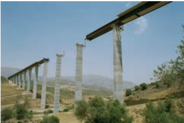
Figura 12. Vista inferior del viaducto durante el empuje
