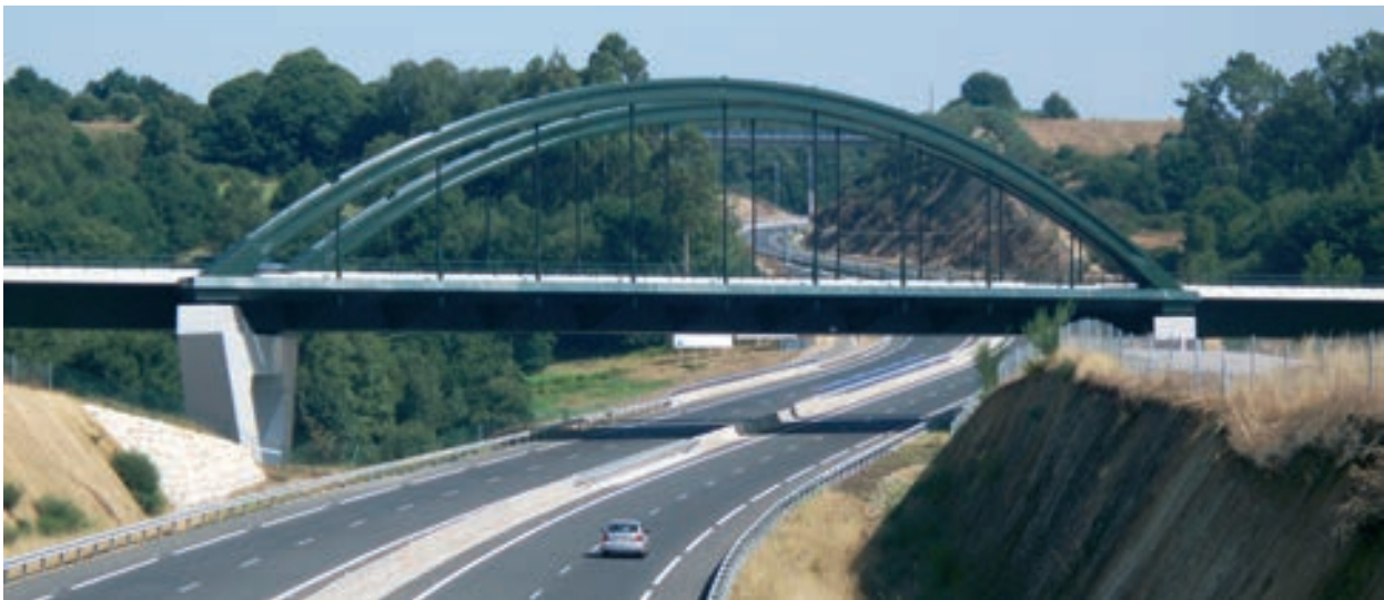
Figura 2. Vista del viaducto sobre la autopista
