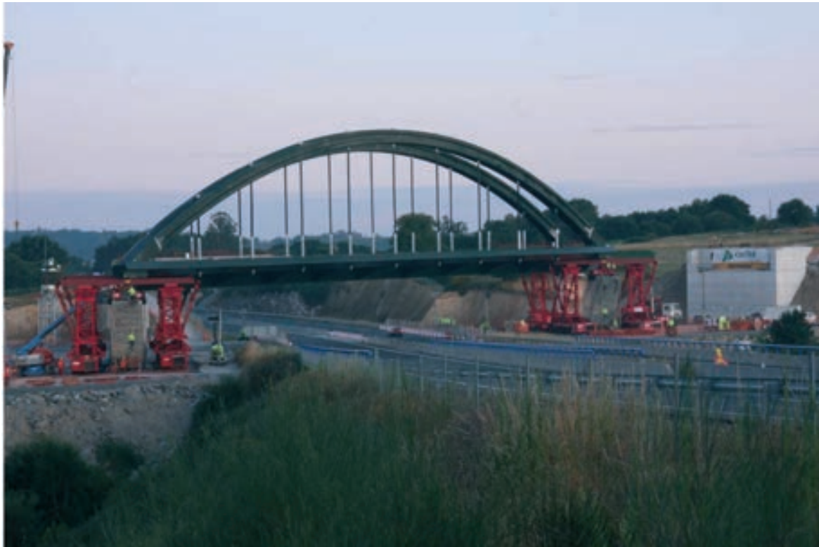
Figura 15. Ubicación del vano en su posición definitiva
