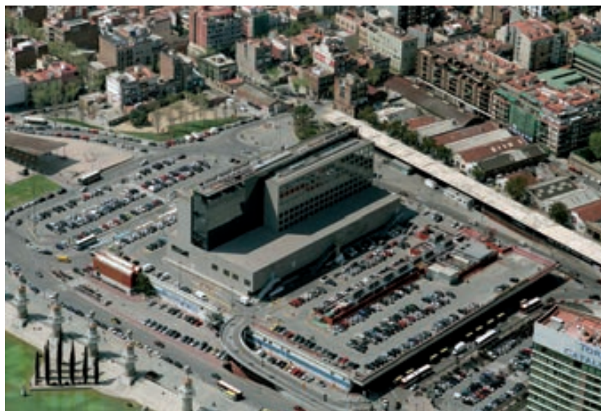
Figura 1. Vista general de la Estación de Sants
