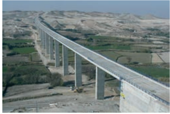
Figura 2. Viaductos empujados del Cinca (880 m) y Ginel (1.228 m)
