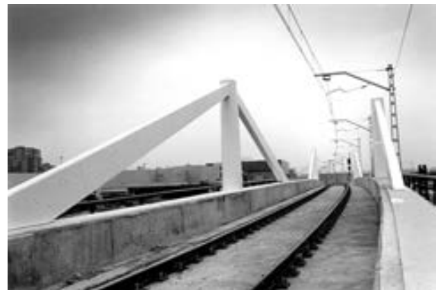
Figura 4. Vista superior del puente
