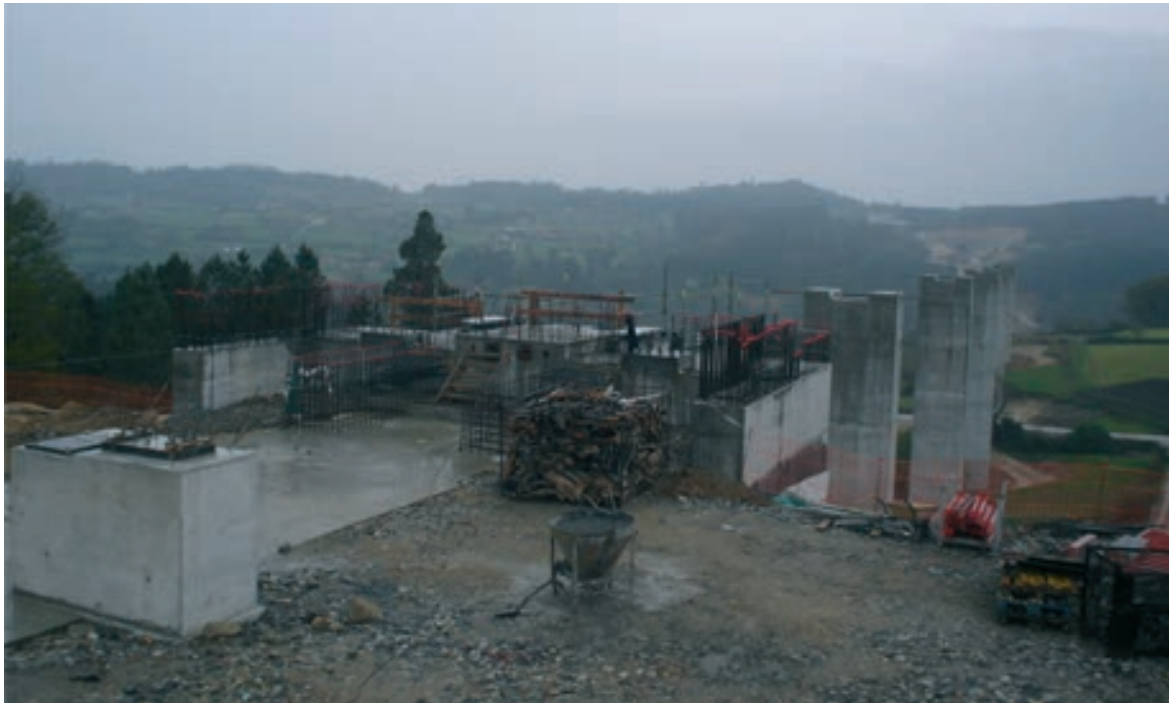
Figura 7. Estribo 1 viaducto sobre Río Deza
