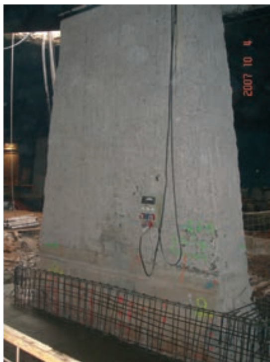
Figuras 13 y 14. Refuerzo de pilares
