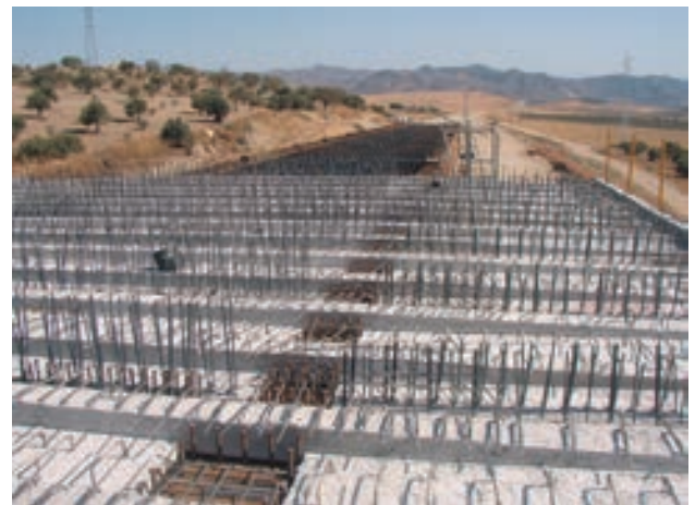
Figura 10. Vista de prelasas superiores
