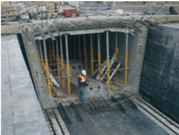
Figura 11. Sección transversal del tablero
