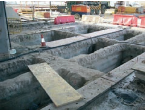
Figura 8. Refuerzo de hueco de losa
