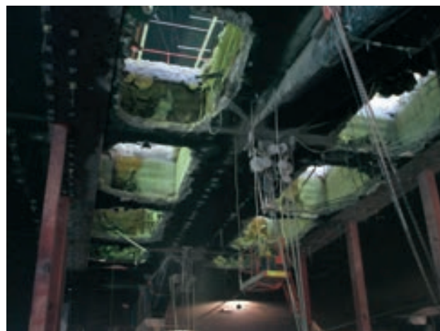
Figura 5. Huecos en la losa vista inferior
