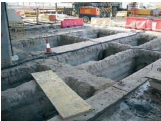
Figura 8. Refuerzo de hueco de losa
