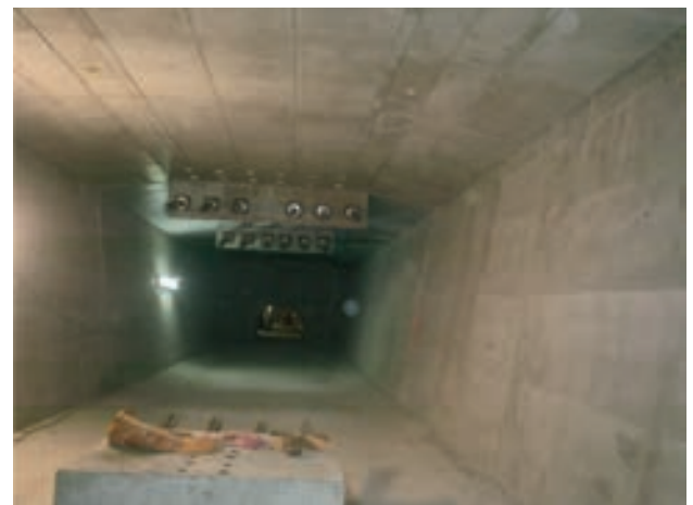
Figura 16. Pretensado de continuidad
