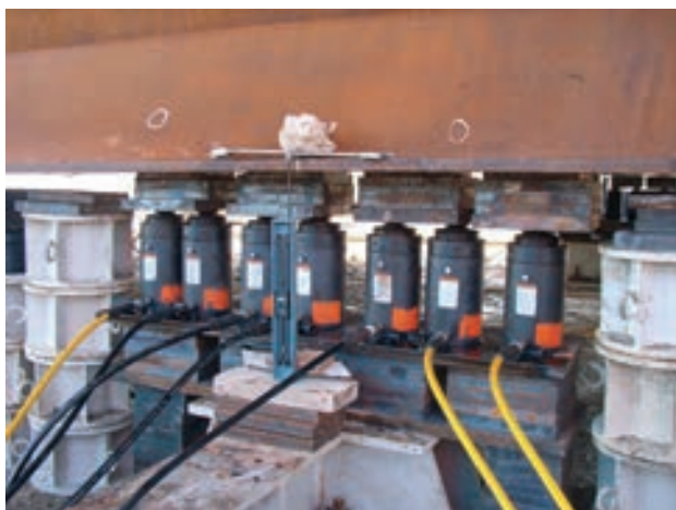
Figura 16. Aplicación de reacción localizada con gatos
