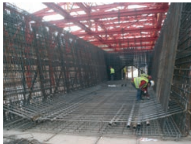
Figura 12. Ferrallado de una de las dovelas
