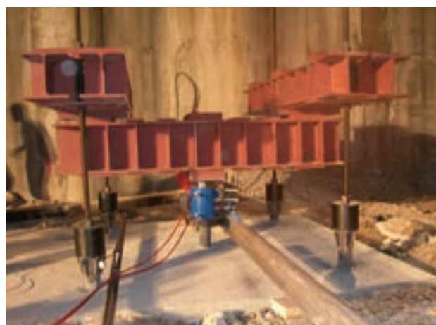
Figura 36. Prueba de carga de micropilote
