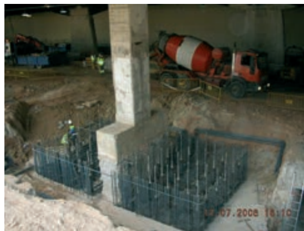
Figura 34. Ejemplo de recalce de un pilar de la estación
