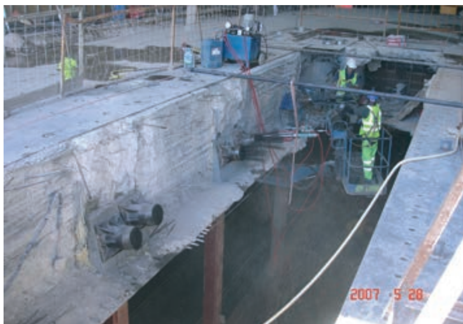
Figura 10. Retesado de los tendones de pretensado
