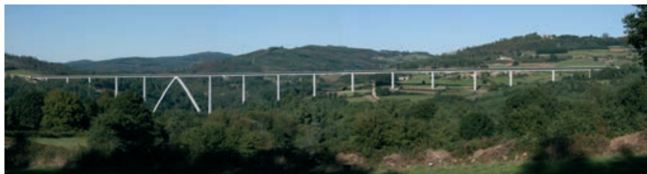
Figura 2. Viaducto sobre Río Deza
