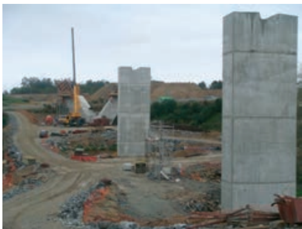
Figura 6. Pilas 1 y 2 durante la construcción
