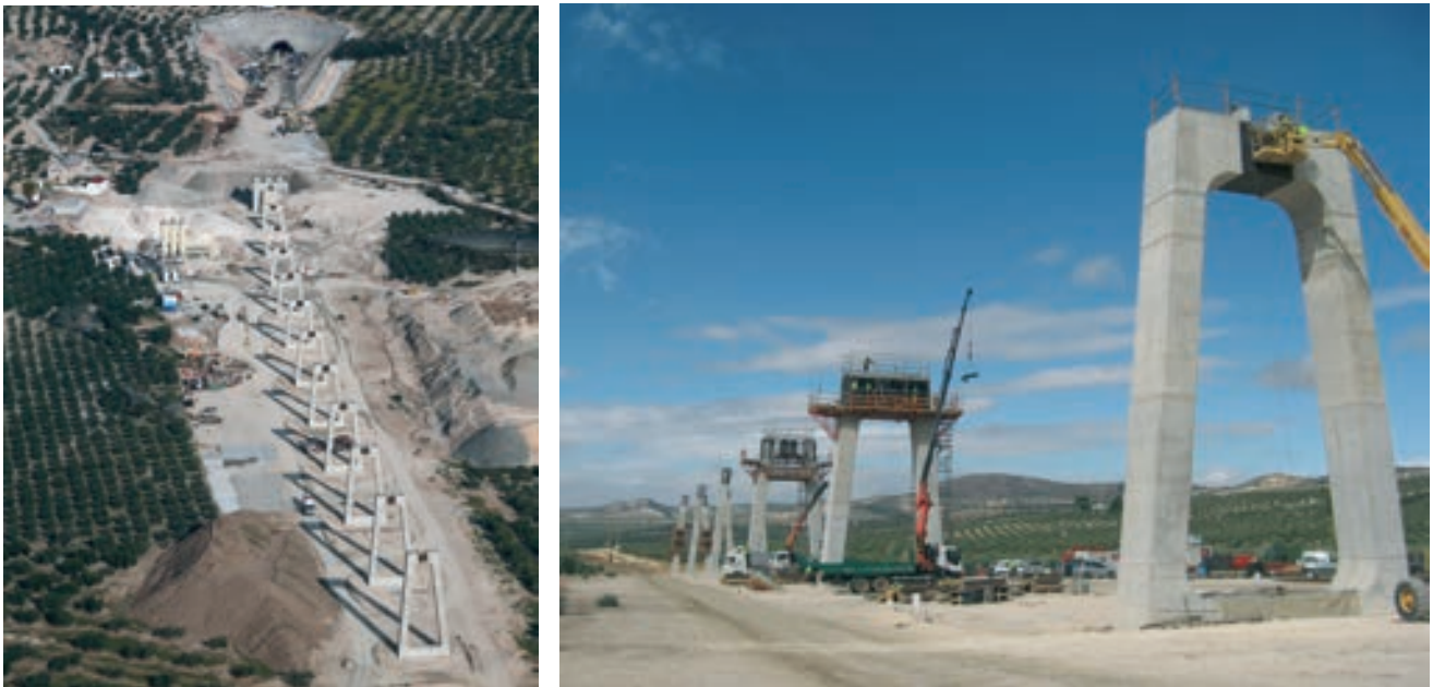
Figura 19. Vista de las pilas durante la ejecución
