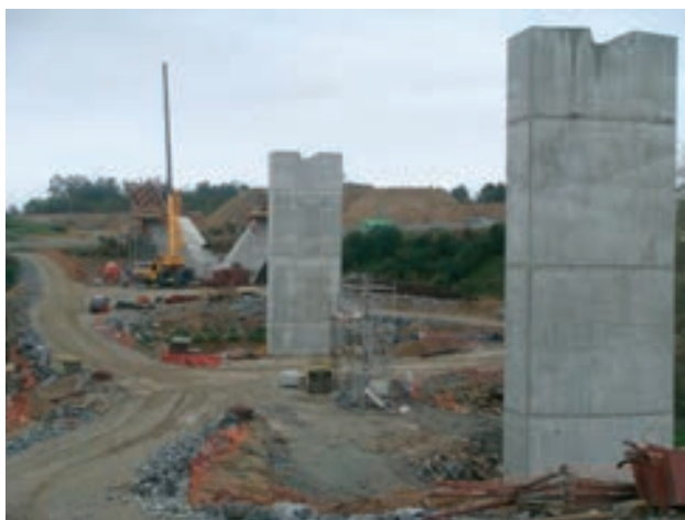
Figura 6. Pilas 1 y 2 durante la construcción
