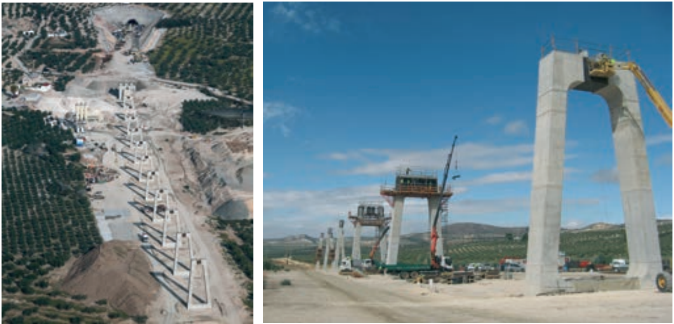
Figura 19. Vista de las pilas durante la ejecución
