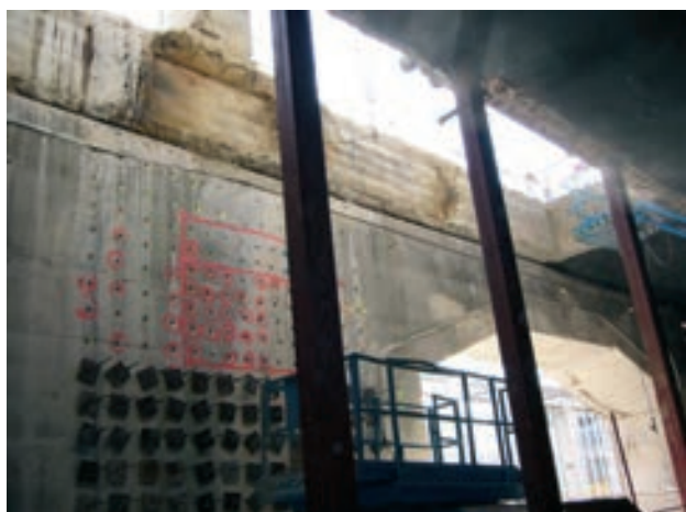
Figura 28. Hueco en muro, refuerzo muro y hueco en forjado
