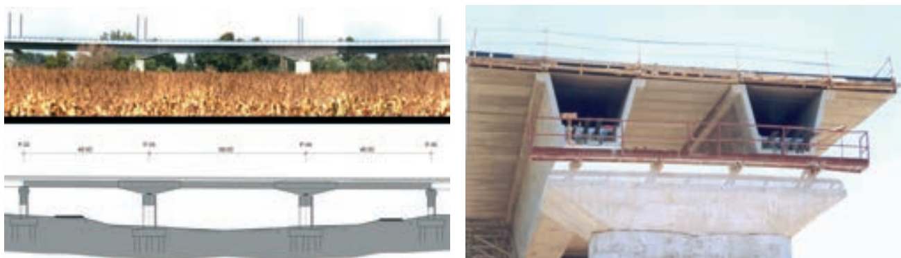
Figura 5. Viaducto prefabricado sobre el Jarama. L.A.V. Madrid-Zaragoza (luz central 58 m)
