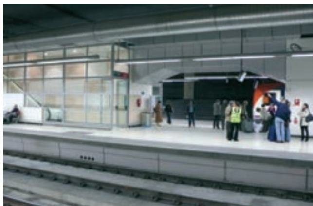
Figura 39. Aspecto final hueco y andén
