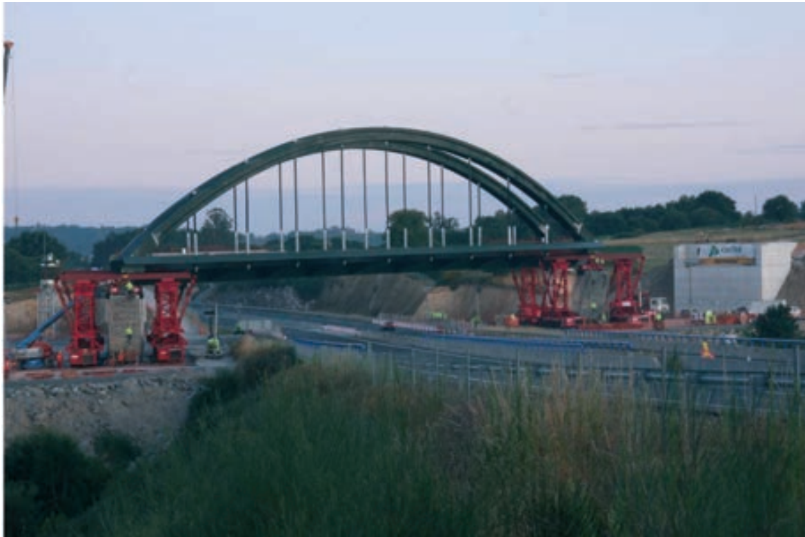
Figura 15. Ubicación del vano en su posición definitiva
