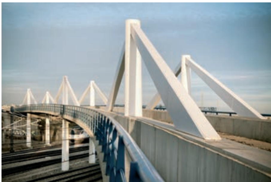
Figura 1. Vista general del puente ferroviario Salto del Carnero
