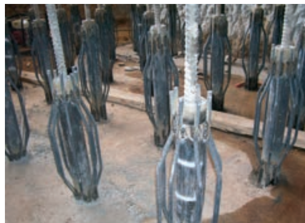
Figura 35. Ejemplo de conexión micropilote-estructura
