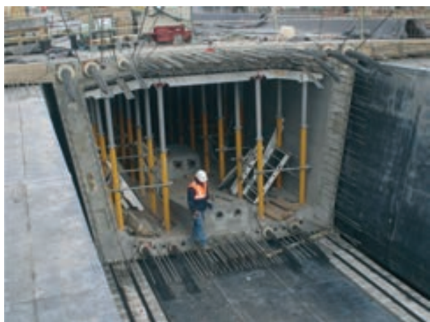
Figura 11. Sección transversal del tablero
