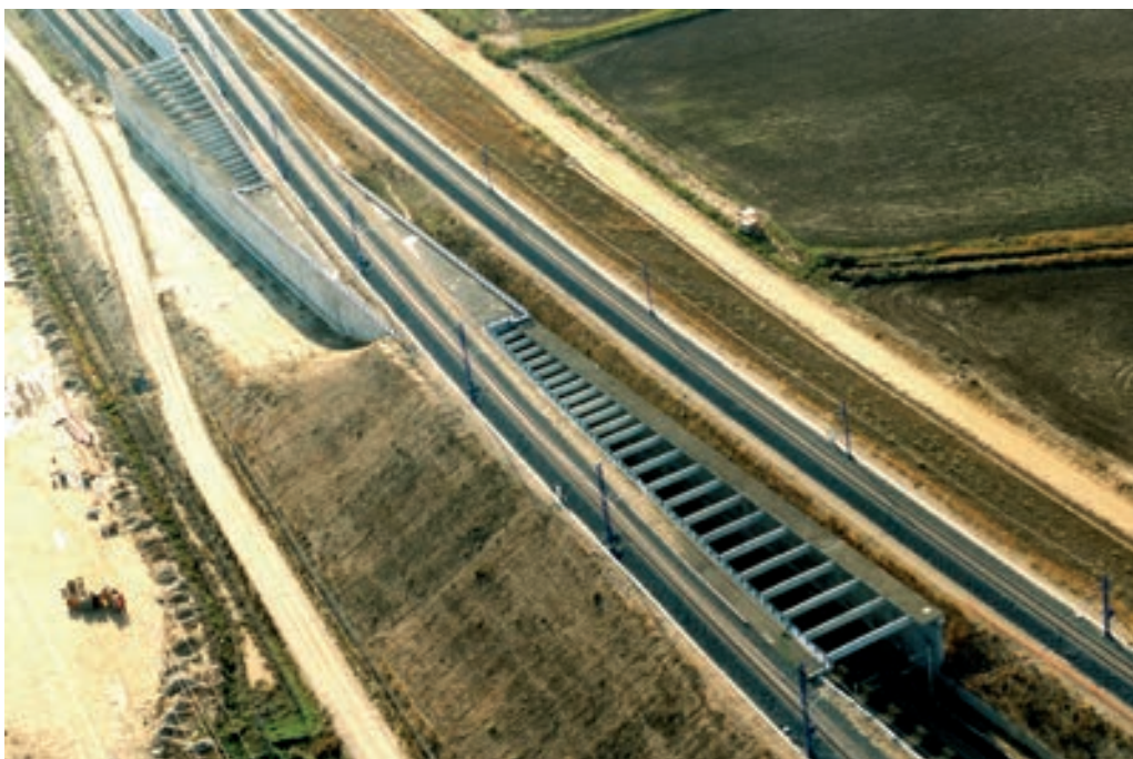
Figura 4. Vista general de la pérgola en la L.A.V. Madrid-Toledo en Alameda de la Sagra
