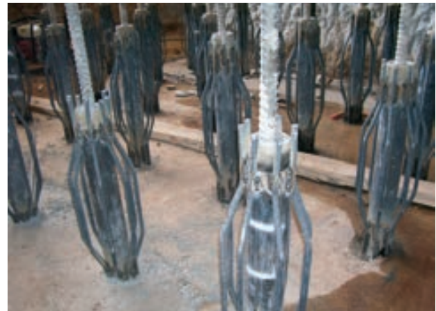
Figura 35. Ejemplo de conexión micropilote-estructura
