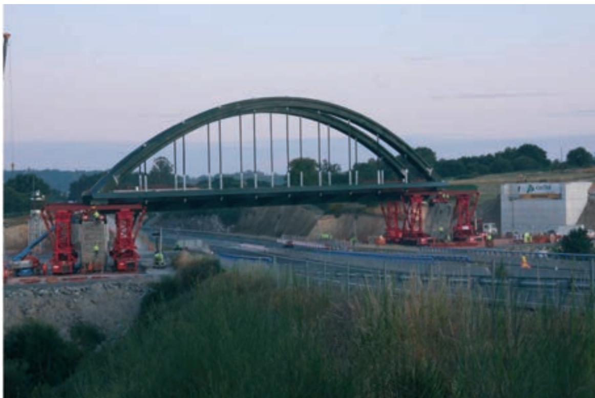
Figura 15. Ubicación del vano en su posición definitiva
