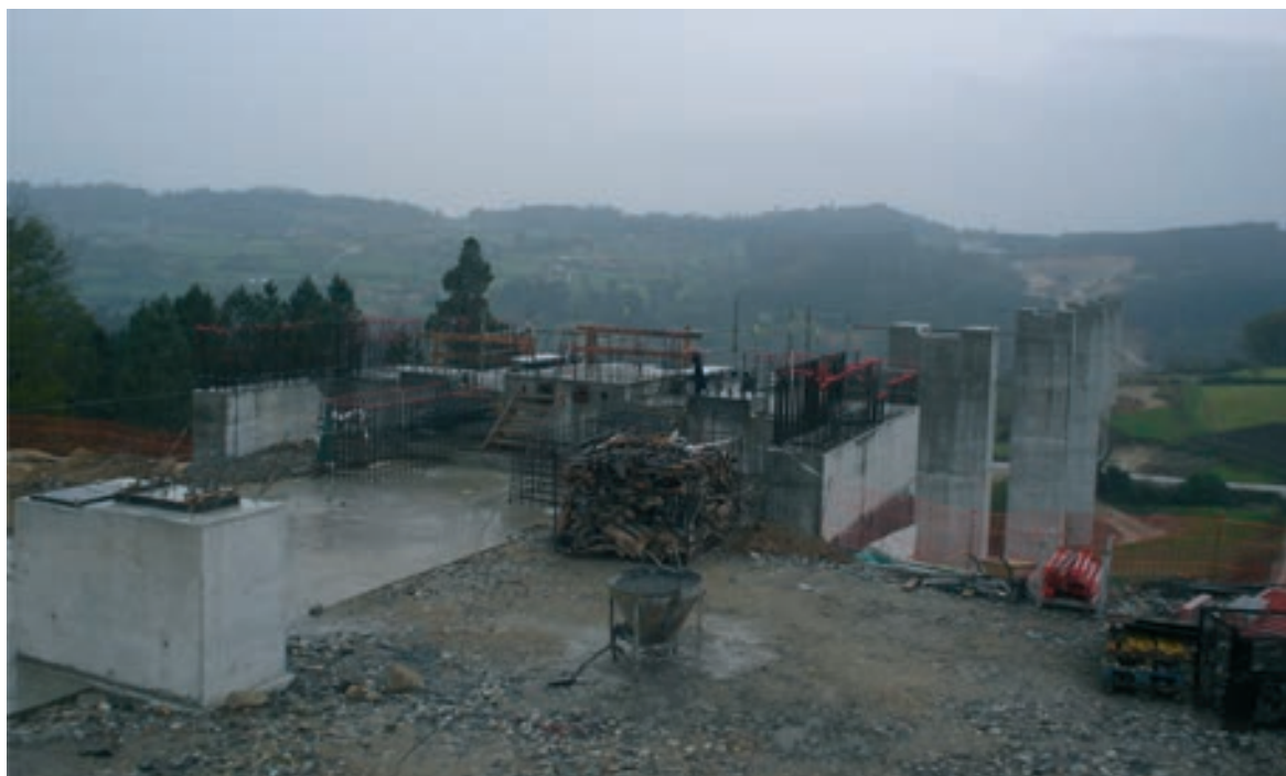
Figura 7. Estribo 1 viaducto sobre Río Deza
