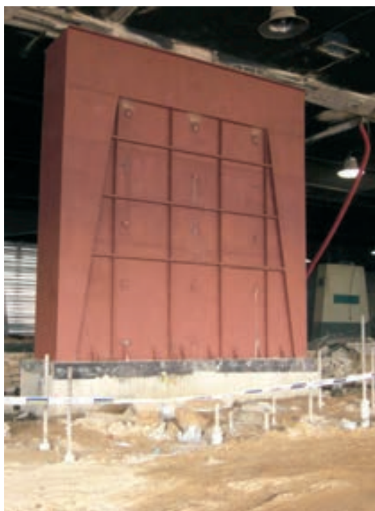
Figuras 13 y 14. Refuerzo de pilares
