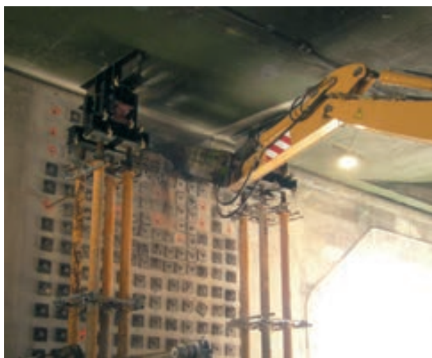
Figura 30. Refuerzo de muro
