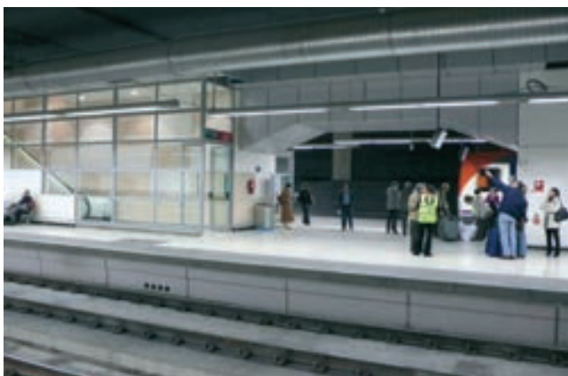
Figura 39. Aspecto final hueco y andén
