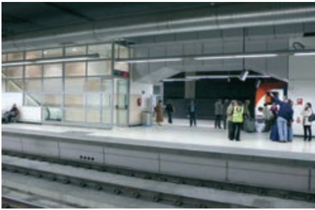
Figura 39. Aspecto final hueco y andén
