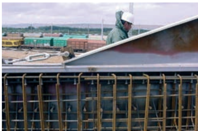
Figura 13. Proceso constructivo; a) Cimbra; b) Armadura de la viga en la zona de unión viga-tirante
