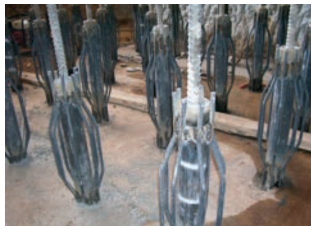
Figura 35. Ejemplo de conexión micropilote-estructura
