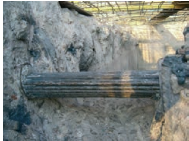
Figura 9. Pretensado de losa al descubierto
