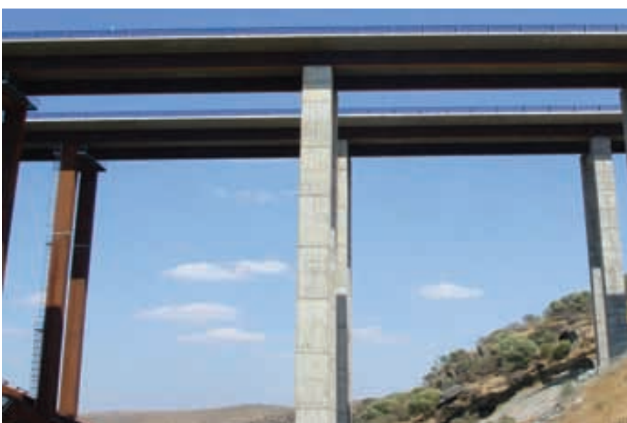
Figura 11. Tramo de acceso. Figure 11. Approach stretch.
