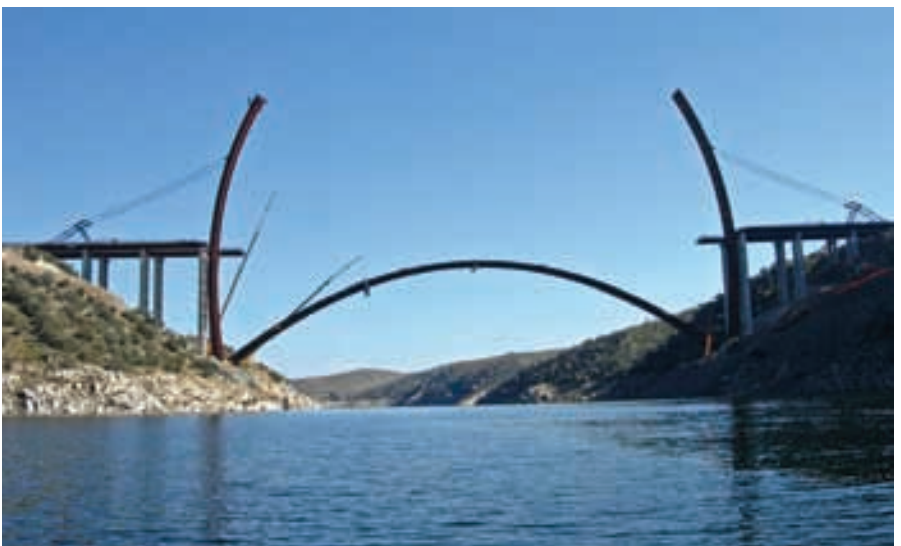
Figura 37. Semiarcos del segundo puente en posición vertical Figure 37. Semi-arches of the second bridge in a vertical position.
