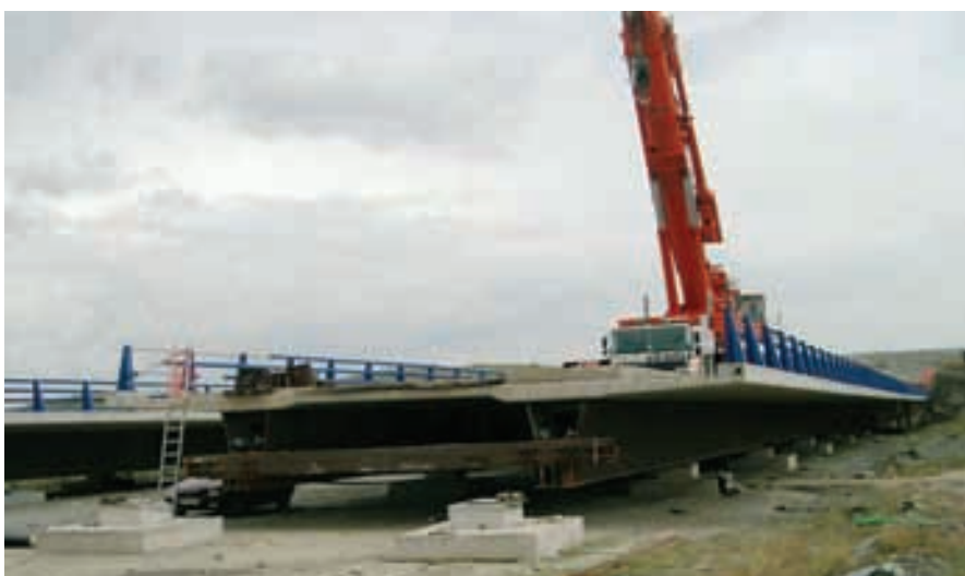
Figura 16. Empuje de un tablero. En la parte trasera, viga metálica transversal de empuje. Figure 16. Pushing a deck. At the back, metal cross pushing beam.
