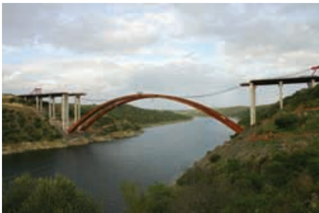
Figura 38. Cierre en clave de arco del segundo puente. Figure 38. Crown closure of second bridge's arch.
