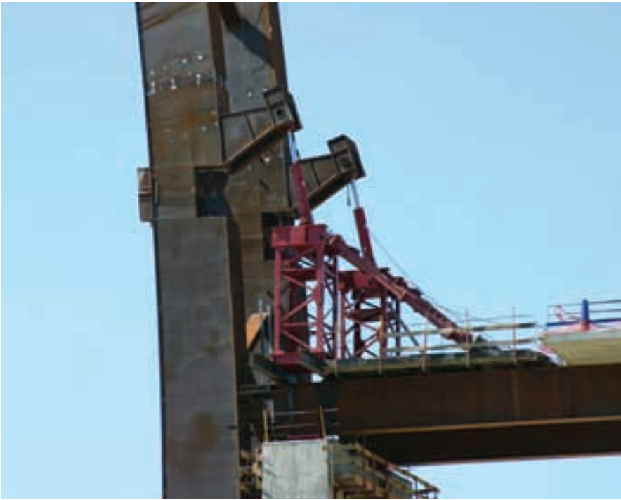
Figura 28. Posición final de basculamiento del segundo cuarto de arco. Figure 28. Final tilting position of the second quarter arch.
