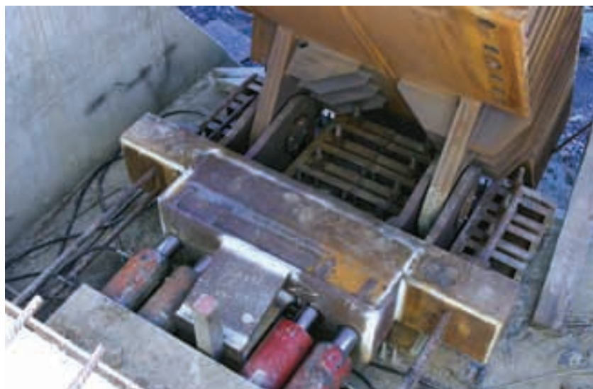
Figura 47. Zona inferior del arco Figure 47. Bottom arch area.
