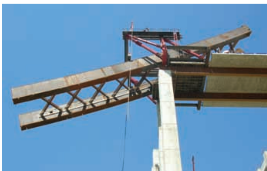
Figura 20. Basculamiento del primer cuarto de arco (2). Figure 20. Tilting the first quarter arch (2).
