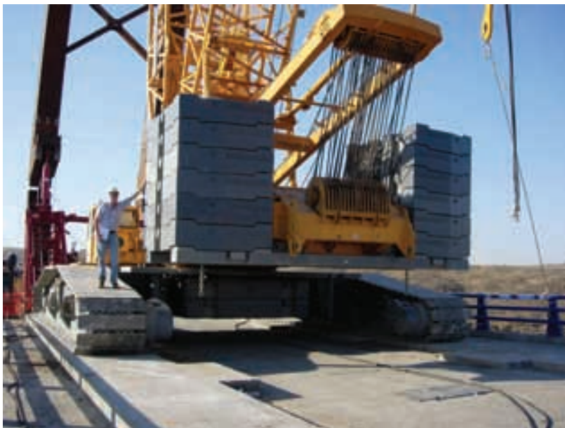
Figura 24. Grúa sobre tablero. Figure 24. Crane on deck.
