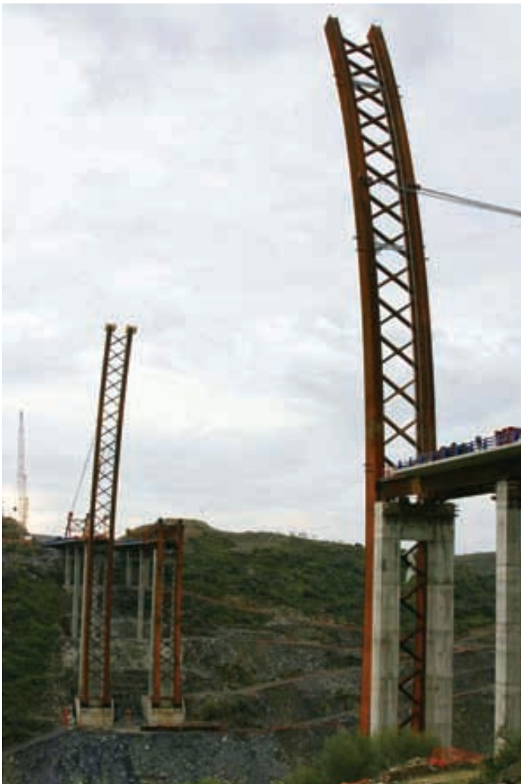
Figura 29. Semiarcos en posición vertical. Altura: 120 metros. Figure 29. Semi-arches in vertical position. Height: 120 metres.
