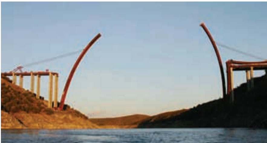
Figura 31. Abatimiento de semiarcos (1). Figure 31. Swivel lowering semi-arches (1).
