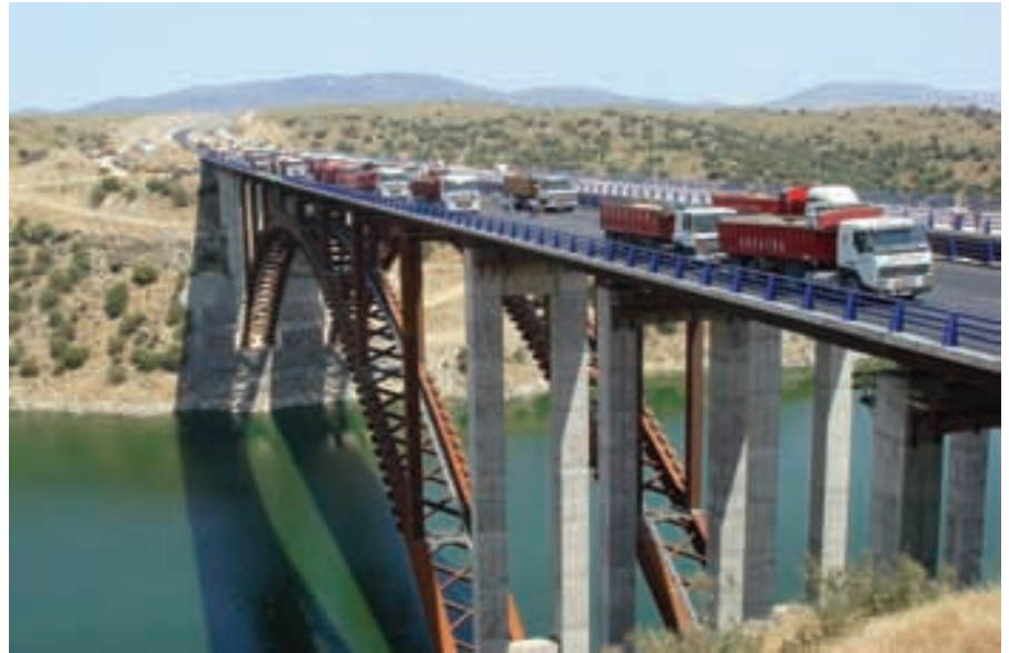
Figura 62. Prueba de carga. Figure 62. Load test.
