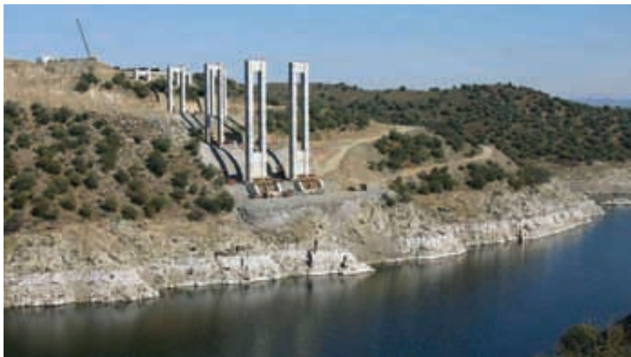
Figura 14. Construcción de macizos de arranque de arcos, pilas de hormigón y estribos. Figure 14. Construction of springing blocks of arches, concrete piers and abutments.
