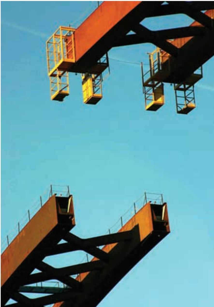
Figura 51. Extremo frontal de semiarcos en posición previa al cierre en clave. Figure 51. Front end of semi-arches prior to crown closure.
