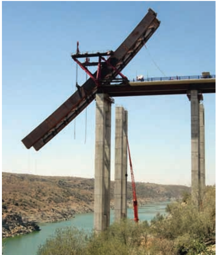
Figura 19. Basculamiento del primer cuarto de arco (1). Figure 19. Tilting the first quarter arch (1).
