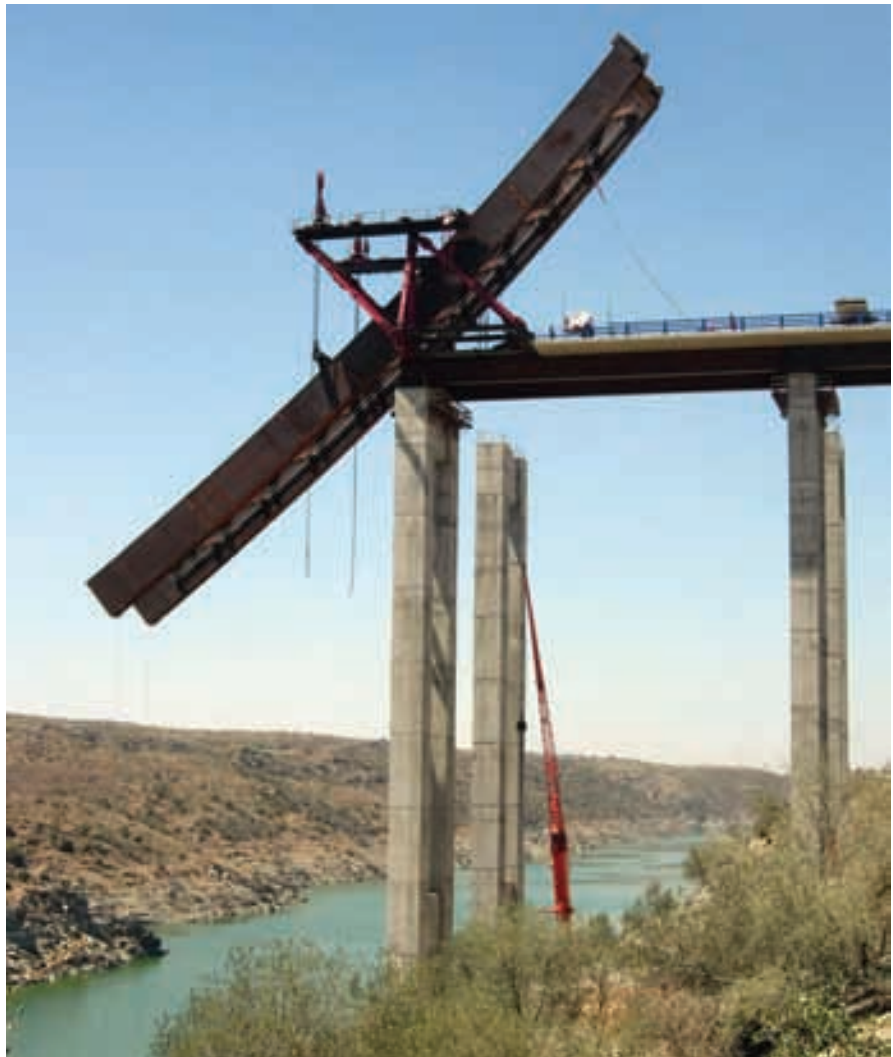
Figura 19. Basculamiento del primer cuarto de arco (1). Figure 19. Tilting the first quarter arch (1).
