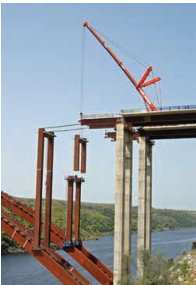
Figura 39. Montaje de pilas metálicas con grúa sobre tablero. Figure 39. Crane mounting metal piers on deck.
