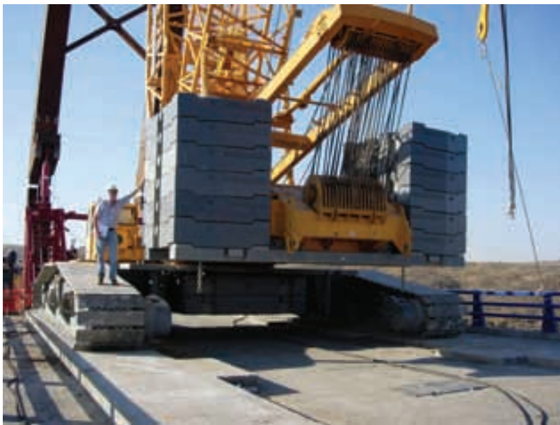
Figura 24. Grúa sobre tablero. Figure 24. Crane on deck.
