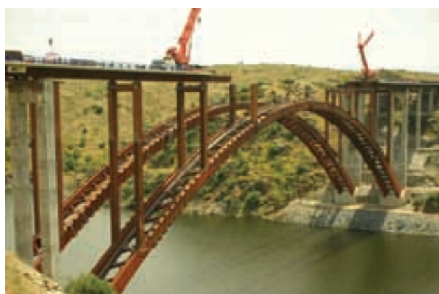
Figura 41. Empuje de tablero sobre arco (2). Figure 41. Deck pushing over arch (2).
