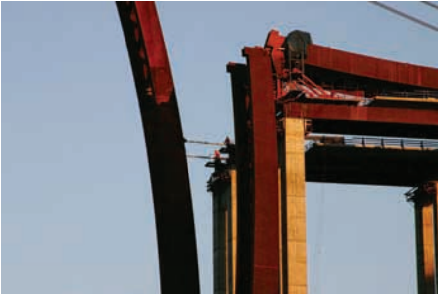
Figura 30. Inicio de la operación de abatimiento, mediante empuje de semiarco con gatos telescópicos. Figure 30. Start of swivel lowering operation by telescopic jack semi-arch pushing.
