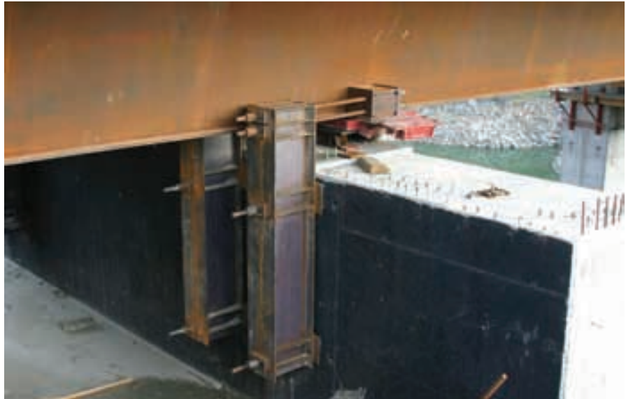
Figura 46. Sistema de fijación horizontal del tablero al estribo Figure 46. Horizontal deck to abutment securing system.
