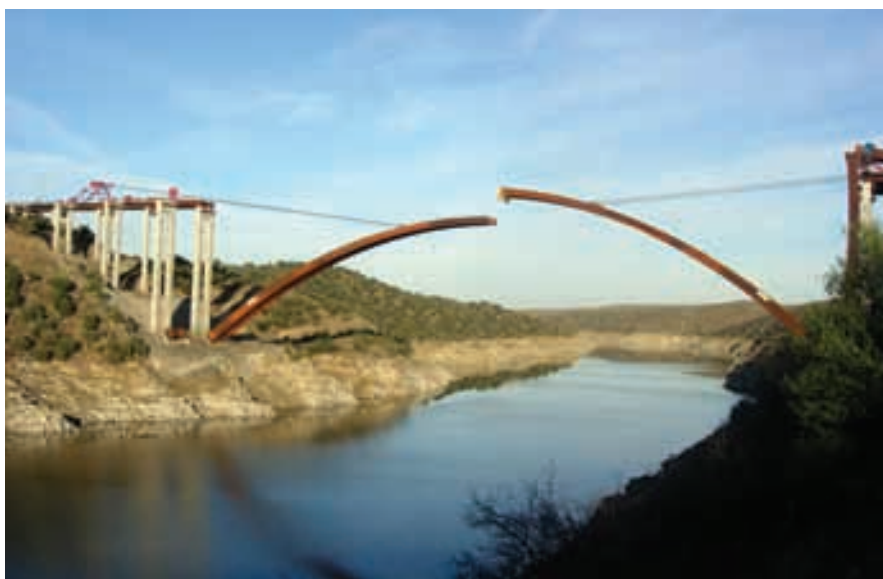
Figura 32. Abatimiento de semiarcos (2). Figure 32. Swivel lowering semi-arches (2).
