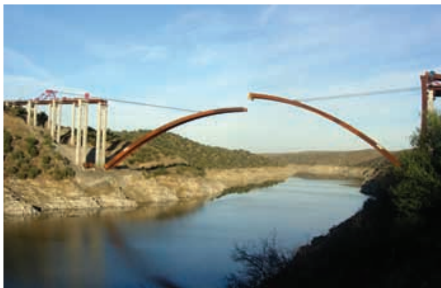
Figura 32. Abatimiento de semiarcos (2). Figure 32. Swivel lowering semi-arches (2).
