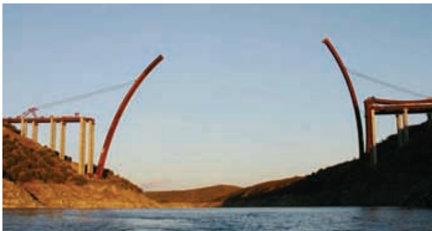
Figura 31. Abatimiento de semiarcos (1). Figure 31. Swivel lowering semi-arches (1).
