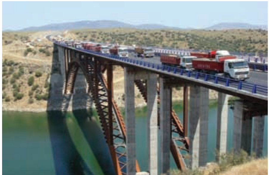
Figura 62. Prueba de carga. Figure 62. Load test.
