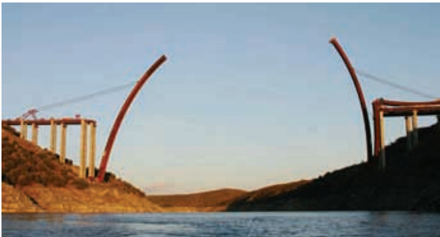
Figura 31. Abatimiento de semiarcos (1). Figure 31. Swivel lowering semi-arches (1).
