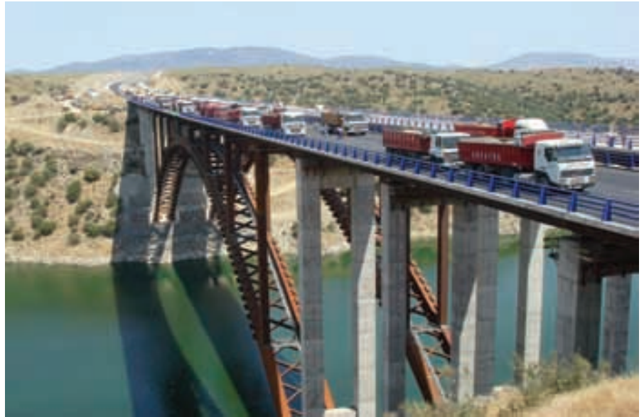
Figura 62. Prueba de carga. Figure 62. Load test.
