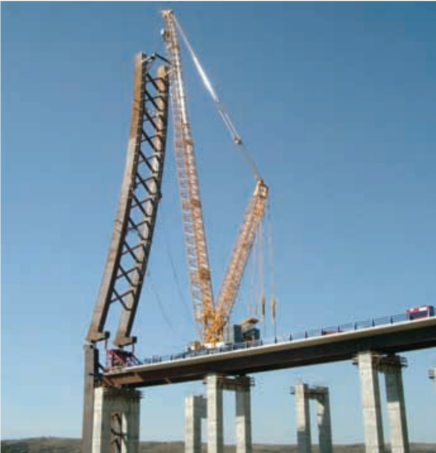
Figura 26. Posición final de izado de tablero con grúa. Figure 26. Final crane deck hoisting position.
