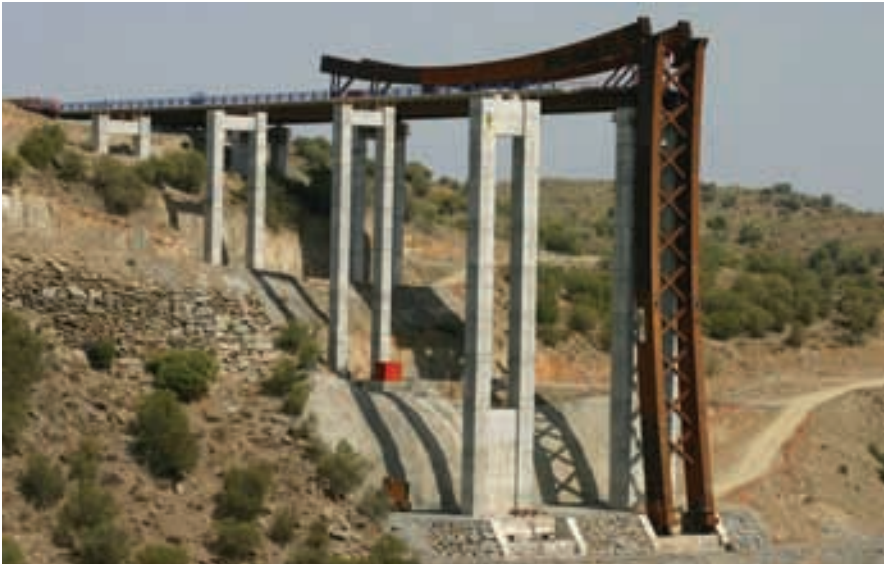
Figura 23. Segundo cuarto de arco conectado en una zona provista de rótulas. Figure 23. Second quarter arch connected in an area provided with hinges.
