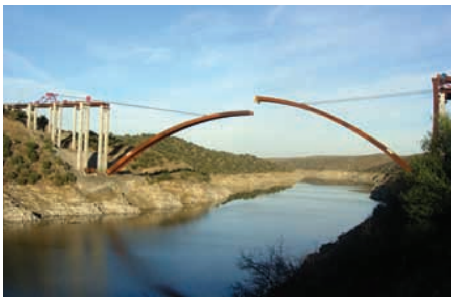
Figura 32. Abatimiento de semiarcos (2). Figure 32. Swivel lowering semi-arches (2).
