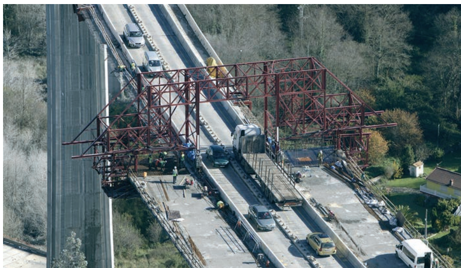
Figura 4. Tráfico por el puente existente durante el proceso de ampliación Figure 4. Temporary diversion of the traffic while widening the deck
