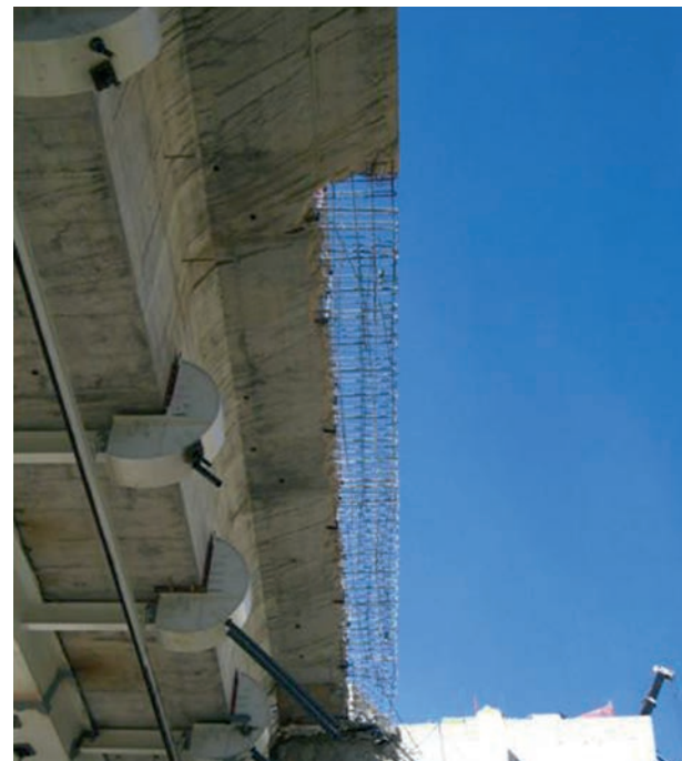
Figura 37. Demolición del último metro de voladizo original
