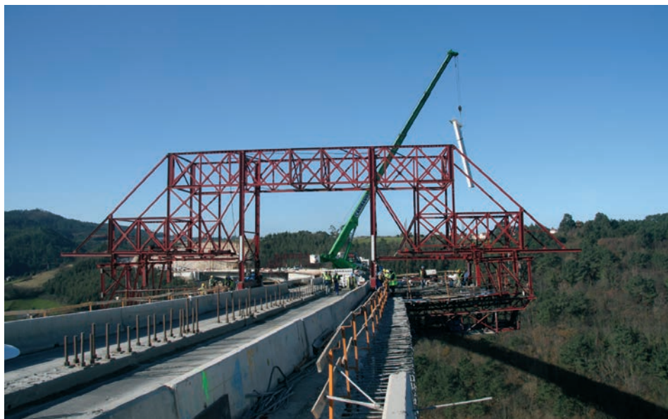
Figura 38. Carro n.º 3 y colocación de un nuevo jabalcón Figure 38. Movable scaffolding n. 3 assembling a steel strut
