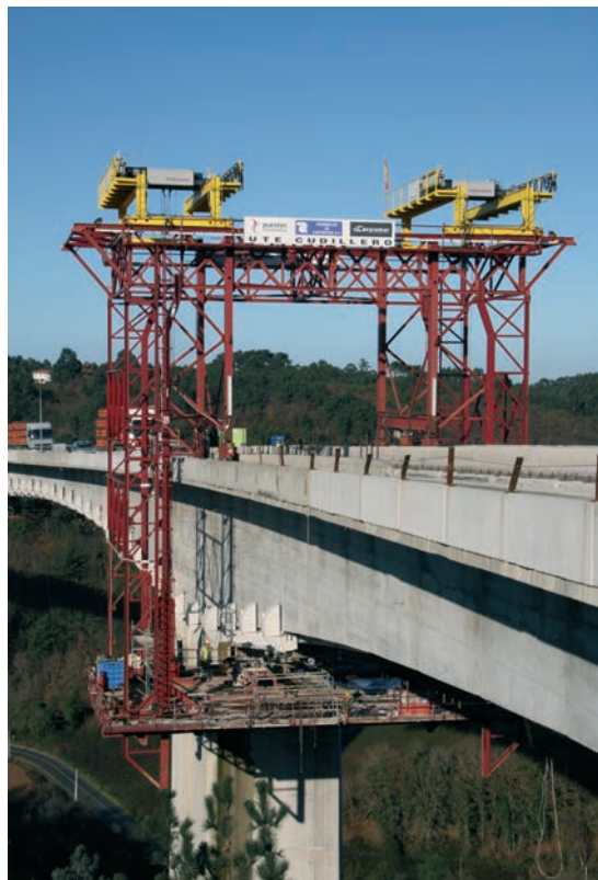
Figura 32. Carro n.º1 Figure 32. Movable scaffolding n. 1
