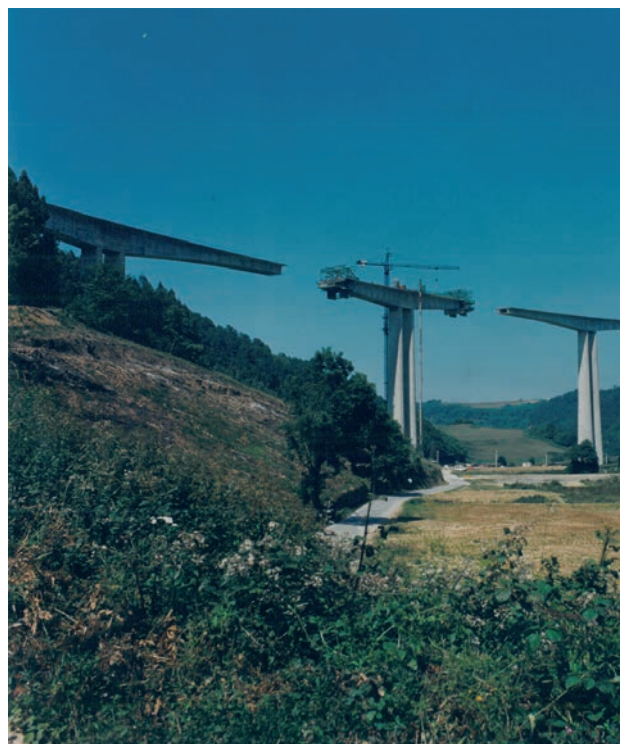
Figura 3. Construcción del viaducto original Figure 3. Construction of the existing bridge
