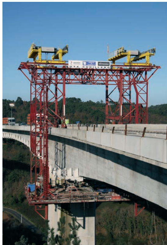
Figura 32. Carro n.º1 Figure 32. Movable scaffolding n. 1
