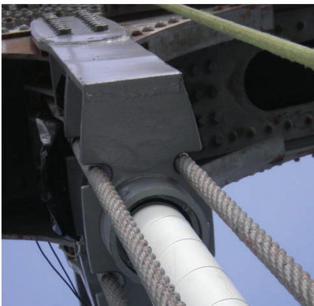
Figura 36. Nueva péndola colocada en la horquilla entre los cables originales Figure 36. New hanger installed in the lifting fork between the original cables
