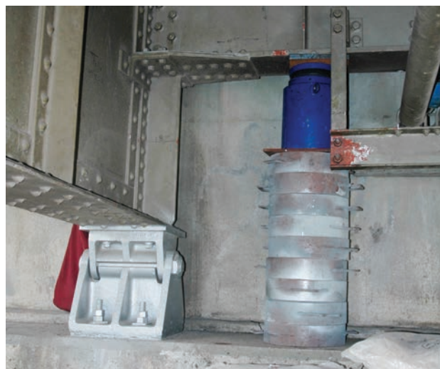
Figura 22. Levantamiento para reparación de apoyo en estribo Figure 22. Lift to repair bearing in abutment
