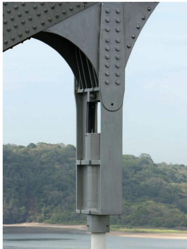
**Figura 26.** Detalle del anclaje superior y la conexión con el arco de la nueva péndola
