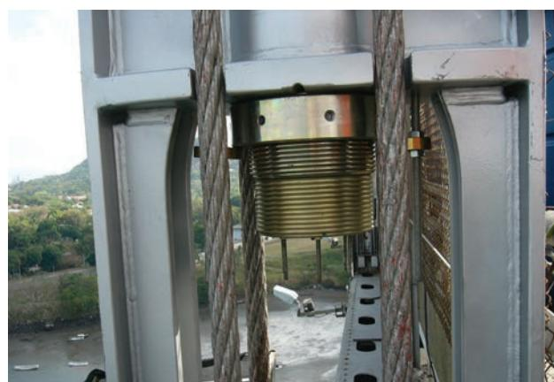
**Figura 28.** Nuevo anclaje inferior con cuñas
