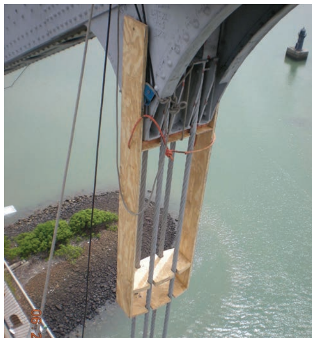
Figura 31. Maqueta de madera de la nueva horquilla Figure 31. Wood model of the new lifting fork
