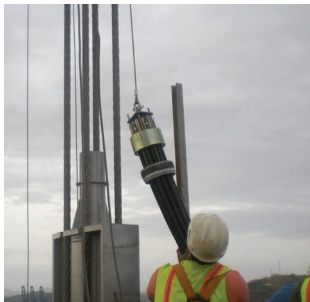
Figura 35. Izado del nuevo tirante H-1000 Figure 35. Raising the new stay cable H-1000
