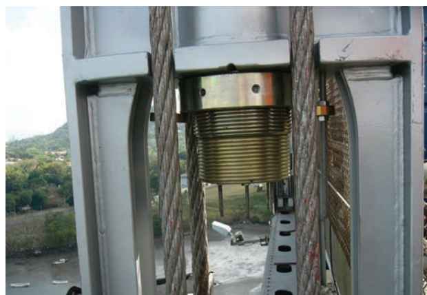
Figura 28. Nuevo anclaje inferior con cuñas Figure 28. New bottom unions equipped with wedges
