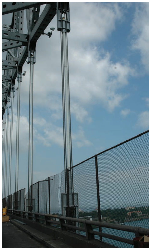
Figura 30. Nueva horquilla y péndola entre los cables originales durante la sustitución
