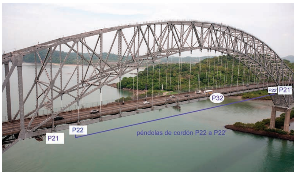
Figura 48. Vista del puente con la numeración de las péndolas extremas y medias Figure 48. View of the bridge with the number of the central and end hangers
