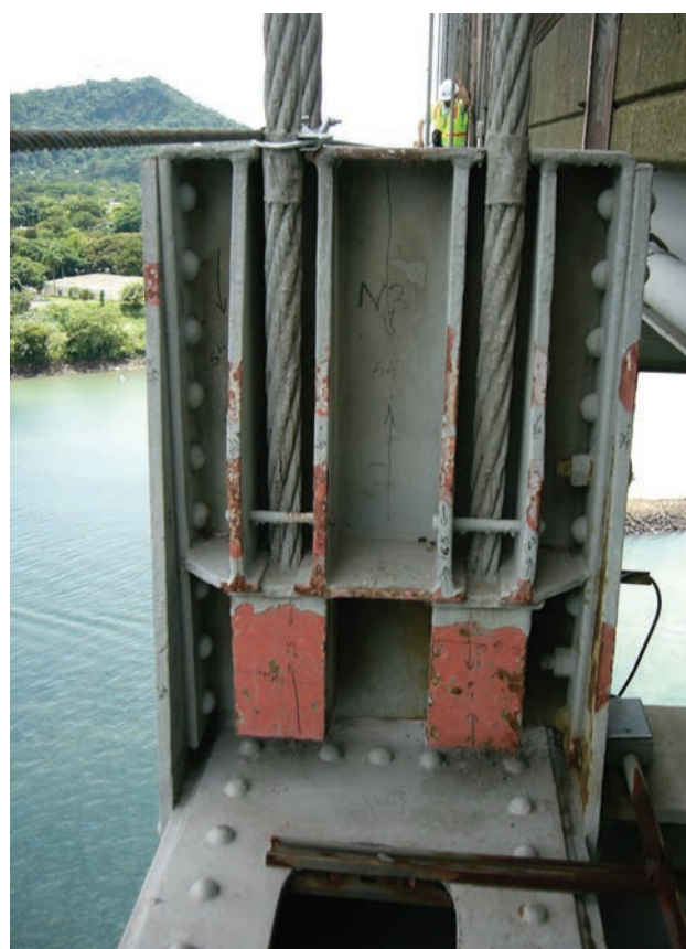
Figura 24. Detalle del anclaje inferior y su unión a la estructura con la péndola antigua
