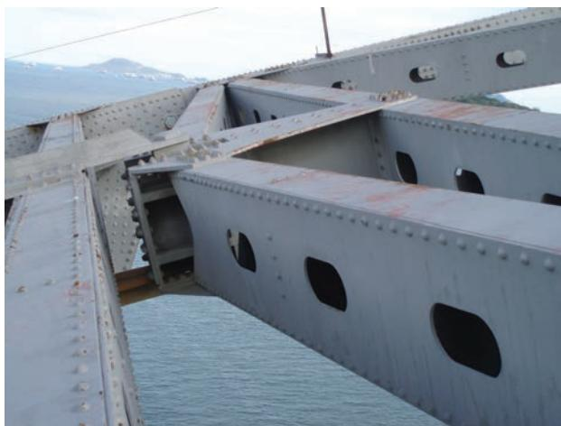
**Figura 12.** Guía deslizadera en plano superior de celosía
