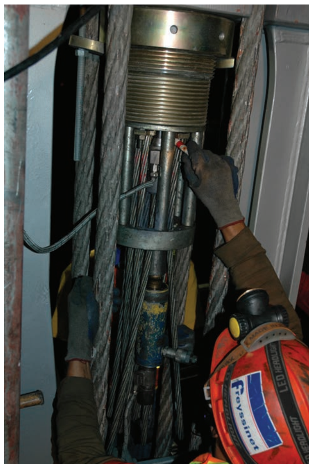
Figura 37. Tesado de las nuevas péndolas cordón a cordón Figure 37. Strand by strand stressing of the new hanger
