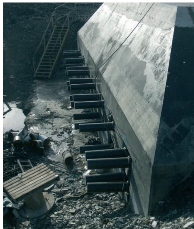
Figura 8. Anclajes del pretensado de la viga de atado Figure 8. Anchorages for the tie beam prestressing
