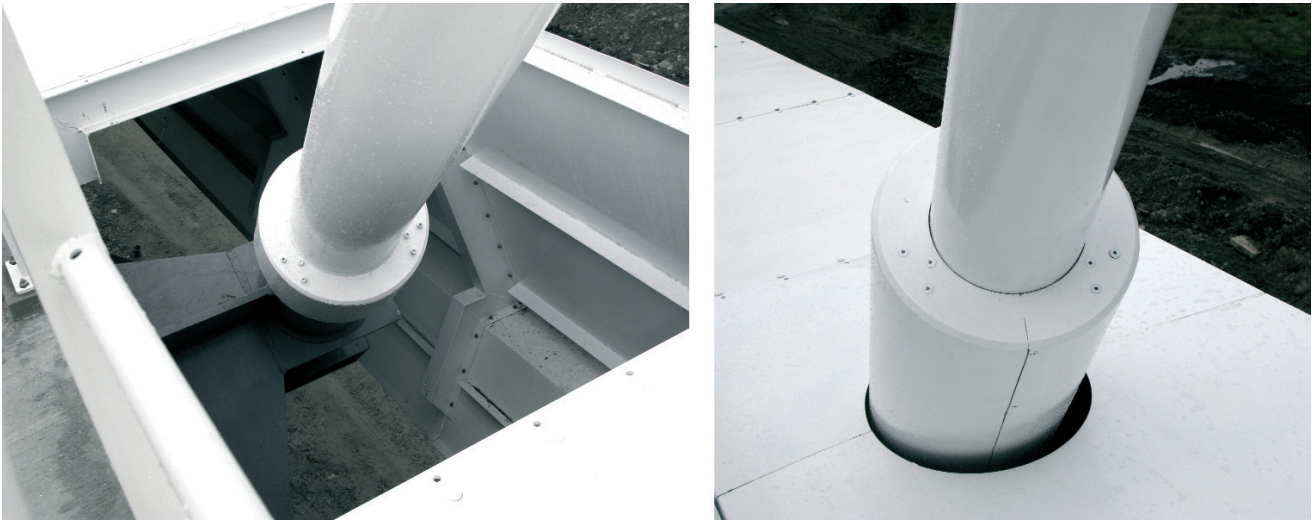
Figura 31. Imposta metálica. Figure 31. Steel fascia beam.
