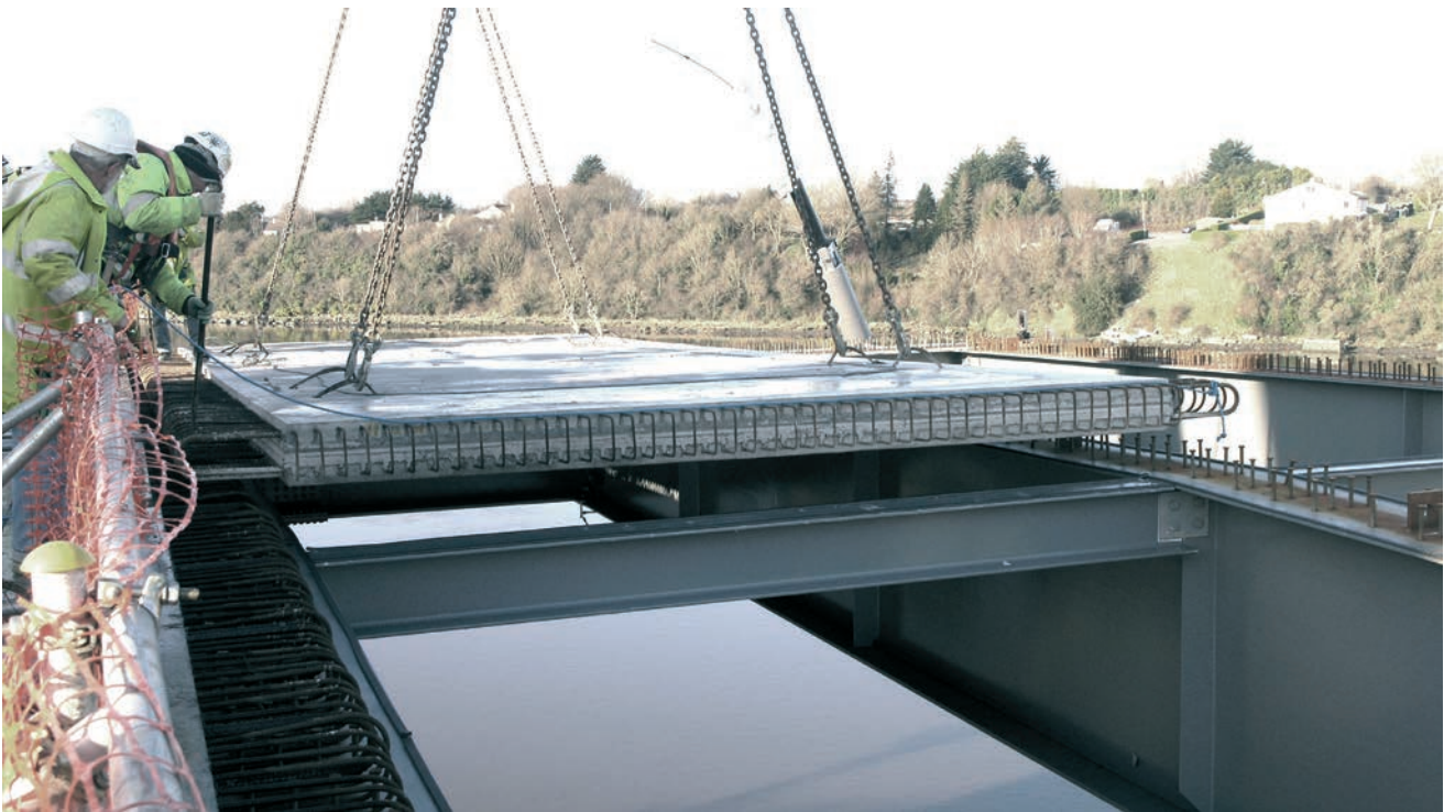
Figura 38. Colocación de losas prefabricadas Figure 38. Installation of precast slabs
