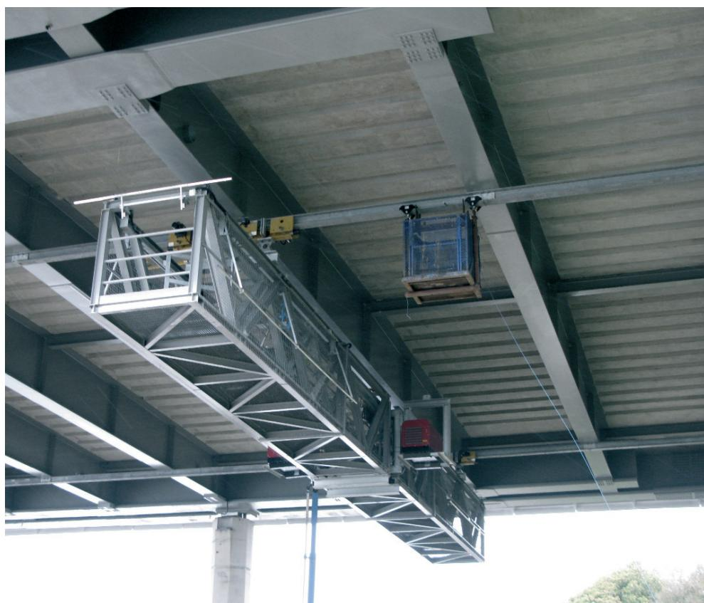
**Figura 35.** Carro de mantenimiento
