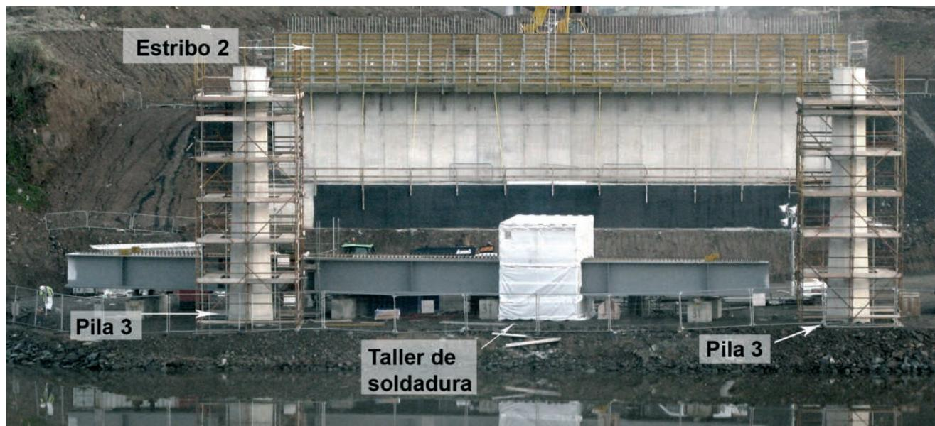
**Figura 18.** Soldadura en obra de tramos de vigas longitudinales
