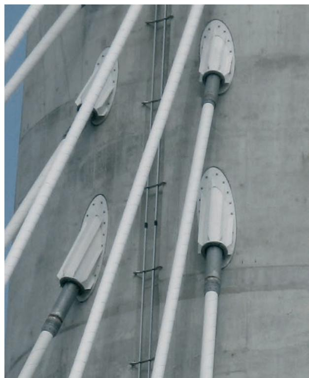
Figura 12. Tubos de tirantes en el exterior de la torre
