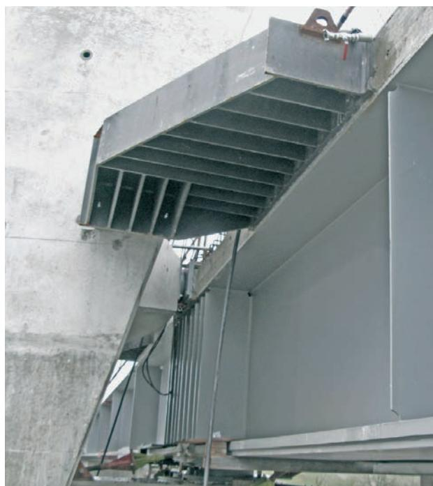
**Figura 28.** Tope de bloqueo del tablero en la torre
