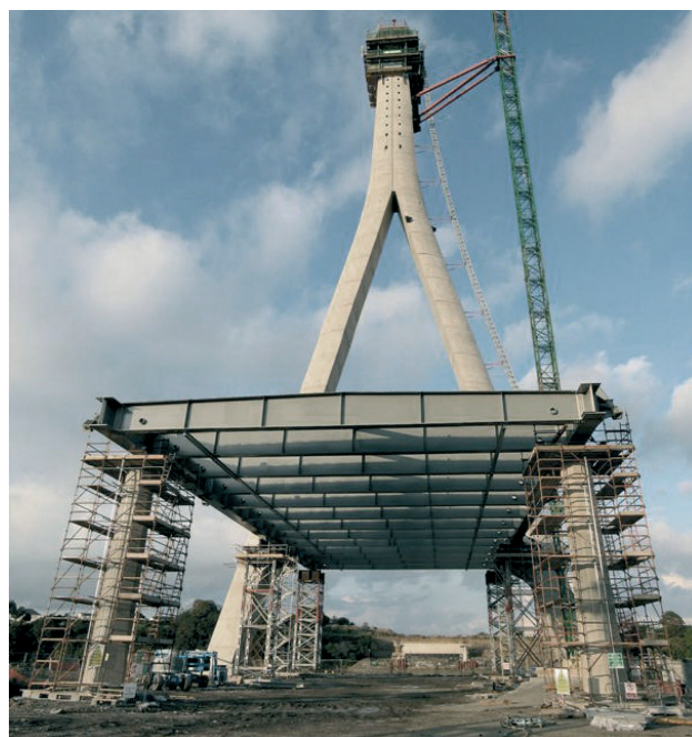
Figura 36. Montaje de estructura metálica en vanos traseros. Figure 36. Installation of steel structure in back spans.
