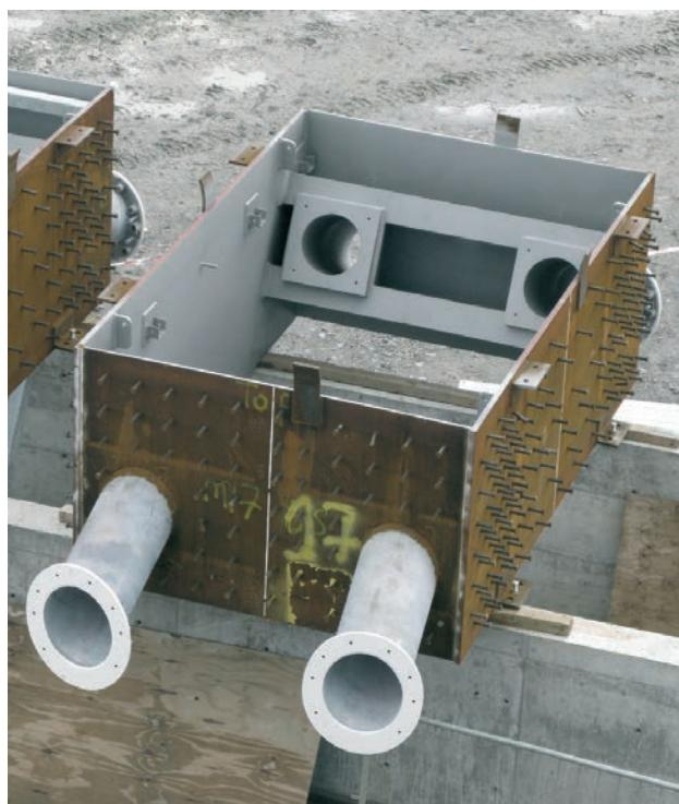
Figura 10. Cajón de anclaje de tirantes en torre
