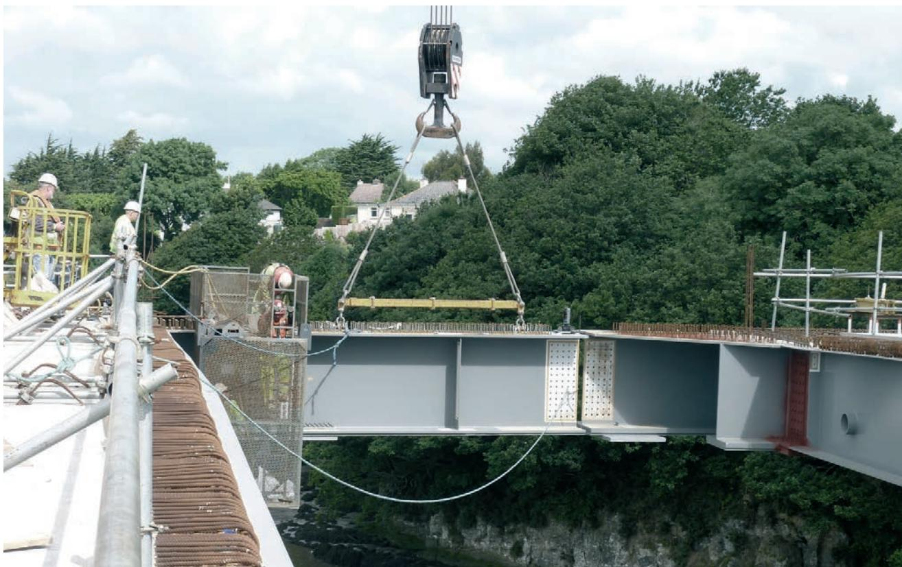
**Figura 40.** Colocación del tramo de cierre del vano.
