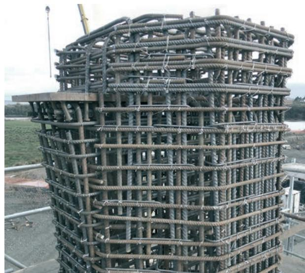
**Figura 15.** Armado de la cabeza de una pila
