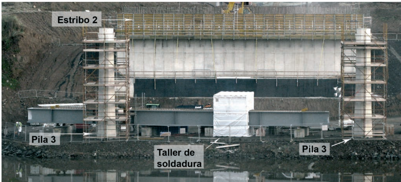
Figura 18. Soldadura en obra de tramos de vigas longitudinales Figure 18. On site edge girder segments welding
