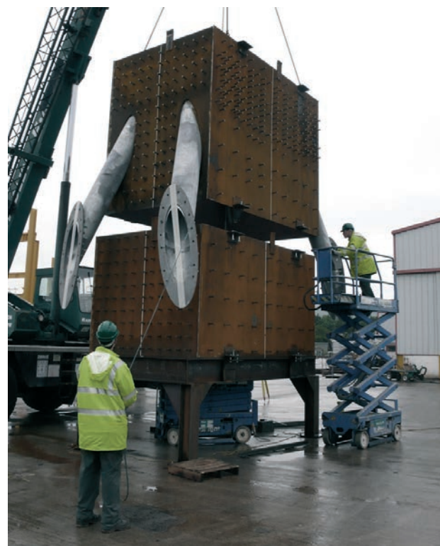
Figura 11. Montaje en blanco de cajones en taller Figure 11. Trial assembly of the boxes at workshop
