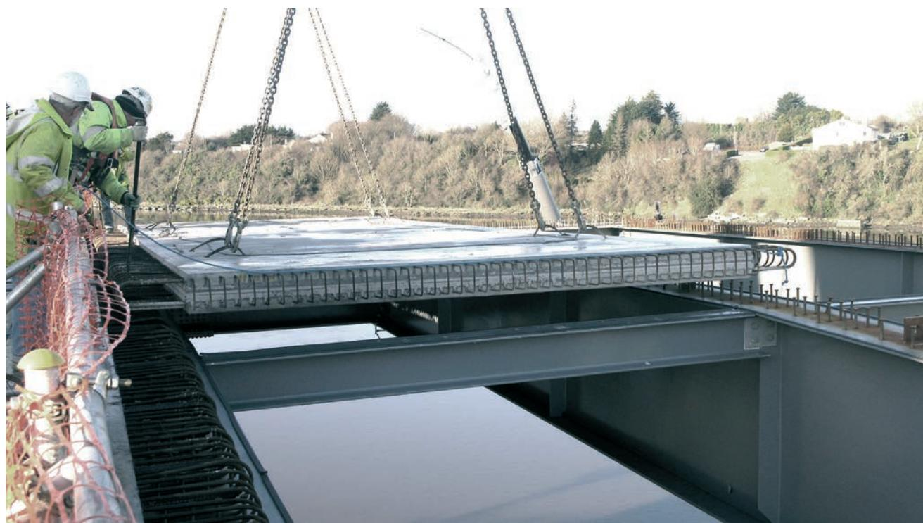
**Figura 38.** Colocación de losas prefabricadas
