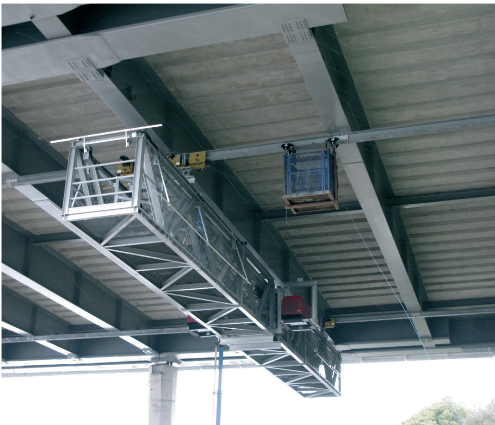
Figura 35. Carro de mantenimiento Figure 35. Maintenance gantry
