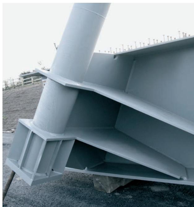
**Figura 20.** Anclaje de un tirante en el tablero
