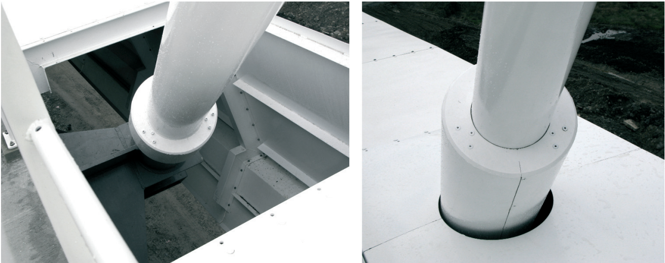
Figura 31. Imposta metálica. Figure 31. Steel fascia beam.
