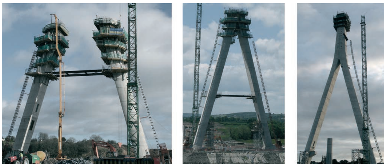
Figura 13. Distintas fases de construcción de la torre Figure 13. Different stages in the construction of the pylon
