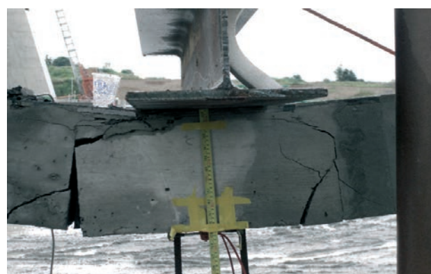
Figura 27. Junta entre losas prefabricadas después del ensayo. Figure 27. Joint between precast slabs after the test.
