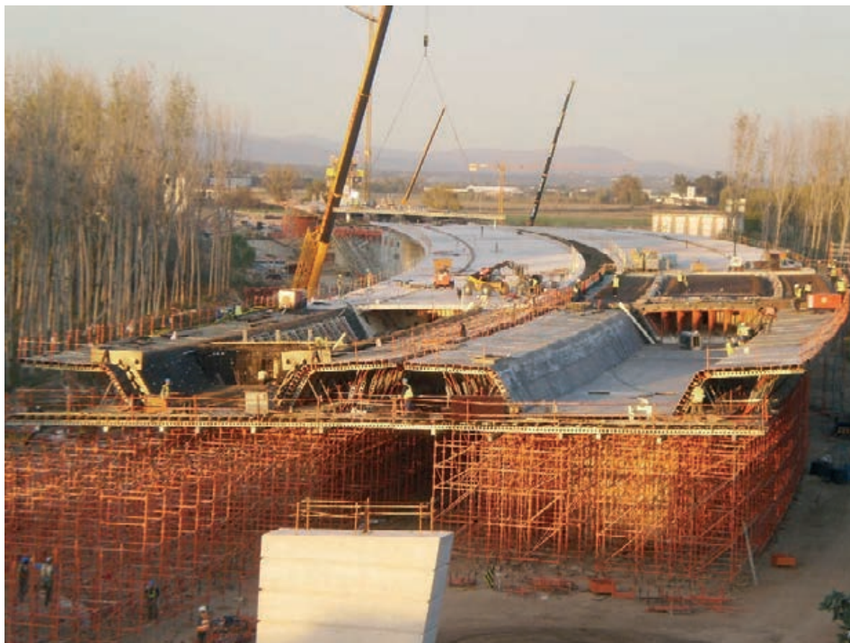
Figura 37. Frente de avance de los tableros gemelos del viaducto. Construcción por vanos sucesivos Figure 37. Construction front for the twin decks on the viaduct: span-by-span construction
