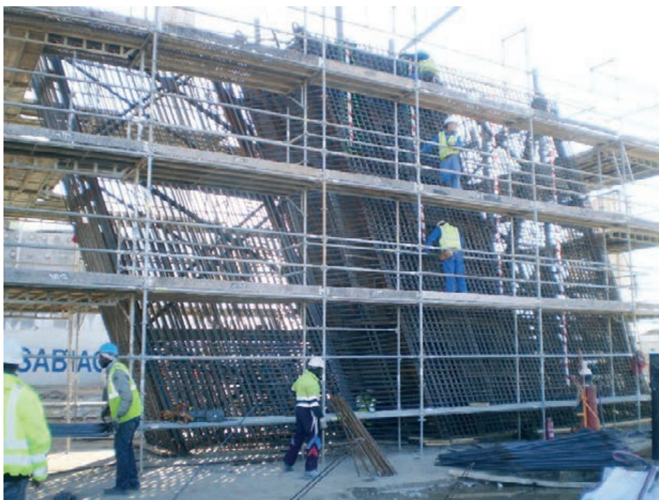
Figura 40. Célula metálica y ejecución de ferrallado a nivel de suelo para su posterior izado Figure 40. Steel cage and ground level assembly of reinforcement for subsequent hoisting
