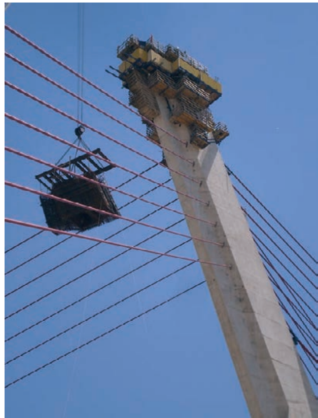
Figura 22. Izado de tramo de célula entre tirantes de retenida Figure 22. Hoisting section of cage between back stays
