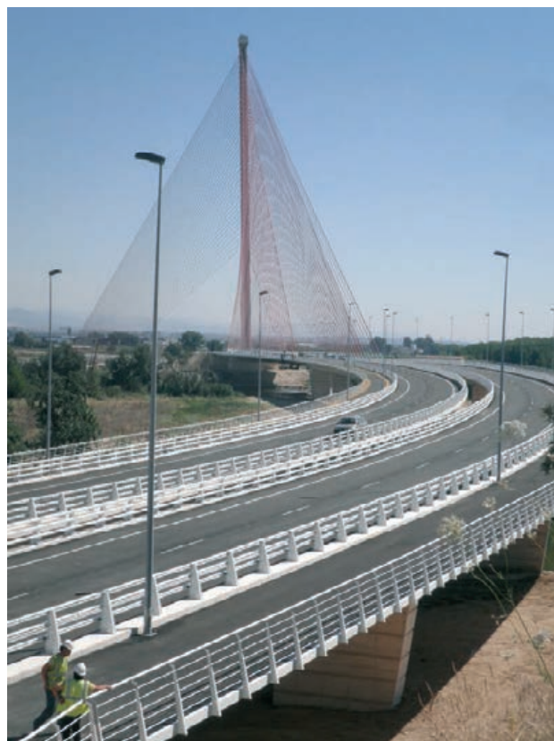
Figura 17. Vista del puente atirantado desde el viaducto curvo de acceso
