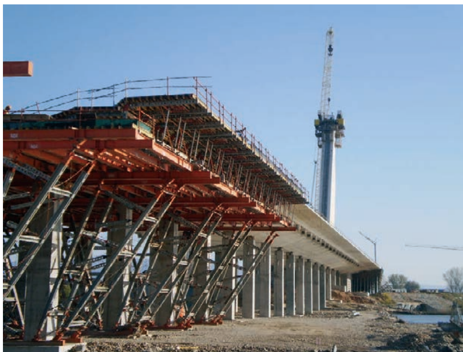
Figura 38. Frente de avance de tablero con ejecución simultánea de pylon Figure 38. Deck construction front and simultaneous erection of pylon
