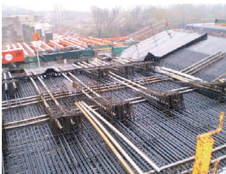
Figura 7. Colocación de vainas de pretensado longitudinal en el último tercio del tablero
