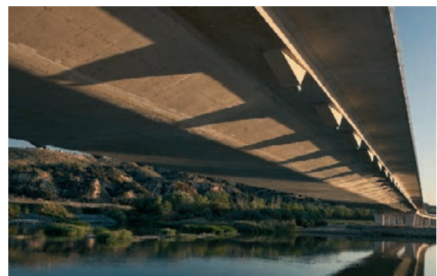
Figura 10. Vista inferior del tablero terminado. Al fondo, la pila P1 y el viaducto de acceso Figure 10. Finished bridge soffit with pier P-1 and the approach viaduct in the background
