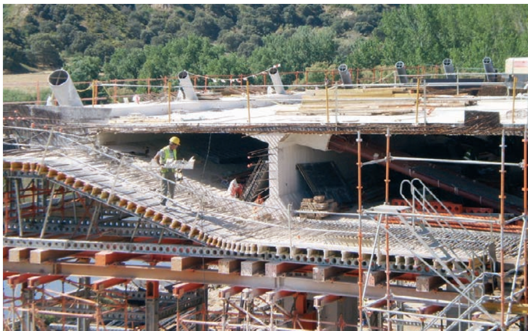
Figura 5. Diagonales del diafragma colocadas en hueco rectangular de la sección Figure 5. Diaphragm diagonals in the rectangular space in the cross-section
