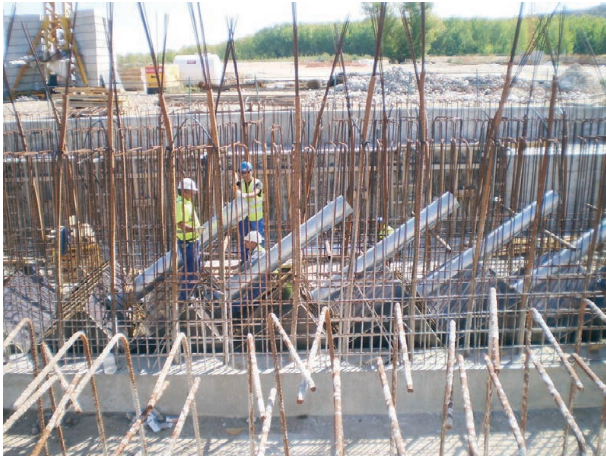
Figura 30. Salida de tubos guía de los muertos de anclaje Figure 30. Guide tubes protruding from anchorage blocks
