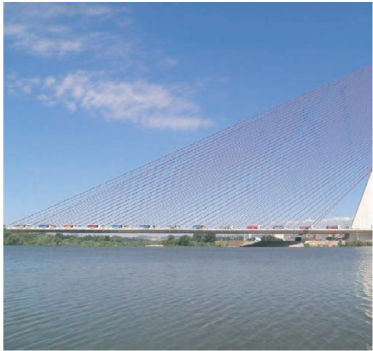
Figura 44. Prueba de carga Figure 44. Load trial
