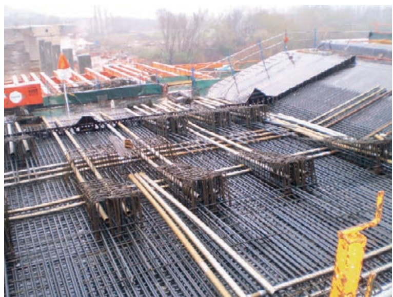
Figura 7. Colocación de vainas de pretensado longitudinal en el último tercio del tablero
