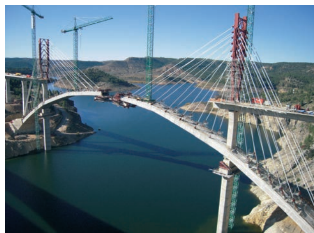
Figura 19. Construcción en avance en voladizo atirantado Figure 19. Cable-stayed free cantilever launching
