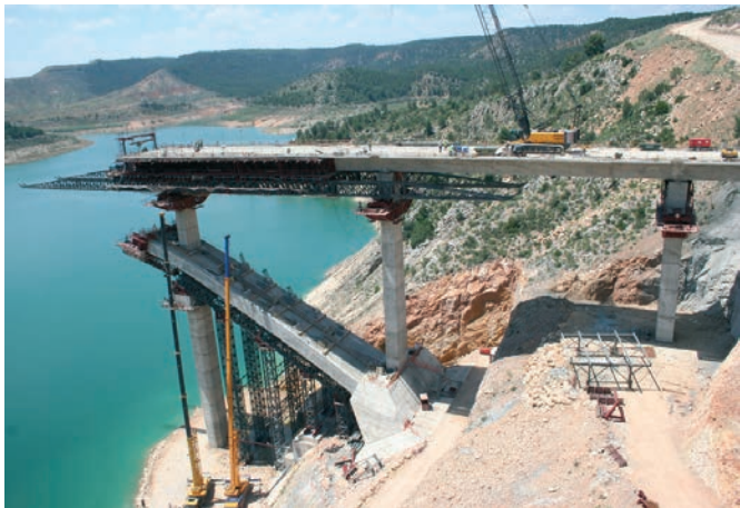
Primer tramo de arco apeado First stretch of the temporarily supported arch
