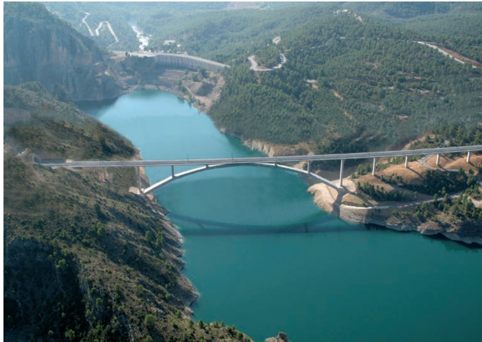
Figura 4. Vista del puente arco construido sobre el embalse de Contreras (se ha eliminado la Autopista)
