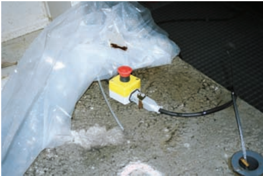
Fig. 35. Vista del sistema de parada en cada pila (Seta). Fig. 35. View of the stop system at each pier (Mushroom).
