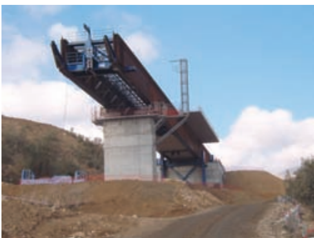
Fig. 19. Vista frontal de los patines de empuje. Fig. 19. Front view of the launching skids
