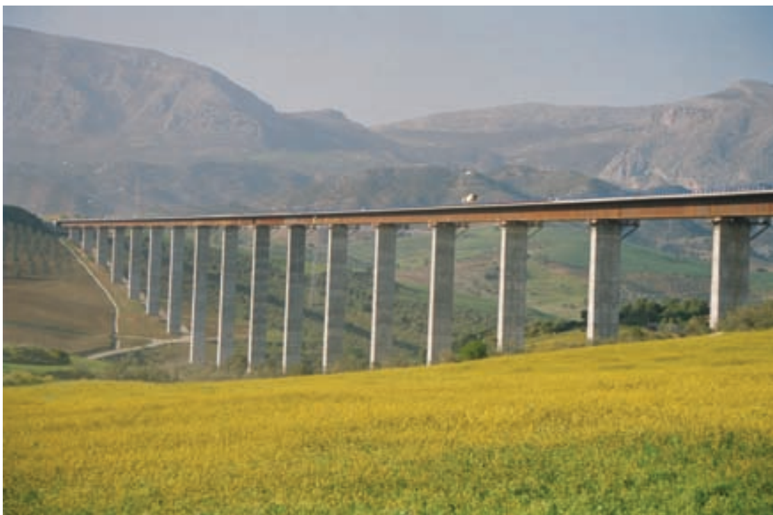
Fig. 1b. Vista del puente. Fig. 1b. View of the bridge.
