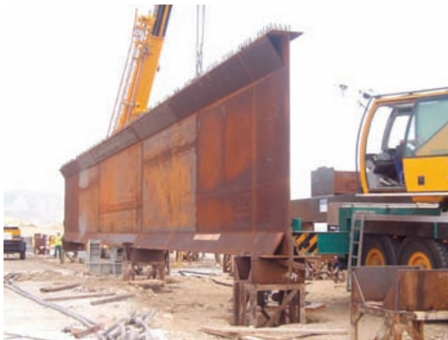
Fig. 9. Transporte y colocación de una viga metálica. Fig. 9. Transporting and placing a metal girder.
