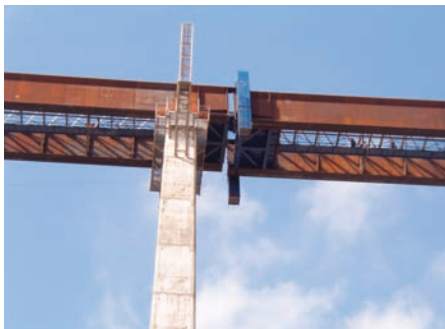
Fig. 24. Vista inferior del instante de unión de tramos. Fig. 24. Underneath view of the moment when stretches connected.
