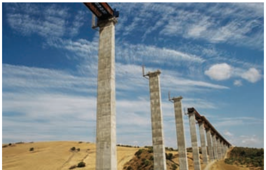
Fig. 22. Vista inferior del viaducto durante el empuje desde los dos estribos Fig. 22. View of the underneath of the viaduct during launching from the two abutments
