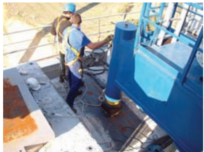
Fig. 20. Detalle del gato frontal y el gato en la nariz Fig. 20. Detail of the front jack and the nose jack.
