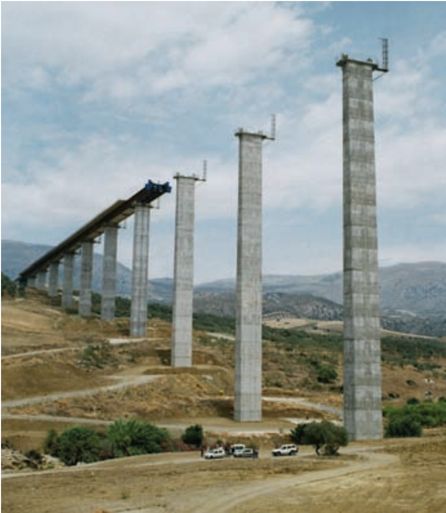
Fig. 2. Vista de las pilas durante el empuje del tablero. Fig. 2. View of the piers during deck launching .
