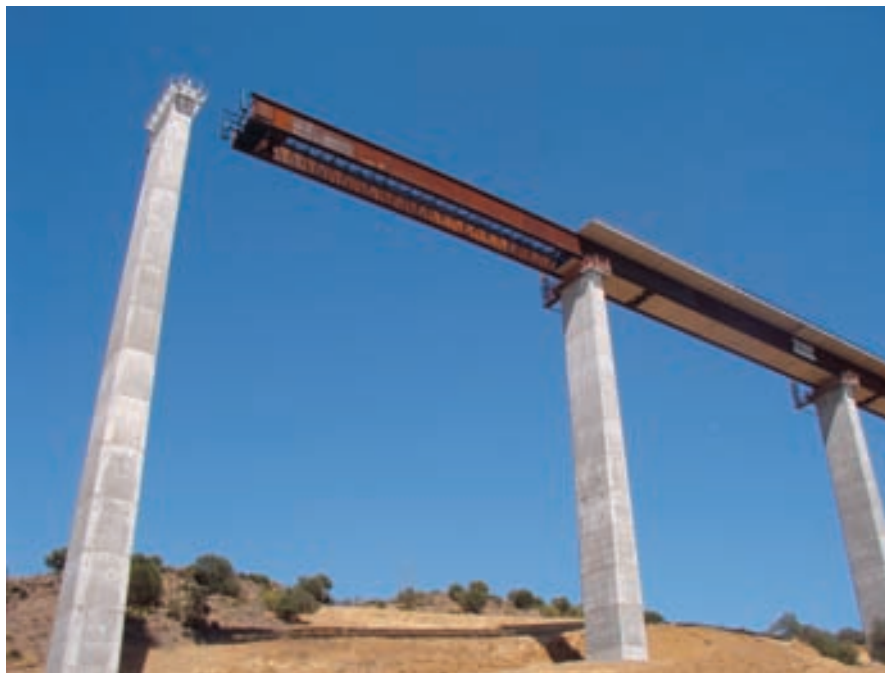
Fig. 23. Vista del voladizo antes de llegar a pila durante el empuje. Fig. 23. View of the cantilever before reaching a pier during launching.
