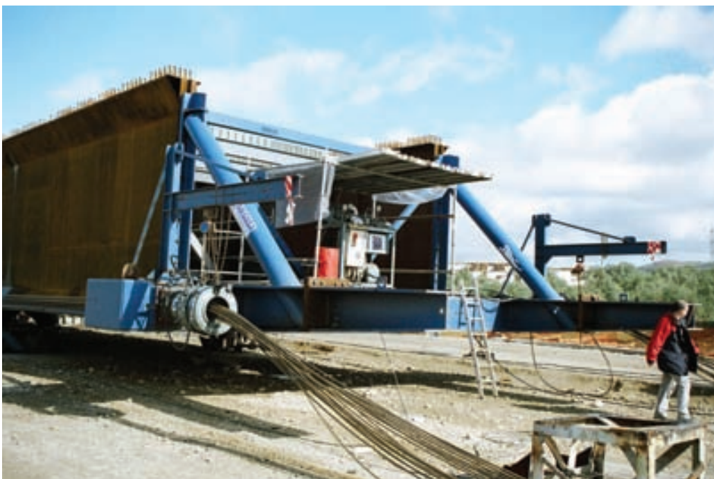
Fig. 17. Detalle de la estructura auxiliar de empuje y los cables y gatos de empuje. Fig. 17. Detail of the auxiliary launching structure and the launching cables and jacks
