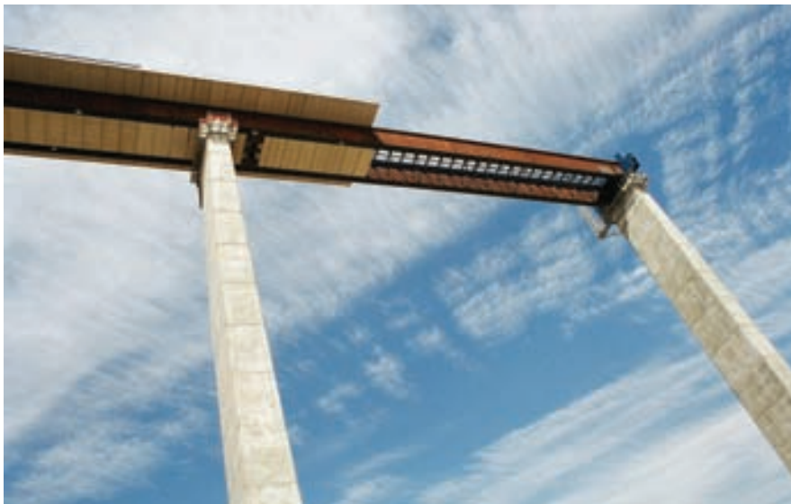
Fig. 14. Vista del primer vano sin prelasas superiores ni inferiores durante el empuje. Fig. 14. View of the first span with no top or bottom pre-slabs during launching
