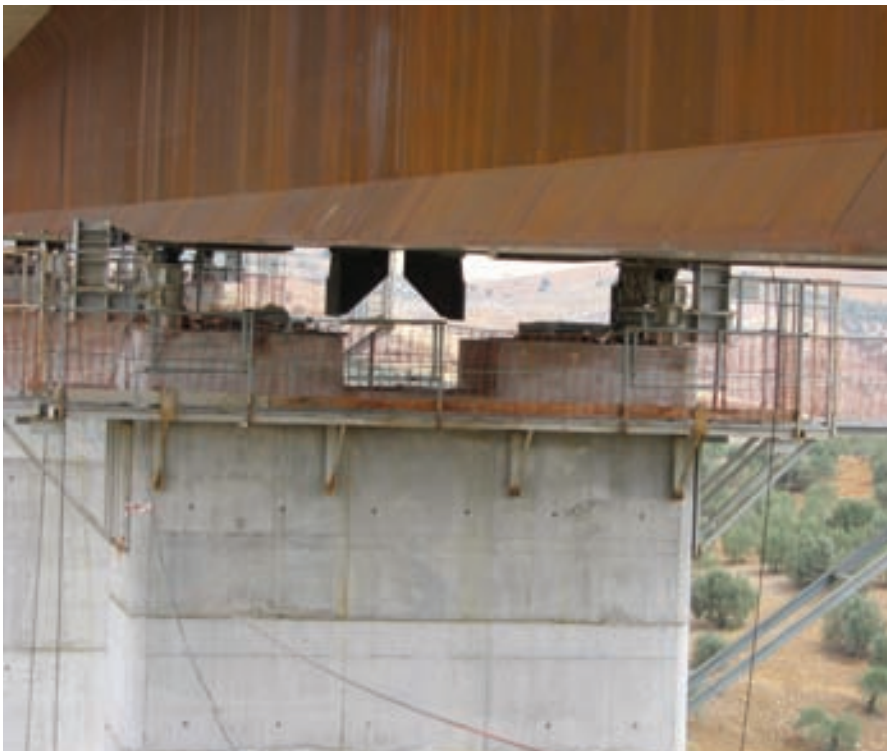
Fig 37. Detail of anti-seismic stops on pier heads. Fig. 37. Detalle de los topes antisismo en cabeza de pilas.
