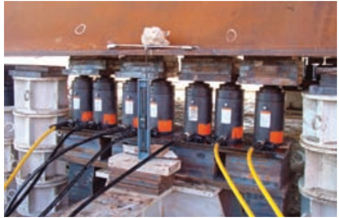
Fig. 30. Aplicación reacción localizada con gatos. Fig. 30. Localised reaction application with jacks.
