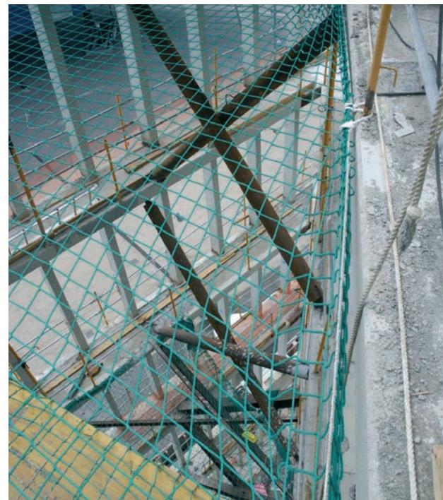
**Figura 30.** Arriostramiento provisional capa interior fachada en patio
