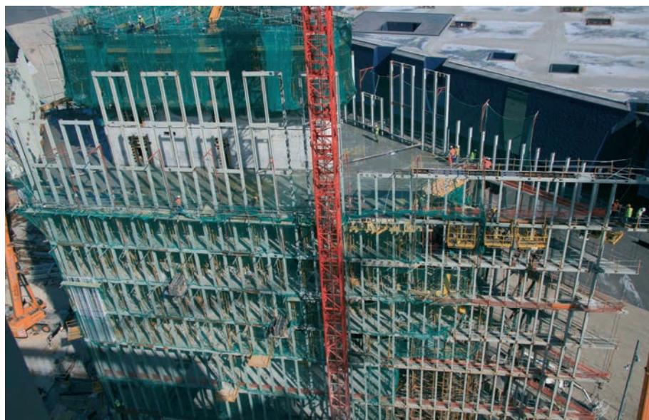
**Figura 29.** Construcción de la capa interior de fachada mediante módulos (vista desde el Hotel Diagonal Zero)
