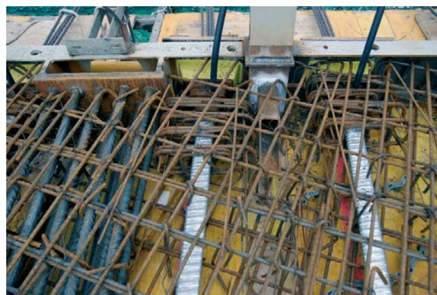
Figura 14. Apoyo de losa postesada en soportes mediante tubos
