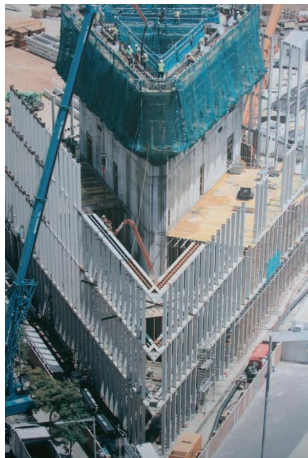
Figura 7. Avance de fachada y núcleo
