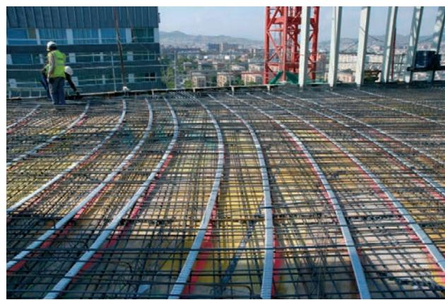
**Figura 11.** Cables de postesado con trazado curvo en planta
