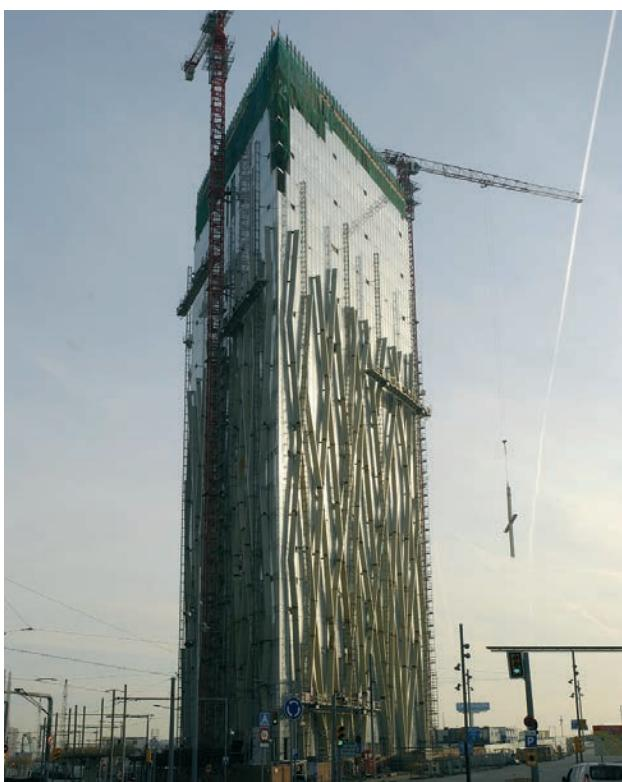
**Figura 31.** Elevación nudo mediante grúa torre
