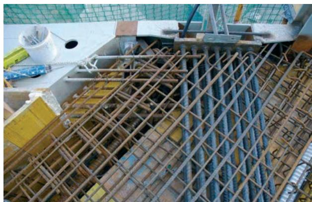
**Figura 26.** Detalle del encuentro entre viga descolgada postesada, viga de patio y cajetín de recepción de un bambú
