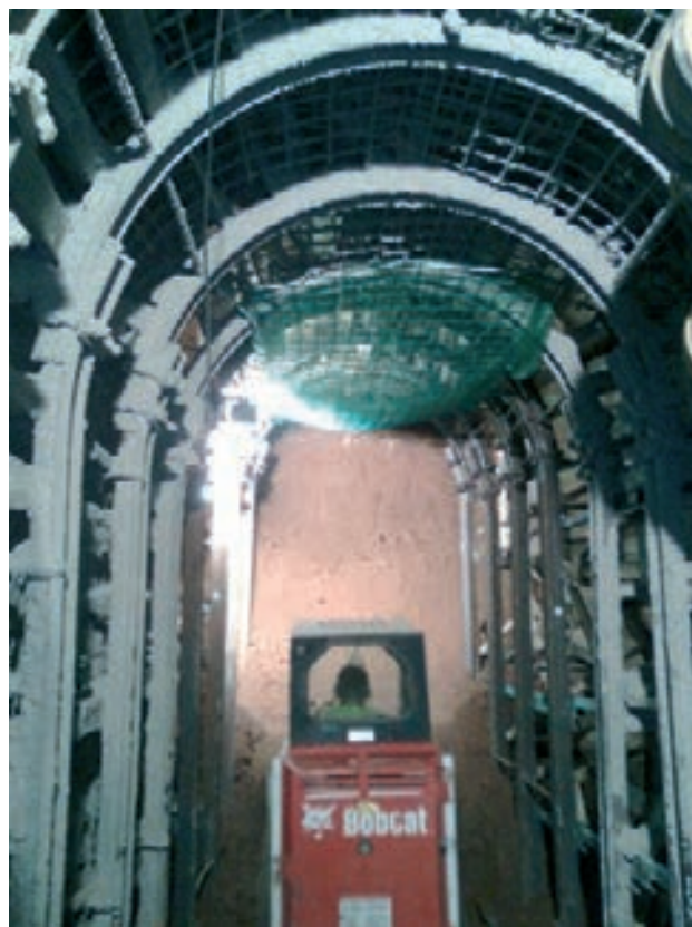
Figura 11. Ejecución de la galería
