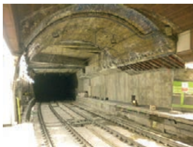
Figura 21. Vista de la ampliación del andén lado Sur
