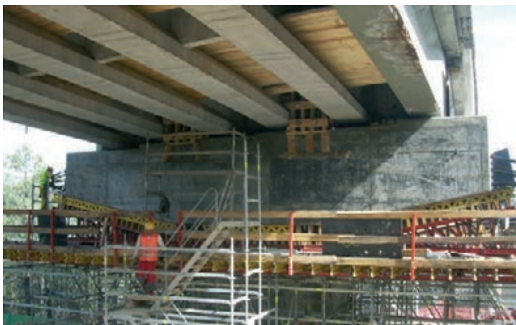
Figura 33. Hormigonado de dinteles y vigas de cuelgue
