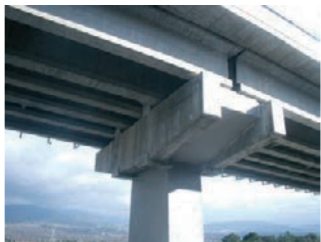
Figura 45. Dintel rehabilitado y ampliado, en servicio
