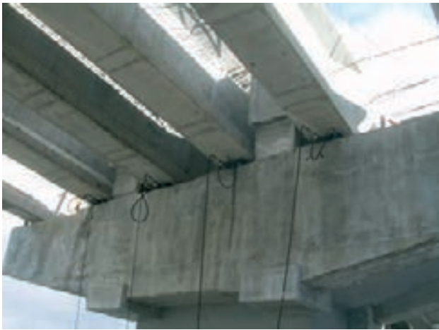
Figura 41. Sustrucción de apoyos existentes
