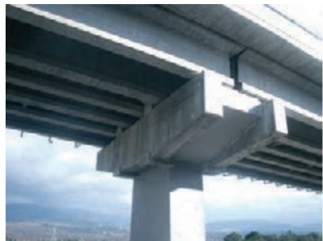
Figura 45. Dintel rehabilitado y ampliado, en servicio
