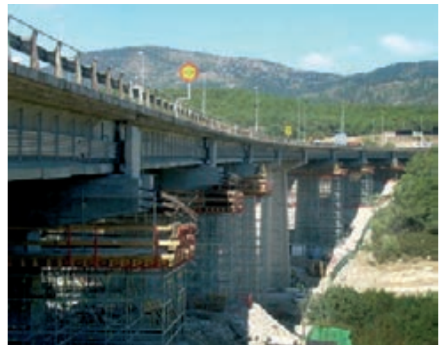
Figura 30. Vista general con las cimbras ya montadas
