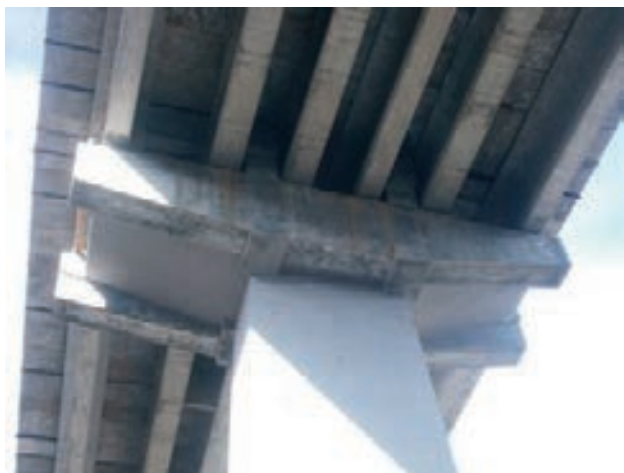
Figura 46. Vista inferior del dintel
