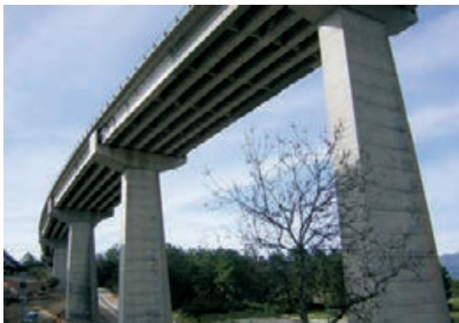
Figura 2. Viaducto de La Jarosa (calzada sentido La Coruña) antes de la intervención
