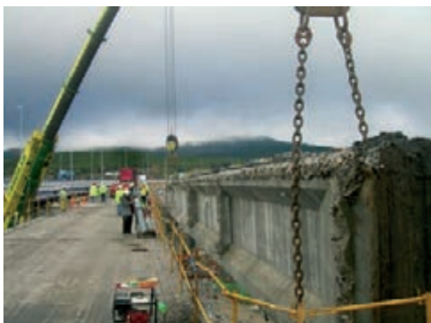
Figura 39. Retirada de vigas dañadas
