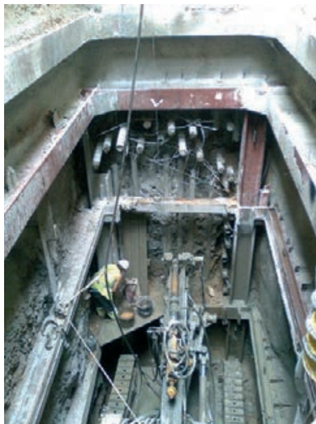
Figura 10. Ejecución del paraguas de micropilotes
