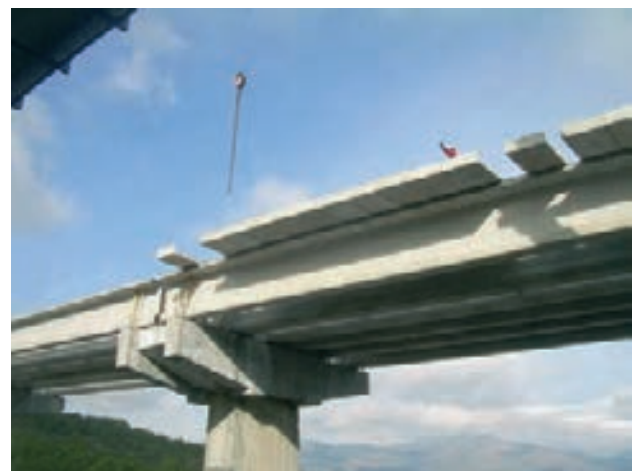
Figura 44. Colocación de prelosas: vista desde abajo
