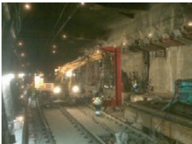
Figura 18. Colocación de la estructura metálica en C
