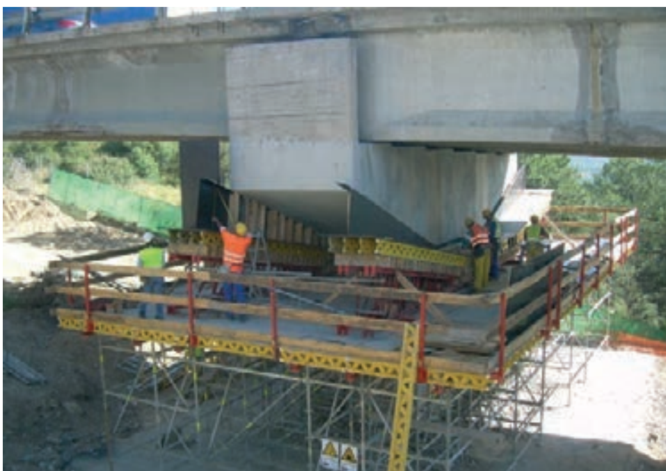
Figura 31. Encofrado de nuevos dinteles
