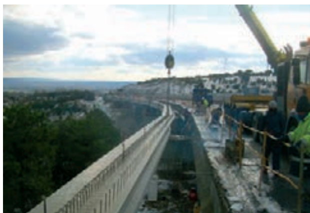
Figura 40. Colocación de vigas nuevas
