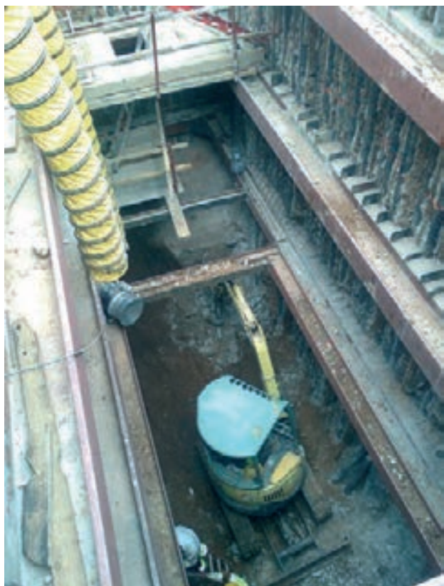
Figura 8. Excavación del pozo de ataque
