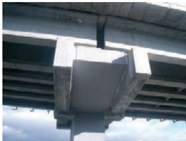
Figura 47. Vista lateral donde se aprecian los porexpanes de separación entre dintel antiguo y dinteles nuevos
