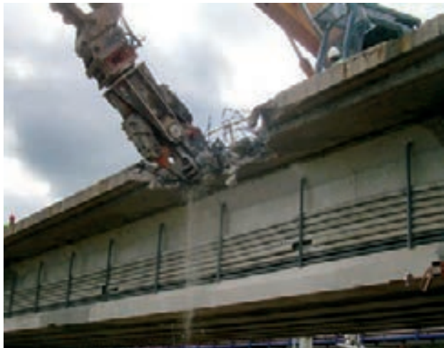
Figura 36. Demolición de losa existente: aceras y voladizos
