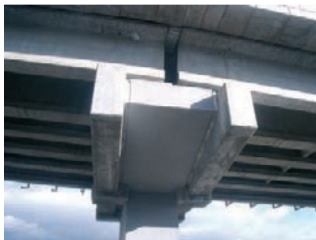
Figura 47. Vista lateral donde se aprecian los porexpanes de separación entre dintel antiguo y dinteles nuevos
