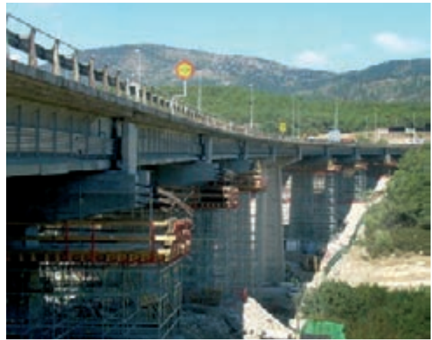
Figura 30. Vista general con las cimbras ya montadas
