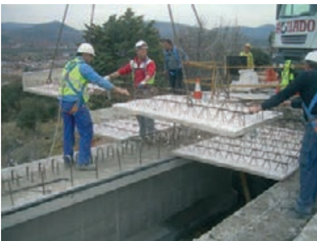
Figura 43. Colocación de prelosas: vista desde tablero
