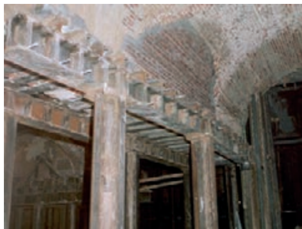
Figura 7. Muros sobre emparrillados metálicos
