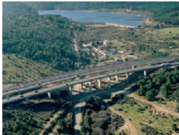
Figura 3. Viaductos de La Jarosa (3 calzadas separadas) antes de la intervención. De abajo a arriba: calzada sentido La Coruña, calzada reversible y calzada sentido Madrid
