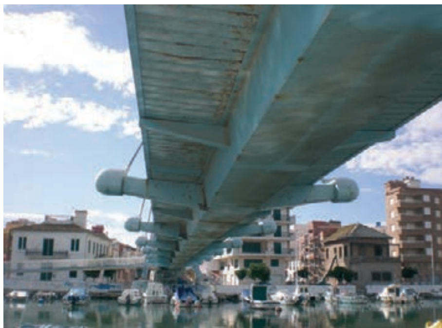
Figura 4. Aspecto en 2010 del tablero
