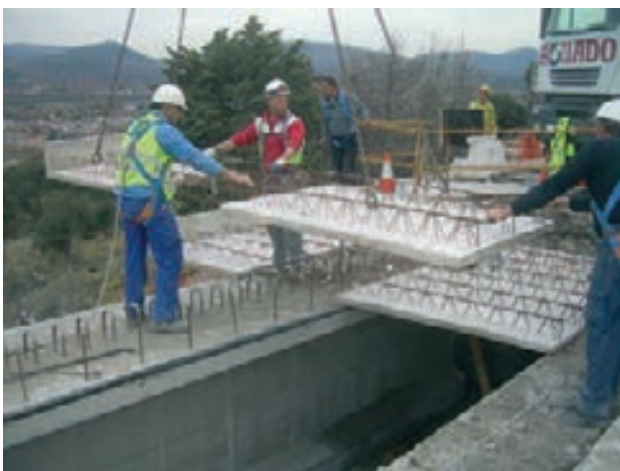
Figura 43. Colocación de prelosas: vista desde tablero
