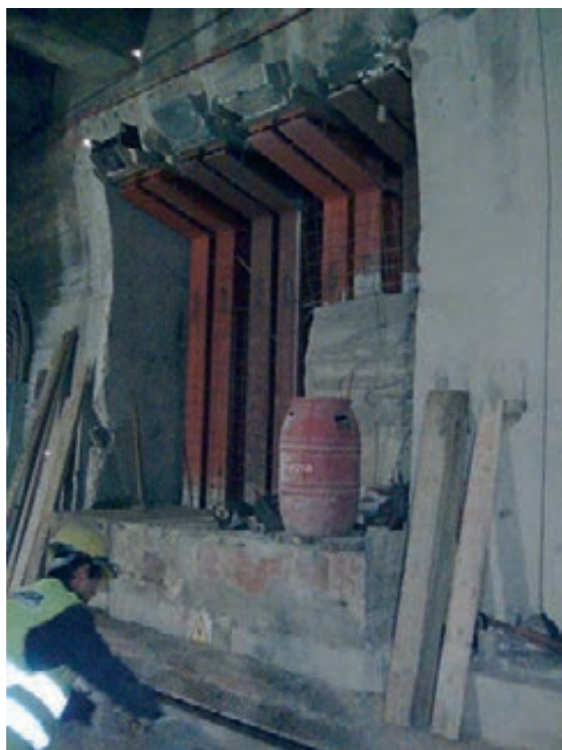
Figura 19. Hormigonado del hastial
