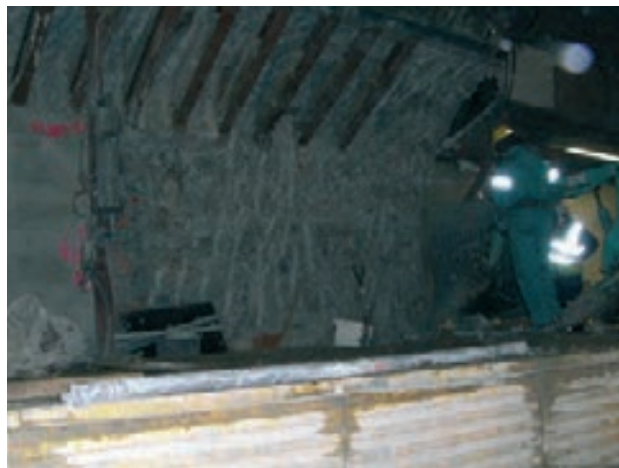
Figura 13. Vista de las cartelas y demolición del hastial
