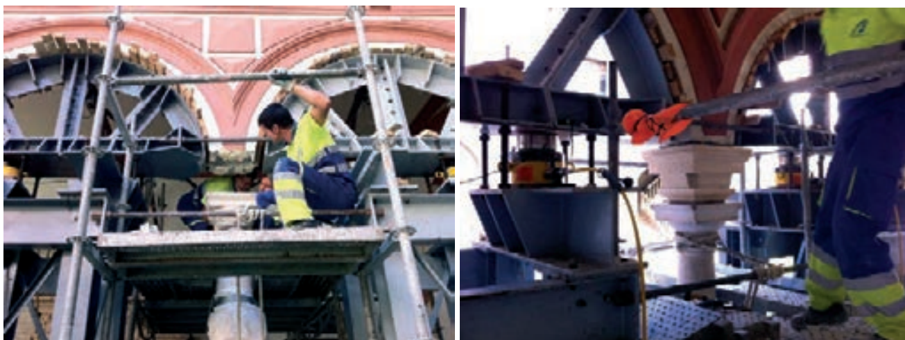
Figura 9. Momento en que se ha retirado el cimacio 19. A la derecha la pieza nueva en posición y aplomada.
