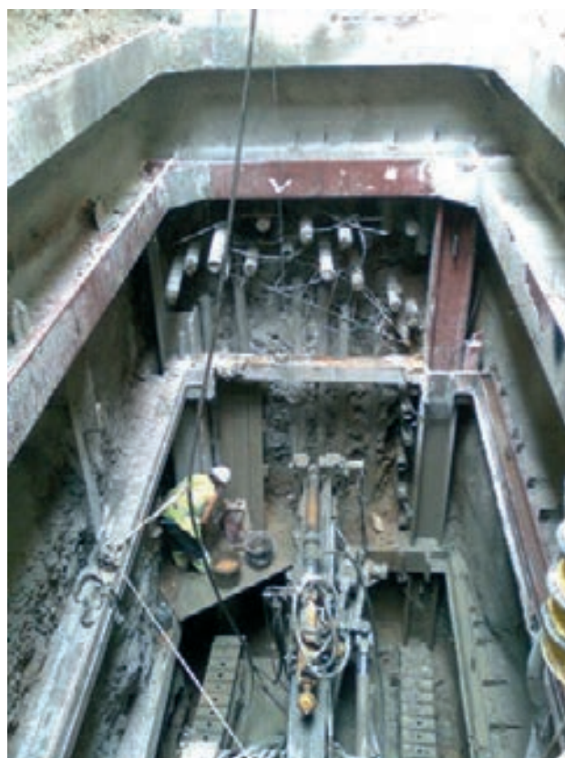
Figura 10. Ejecución del paraguas de micropilotes
