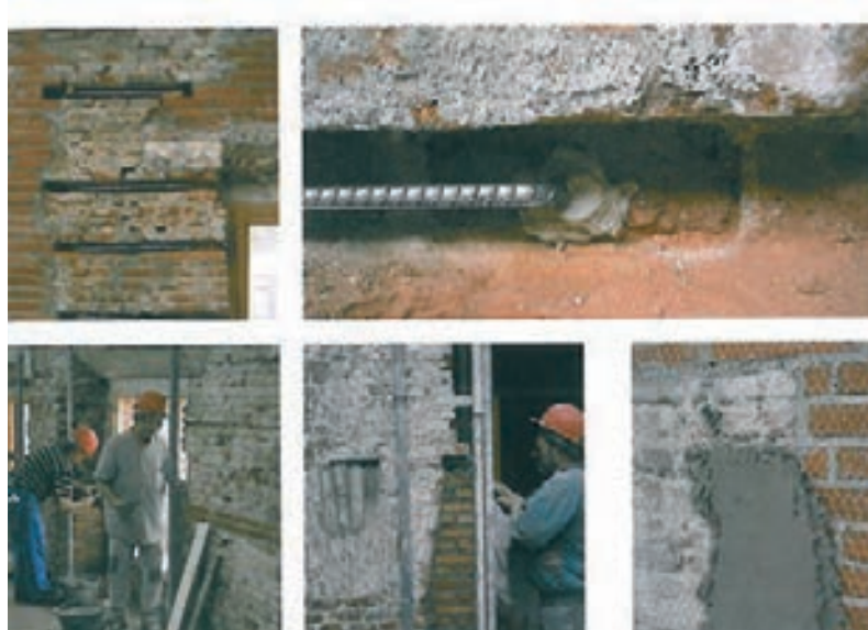
Figura 4. Consolidación de muros
