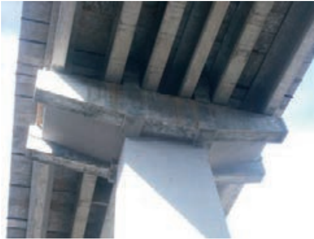
Figura 46. Vista inferior del dintel
