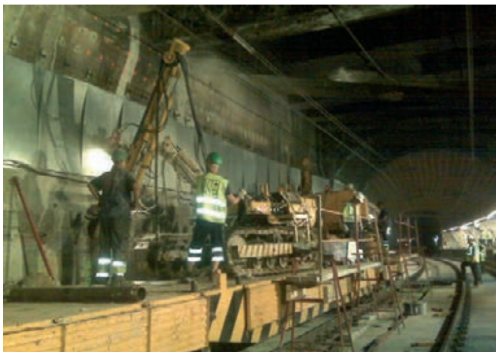
Figura 16. Ejecución de los micropilotes desde la plataforma de trabajo
