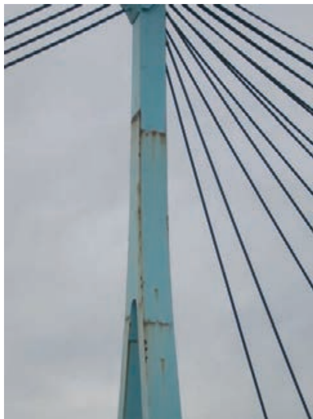
Figura 3. Aspecto en 2010 del pilono
