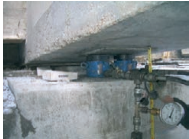
Figura 42. Gatos para la sustitución de apoyos
