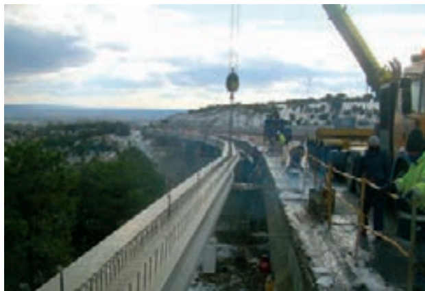
Figura 40. Colocación de vigas nuevas
