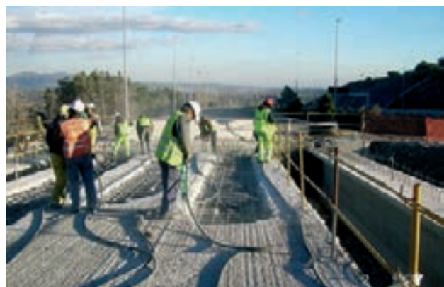
Figura 37. Demolición de losa existente: zona central
