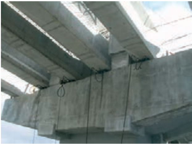
Figura 41. Sustrucción de apoyos existentes
