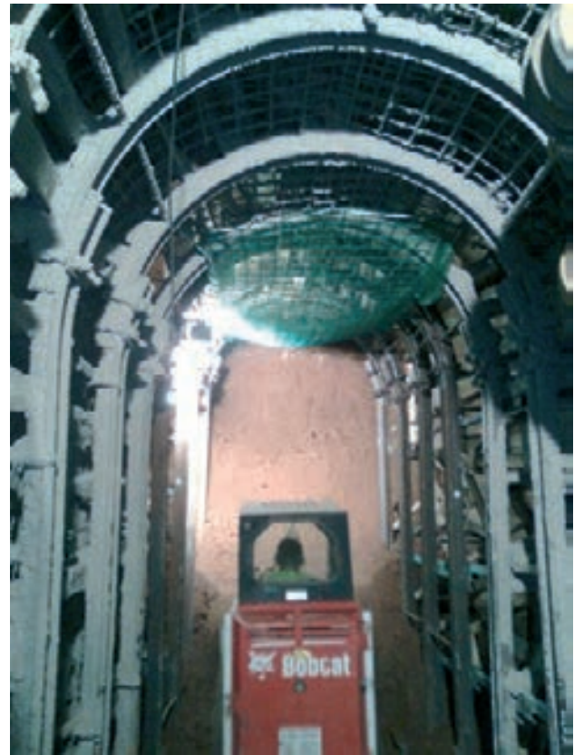
Figura 11. Ejecución de la galería
