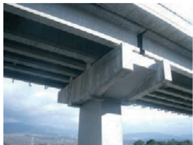
Figura 45. Dintel rehabilitado y ampliado, en servicio
