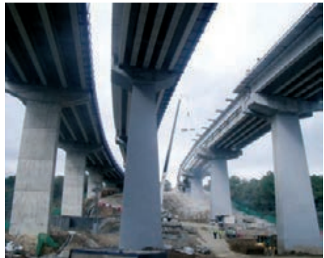
Figura 4. Viaductos de La Jarosa. De izquierda a derecha, calzada sentido Madrid, calzada reversible y calzada sentido La Coruña
