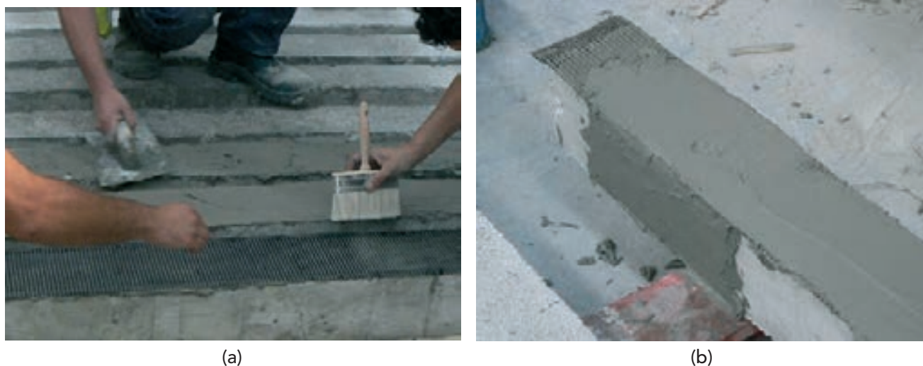
Figura 6. Aplicación de tejido de carbono como refuerzo interno del TRM y detalle de anclaje en forma de U
