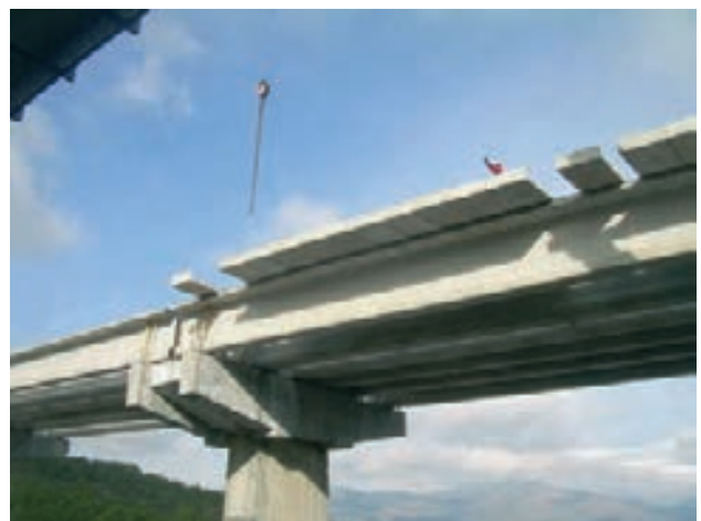
Figura 44. Colocación de prelosas: vista desde abajo
