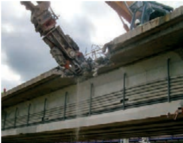
Figura 36. Demolición de losa existente: aceras y voladizos
