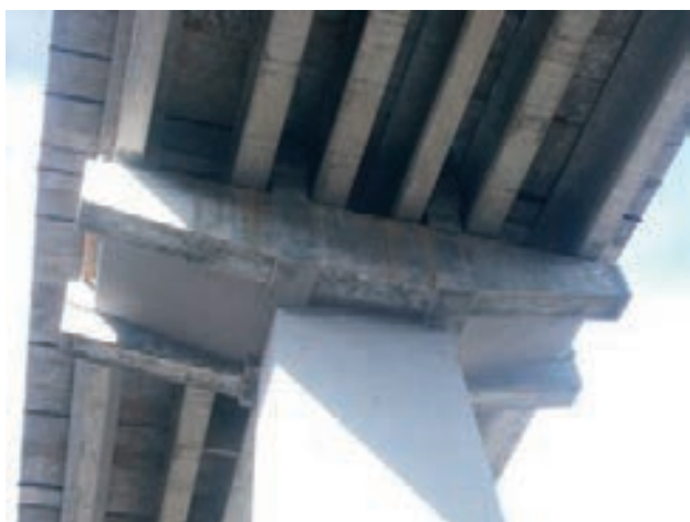
Figura 46. Vista inferior del dintel
