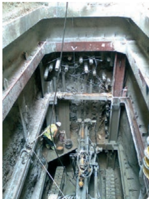
Figura 10. Ejecución del paraguas de micropilotes
