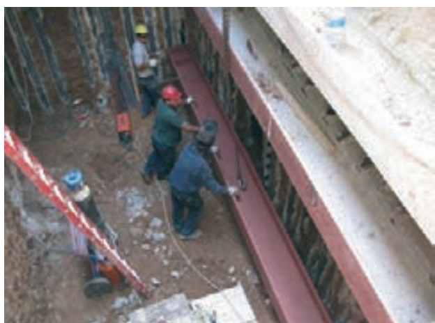
Figura 9. Montaje de los marcos metálicos de apuntalamiento del pozo de ataque
