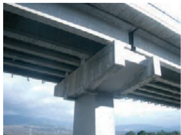
Figura 45. Dintel rehabilitado y ampliado, en servicio
