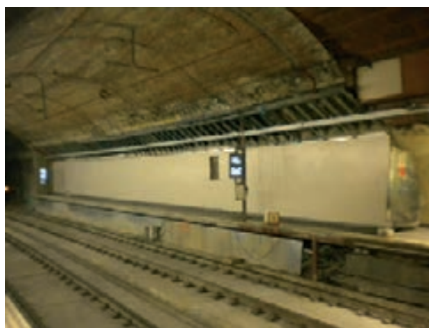
Figura 14. Vista del andén prolongado. Se aprecia la bóveda, la viga de reparto y las cartelas
