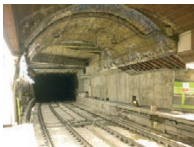
Figura 21. Vista de la ampliación del andén lado Sur
