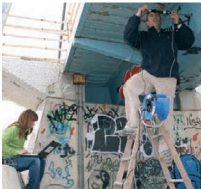
Figura 6. Introducción del boroscopio en el interior del tablero
