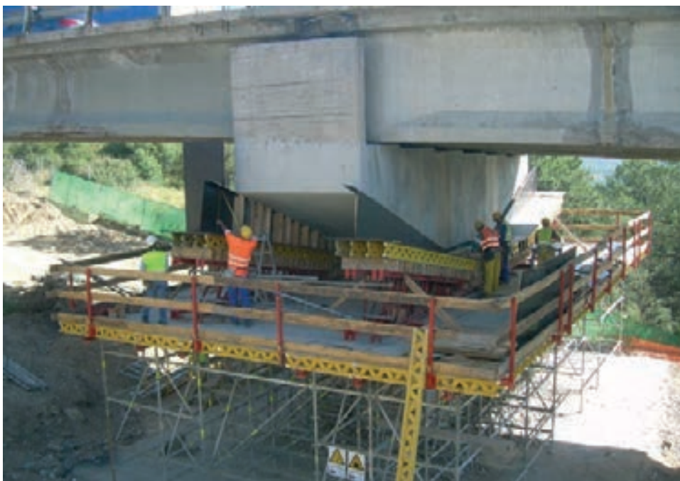
Figura 31. Encofrado de nuevos dinteles
