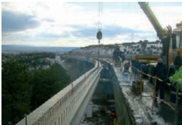
Figura 40. Colocación de vigas nuevas
