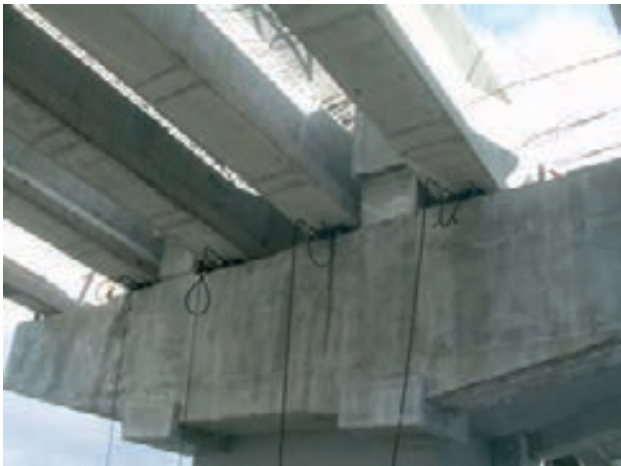
Figura 41. Sustrucción de apoyos existentes
