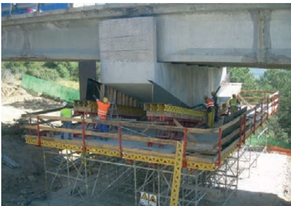
Figura 31. Encofrado de nuevos dinteles
