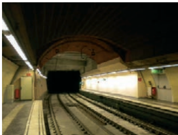
Figura 27. Aspecto de la obra terminada
