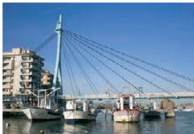
Figura 1. Vista general de la pasarela
