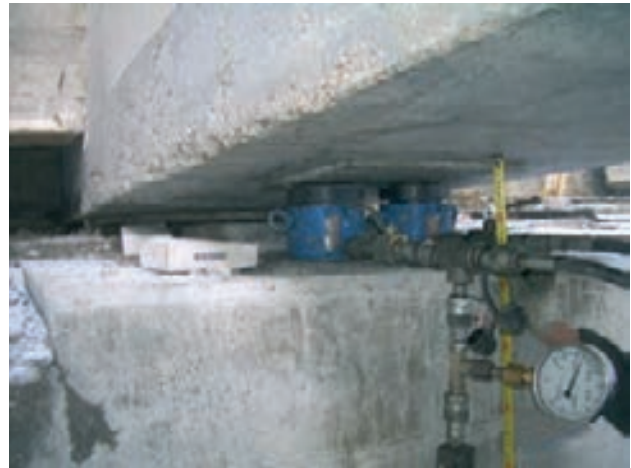
Figura 42. Gatos para la sustitución de apoyos
