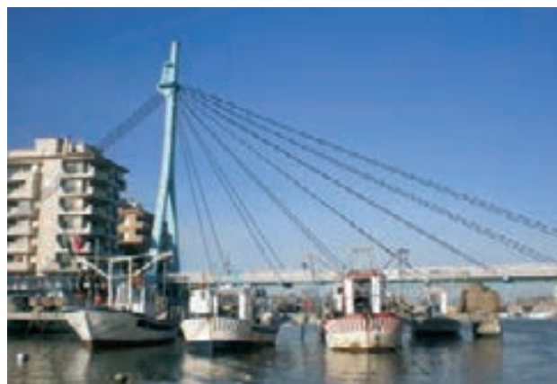
Figura 1. Vista general de la pasarela
