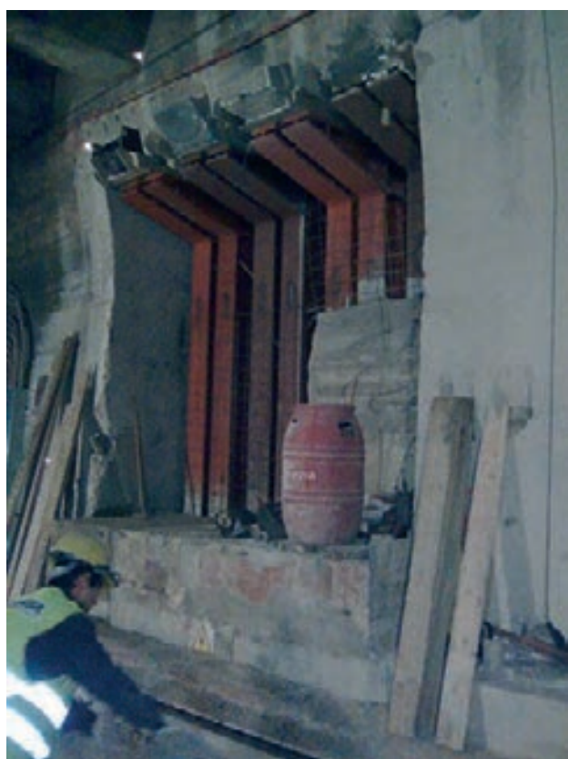
Figura 19. Hormigonado del hastial
