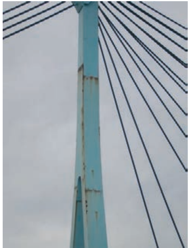
Figura 3. Aspecto en 2010 del pilono
