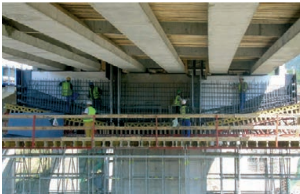
Figura 32. Ferrallado de nuevos dinteles
