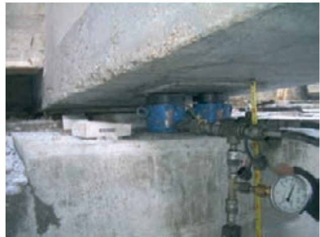
Figura 42. Gatos para la sustrucción de apoyos
