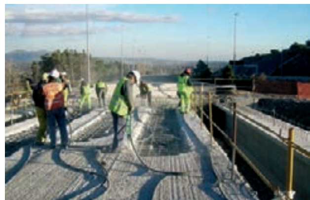
Figura 37. Demolición de losa existente: zona central
