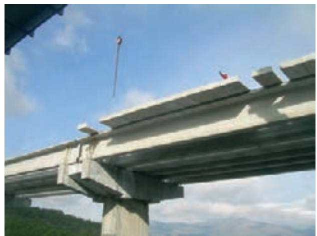
Figura 44. Colocación de prelosas: vista desde abajo
