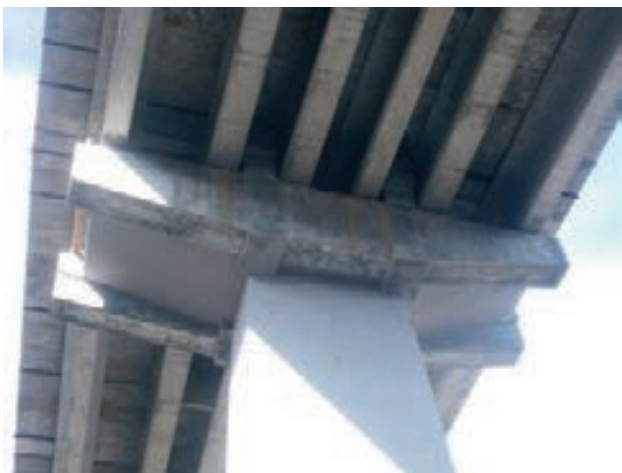
Figura 46. Vista inferior del dintel
