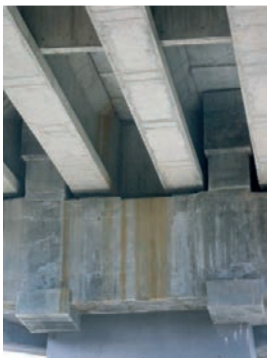
Figura 48. Vista de las vigas de cuelgue (entre las vigas del tablero) y la parte central del dintel nuevo. Se aprecian los regresamientos correspondientes a los anclajes del pretensado
