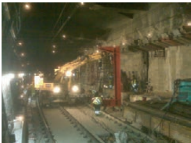
Figura 18. Colocación de la estructura metálica en C
