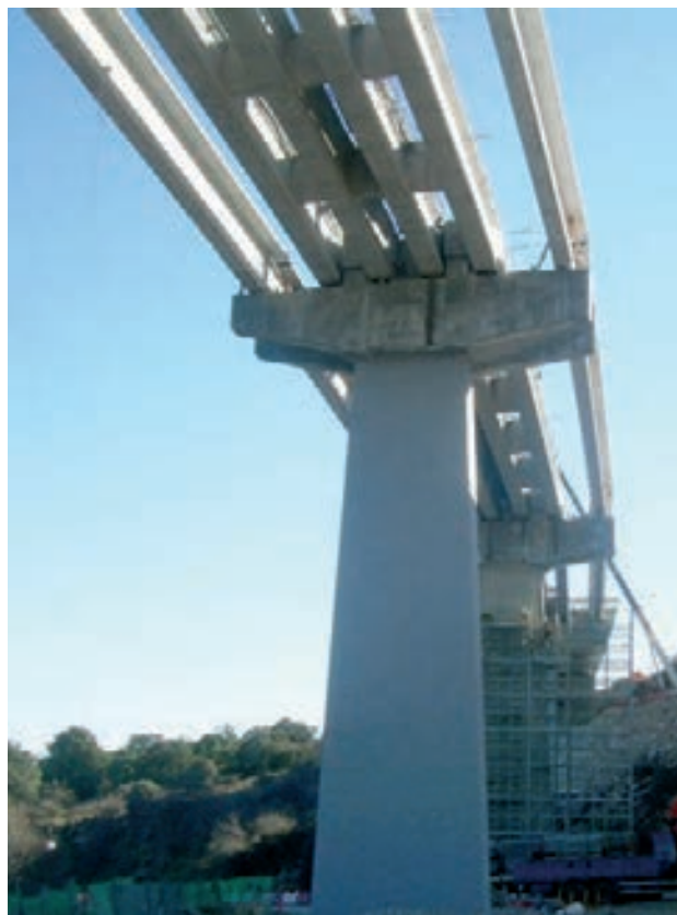
Figura 38. Vista de un vano con la losa superior demolida y las vigas extremas sustituidas por las nuevas
