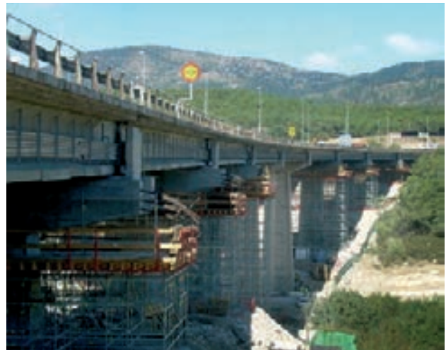
Figura 30. Vista general con las cimbras ya montadas
