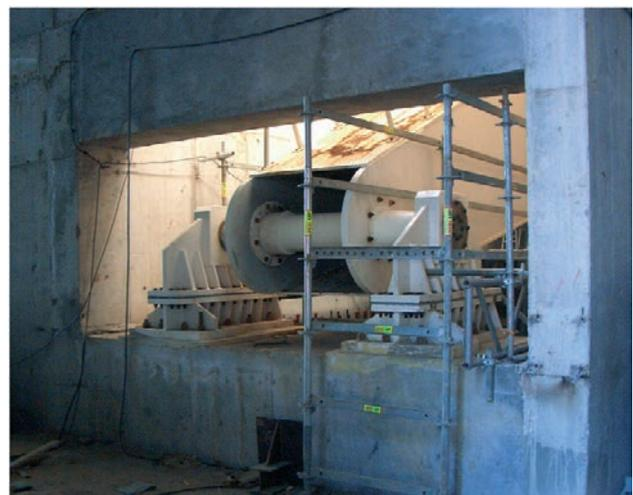
Figura 28. Cojinete principal ya instalado en el foso de mecanismos
