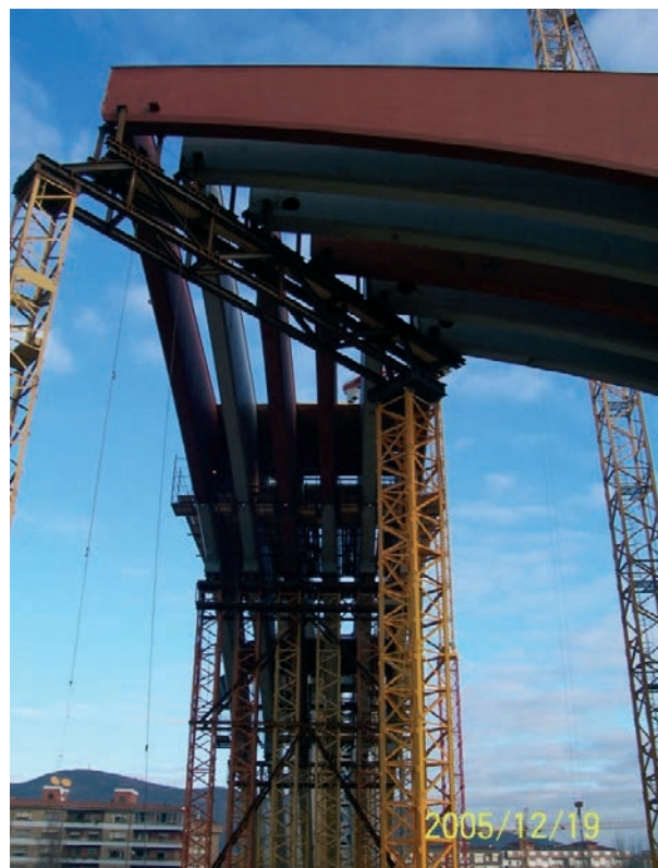
Figura 44. Torres de apeo con celosía superior en las intersecciones Sur-Este y Sur-Oeste
