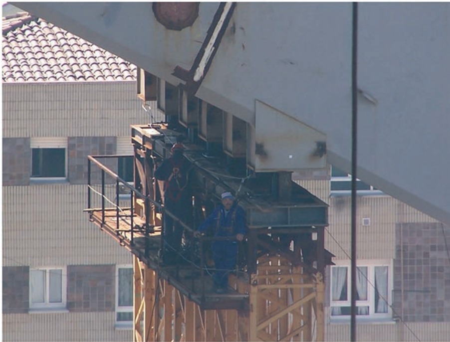
Figura 46. Detalle del apoyo superior de los apeos con alojamiento para los gatos hidráulicos de desapeo Figure 46. Detail of the upper support belonging to the auxiliary structures with housings for the hydraulic jacks
