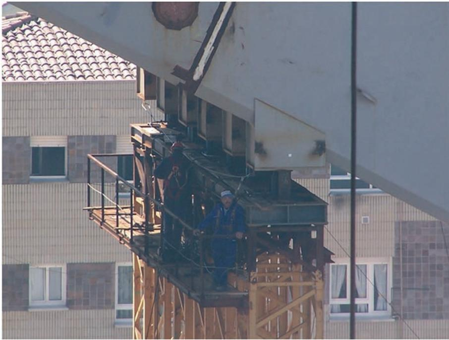
**Figura 46.** Detalle del apoyo superior de los apeos con alojamiento para los gatos hidráulicos de desapeo
