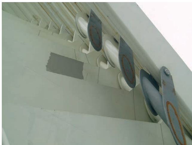
Figura 56. Tramos de arco móvil con orejetas ya montados en las costillas móviles
