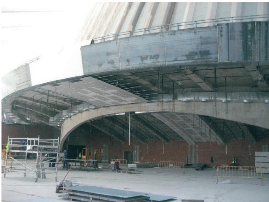
Figura 31. Vista general de la zona inferior de la losa del graderío con el muro circular y las vigas descolgadas
