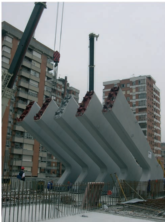
Figura 34. Bases de los pórticos principales ya anclados a la estructura de hormigón
