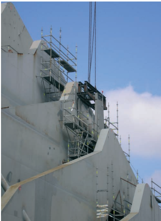
Figura 49. Izado y montaje de uno de los tramos del arco fijo Figura 49. Elevation and mounting of one of the parts of the fixed arch
