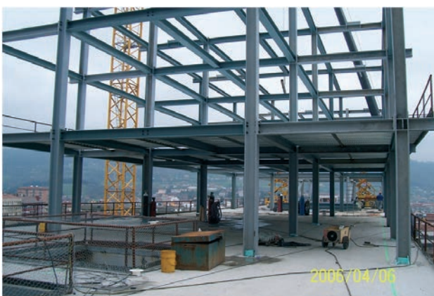
Figura 14. Entramado metálico de los edificios. Pórticos transversales unidos mediante vigas isostáticas Figure 14. Steel structure of the buildings. Transverse frames connected by longitudinal isostatic beams
