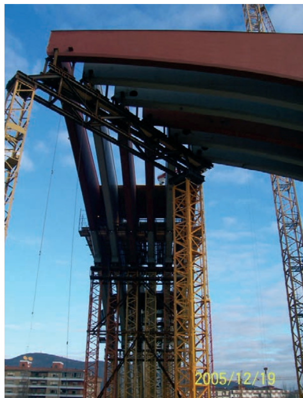
Figura 44. Torres de apeo con celosía superior en las intersecciones Sur-Este y Sur-Oeste
