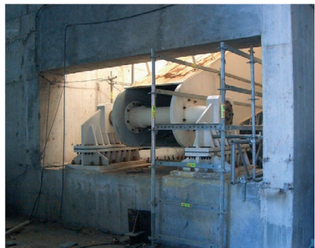
Figura 28. Cojinete principal ya instalado en el foso de mecanismos Figure 28. Main bearing already installed
