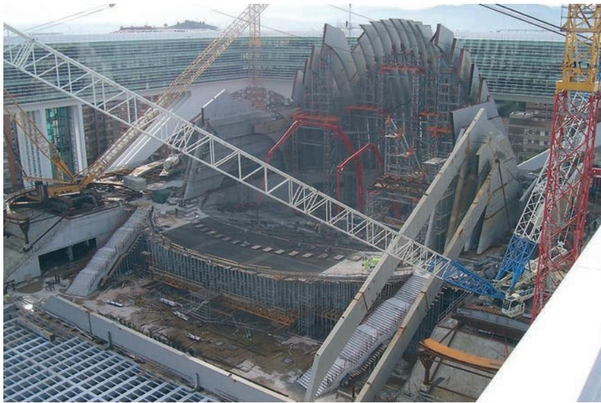
Figura 47. Montaje de las costillas fijas sobre torres de apeo
