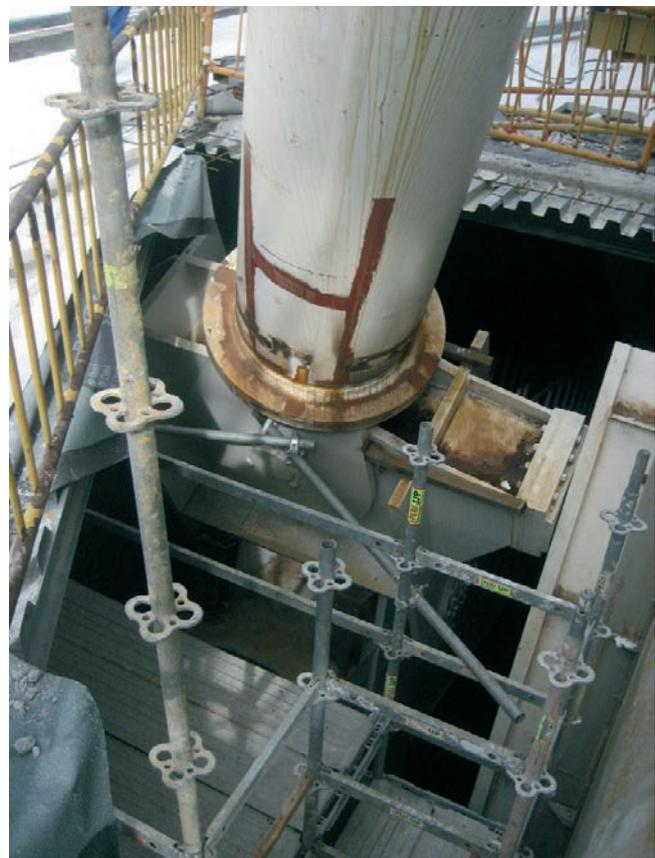
Figura 59. Conexión del extremo inferior del arco móvil a la palanca guiadora
