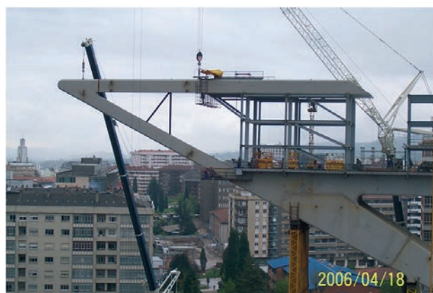
Figura 16. Voladizo Norte ya situado en su posición definitiva Figure 16. North cantilever already mounted in its final position
