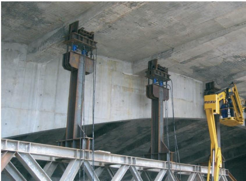
Figura 48. Soportes de acero utilizados en el apeo de la losa del graderío,
