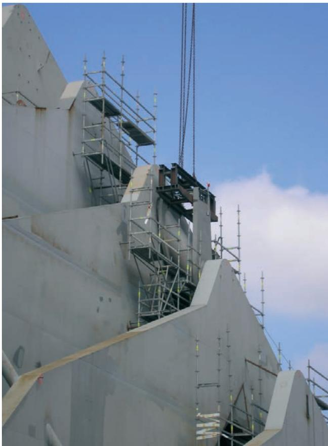
Figura 49. Izado y montaje de uno de los tramos del arco fijo
