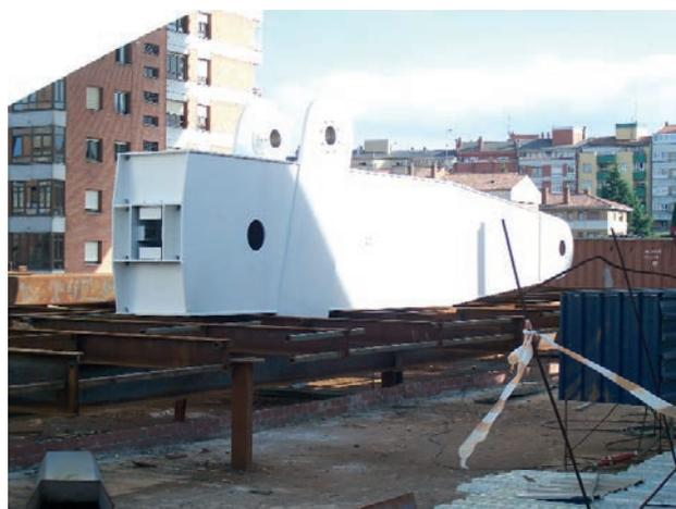
Figura 30. Palanca guiadora antes de ser instalada en el foso
