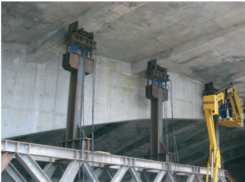
Figura 48. Soportes de acero utilizados en el apeo de la losa del graderío, instrumentados con células de carga y apoyados sobre celosías auxiliares Figure 48. Steel columns monitored with load cells and supported on auxiliary trusses, used to support the grandstand slab
