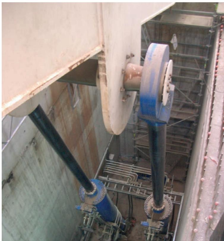
Figura 60. Conexión de la palanca guiadora a los cilindros de accionamiento
