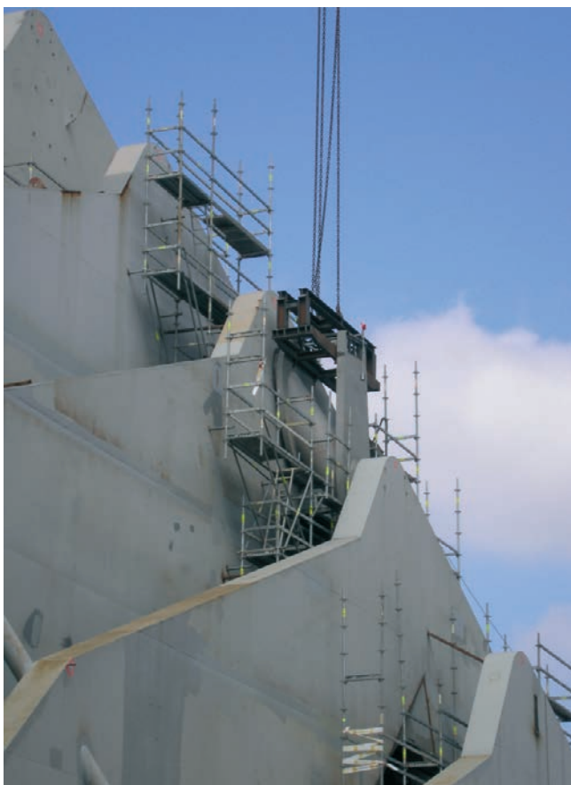
Figura 49. Izado y montaje de uno de los tramos del arco fijo Figure 49. Elevation and mounting of one of the parts of the fixed arch
