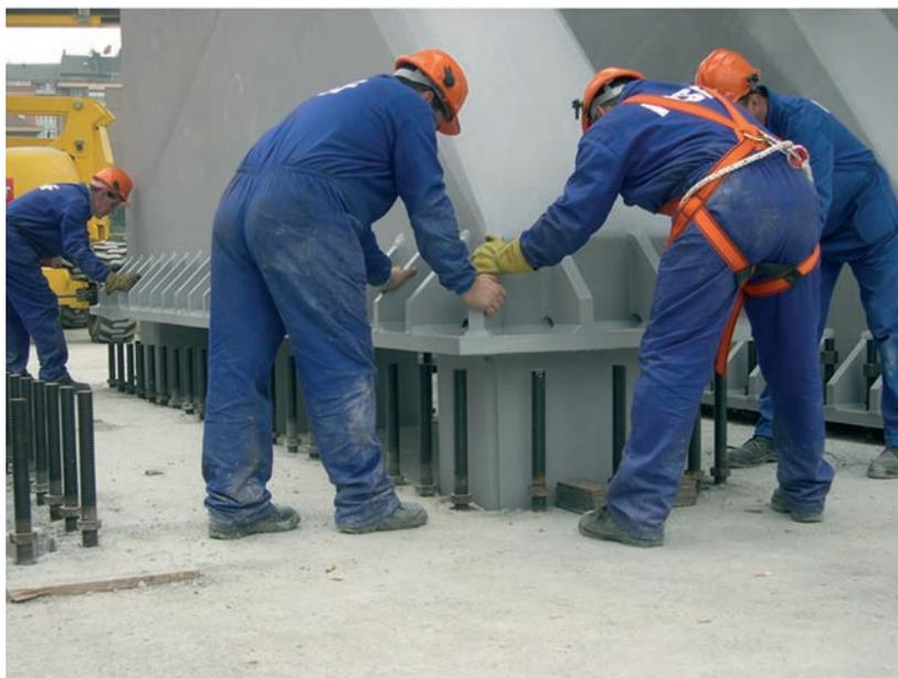
Figura 35. Proceso de montaje de una de las bases de los pórticos principales
