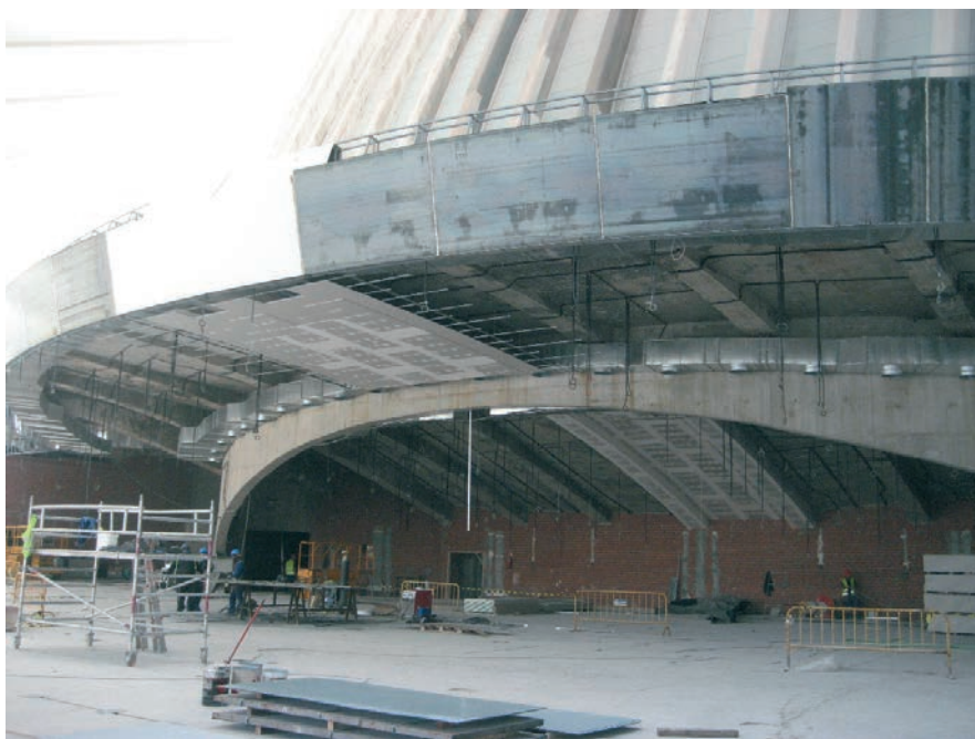
Figura 31. Vista general de la zona inferior de la losa del graderío con el muro circular y las vigas descolgadas Figure 31. General view of the lower surface of the grandstand slab with the circular wall and the downstand beams
