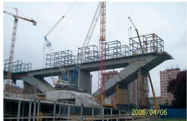
Figura 15. Vista general de la estructura de una de las consejerías con los pórticos principales finalizados y el entramado metálico superior en ejecución
