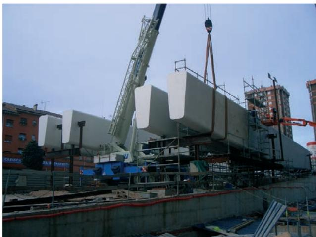
Figura 50. Bancadas de montaje de las costillas móviles
