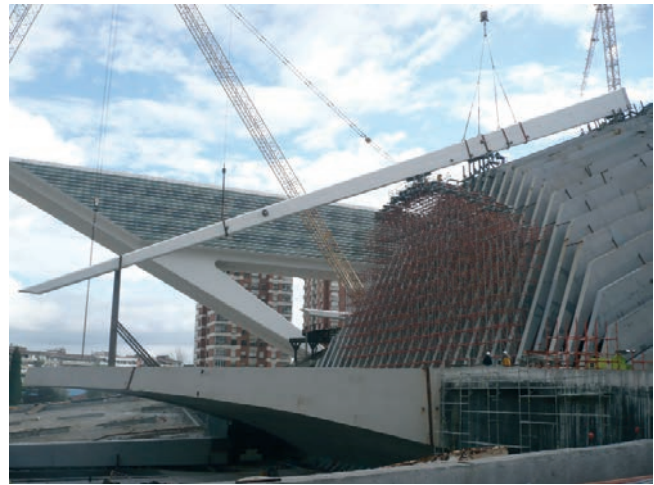
Figura 52. Prearmado Norte de la costilla móvil CM1 ya situado sobre los apoyos auxiliares de montaje
