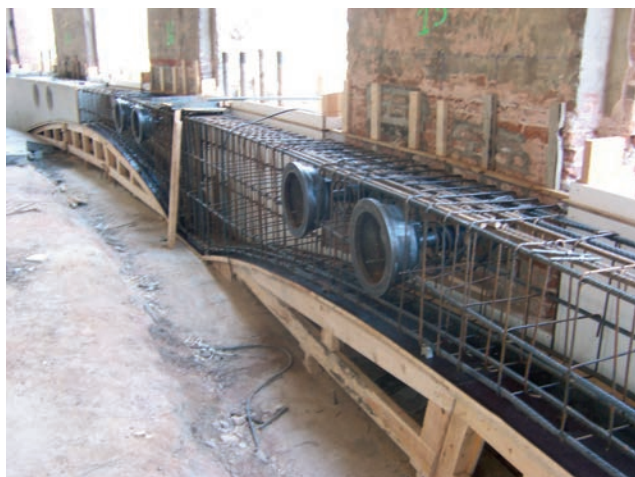
Figuras 14 y 15. Viga-arco de pie de fachada Figures 14 & 15. Arch beam at foot of façade
