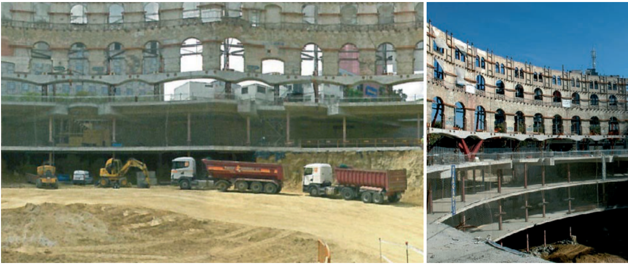
Figuras 28 y 29. Fases de excavación descendente hasta sótanos -3 y -5, respectivamente Figures 28 & 29. Top-down excavation stages to basement levels -3 and -5, respectively.
