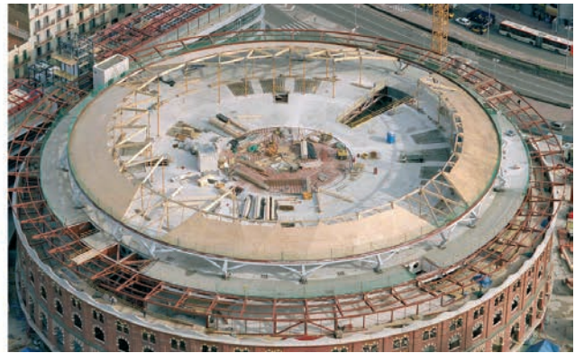
Figura 59. Vistas de la fase de montaje de la cúpula de madera Figure 59. Views of the wooden-dome erection stage
