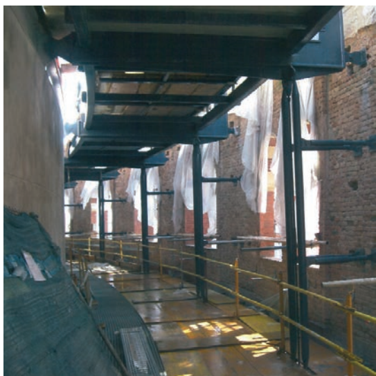
Figuras 44 y 45. Vista de pasarela de conexión intermedia e imagen de conexión superior Figures 44 & 45. View of intermediate connecting walkway and image of upper link
