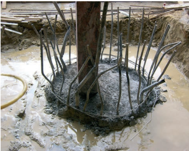
Figuras 31 y 32. Detalle de cabeza de pilote y arranque de pilar, y croquis de encepado Figures 31 & 32. Detail of pile cap and support base, and diagram of pile cap
