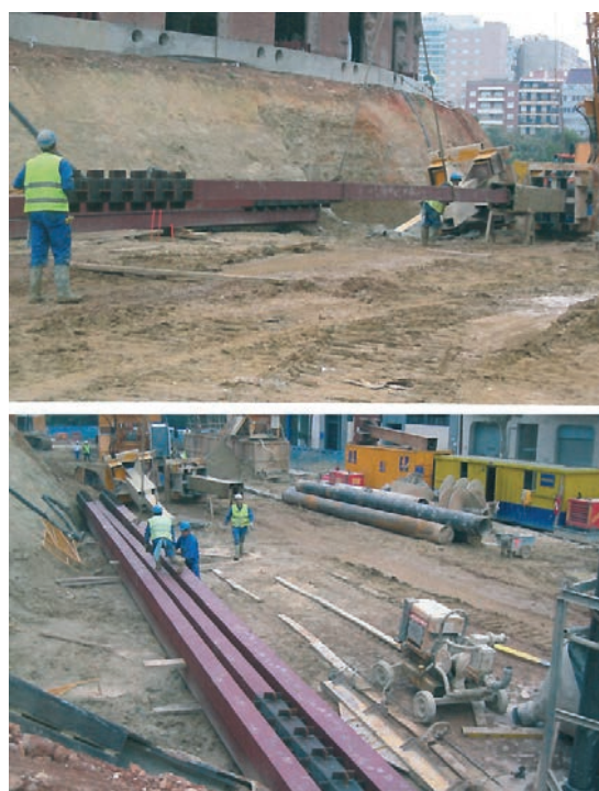
Figuras 11 y 12. Croquis de pilote-pilar y vistas de pilares metálicos Figures 11 & 12. Plunge columns and views of steel supports
