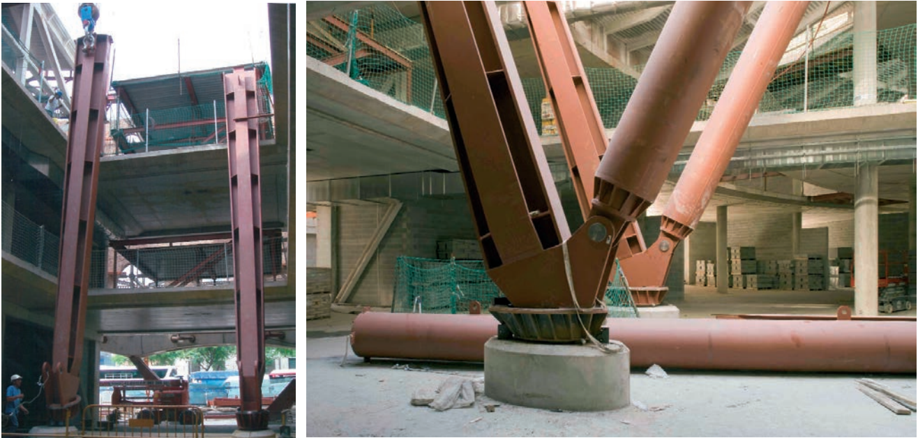
Figuras 47 y 48. Montaje de los fustes exteriores y detalle de arranque de fuste Figures 47 & 48. Erection of exterior shafts and details of base of shafts.
