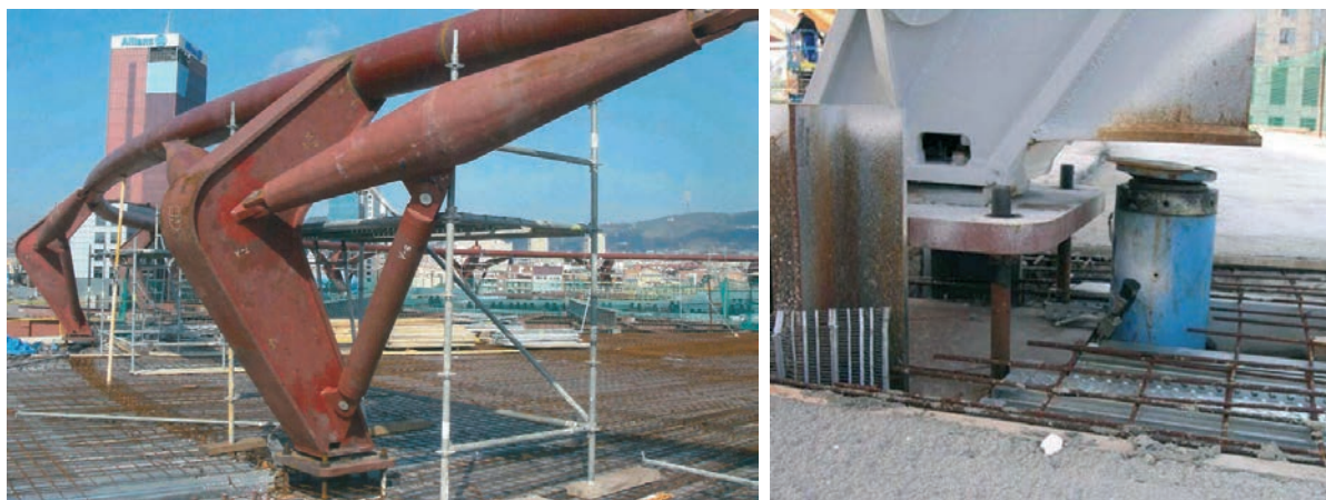
Figura 57. Pilar "boomerang" y viga-anillo de tracción de la cúpula. Detalle de gato de nivelación Figure 57. "Boomerang" support and pull-ring beam of the dome. Detail of levelling jack
