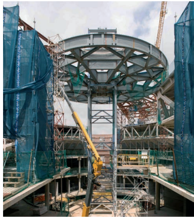
Figuras 53. Montaje de platea mediante torre central y de vigas radiales y circunferenciales sobre cimbra
