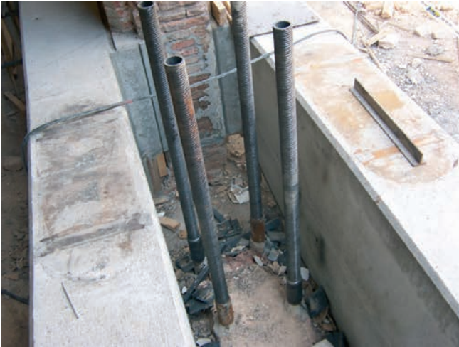
Figuras 16 y 17. Micropilotes y estructura de suspensión entre vigas-arco Figures 16 & 17. Minipiles and suspension structure between arch beams
