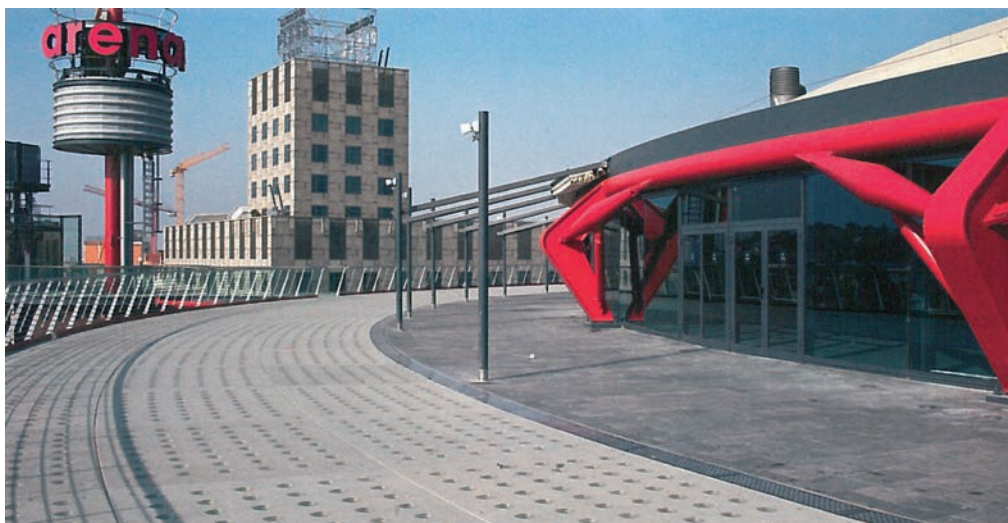
Figura 56. Losa de hormigón prefabricado con óculos vidriados Figure 56. Precast-concrete slab with glazed skylights.
