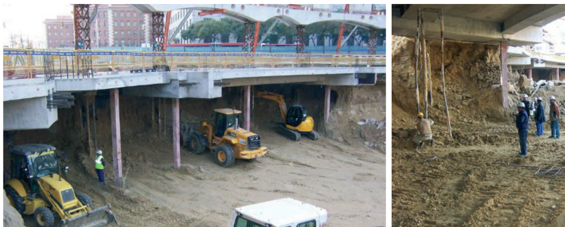
Figuras 26 y 27. Vistas de la excavación bajo la estructura de planta baja Figures 26 & 27. Views of excavation below the ground-floor structure
