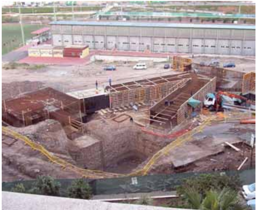
Figura 29. Vista del estribo 1 en construcción. Figure 29. View of abutment 1 under construction.
