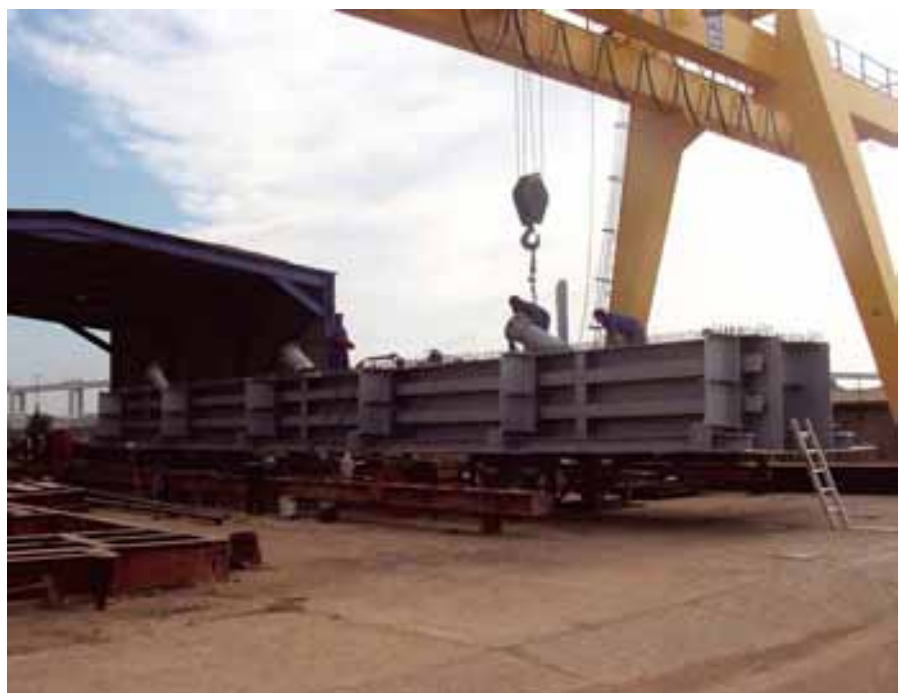
Figura 15. Módulo central del tablero por zona de anclajes de tirantes. Figure 15. Central unit of the deck in the stays anchorage area.
