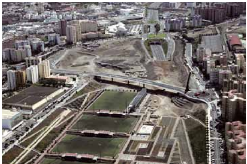
Figura 4. Vista del viaducto desde el inicio del barranco. Figure 4. View of the viaduct from the beginning of the gully.
