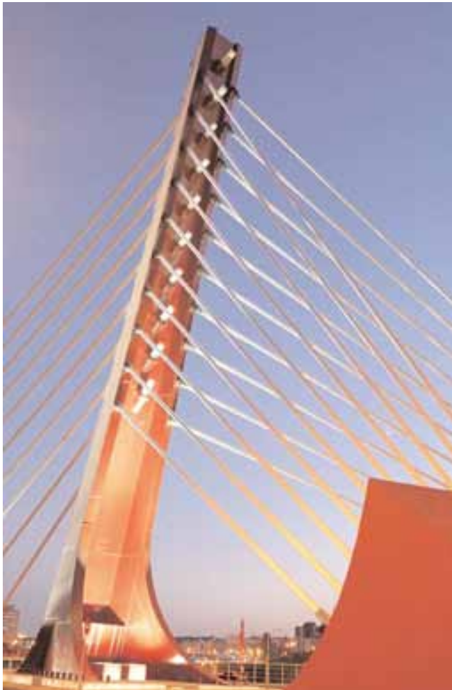
Figura 18. Vista del mástil iluminado desde la ladera oeste. Figure 18. View of the illuminated pylon from the west hillside.
