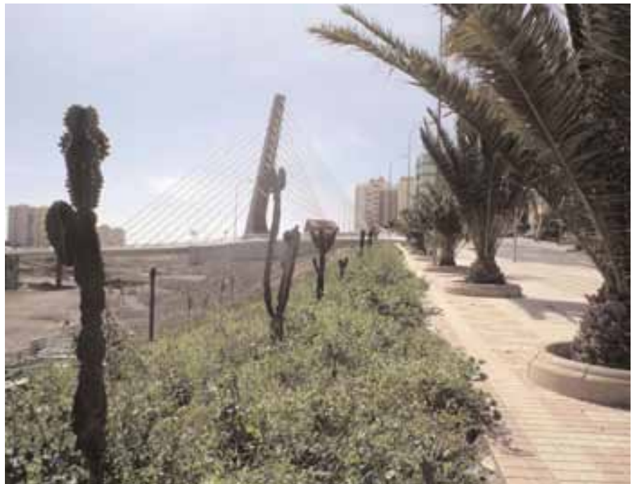
Figura 11. Acceso al parque por la zona del estribo. Figure 11. Entranceto the park in the area of abutment 1.
