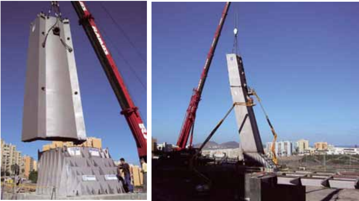
Figura 34. Izado de las 2 primeras dovelas del mástil. Figure 34. Hoisting of the first two segments of the pylon.
