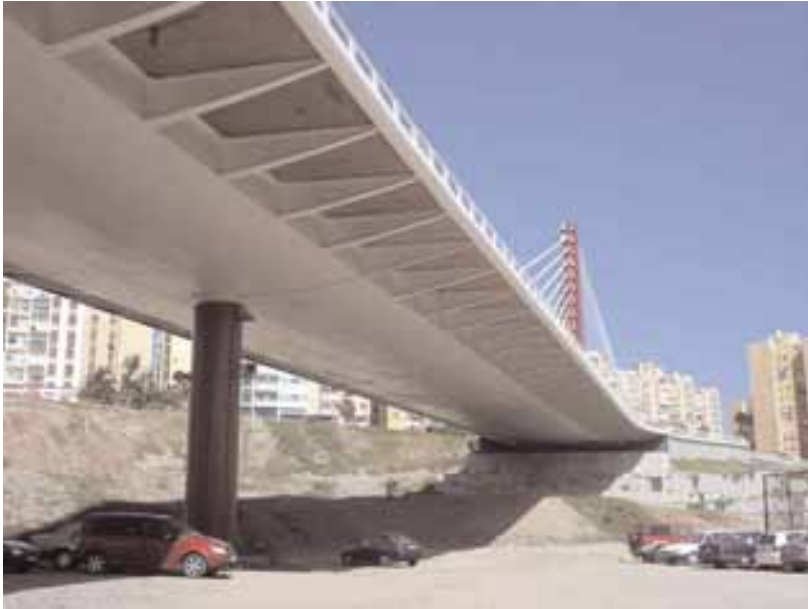
Figura 7. Vista del viaducto desde el parque. Figure 7. View of the viaduct from the park.
