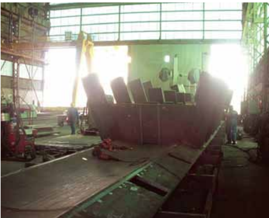
Figura 20. Premontaje del mástil en el taller metálico. Diagramas horizontales. Figure 20. Preassembly of the pylon in the metal workshop. Horizontal diaphragms.
