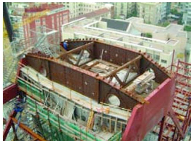
Figura 19. Posicionamiento de las piezas metálicas del elemento de suspensión.
