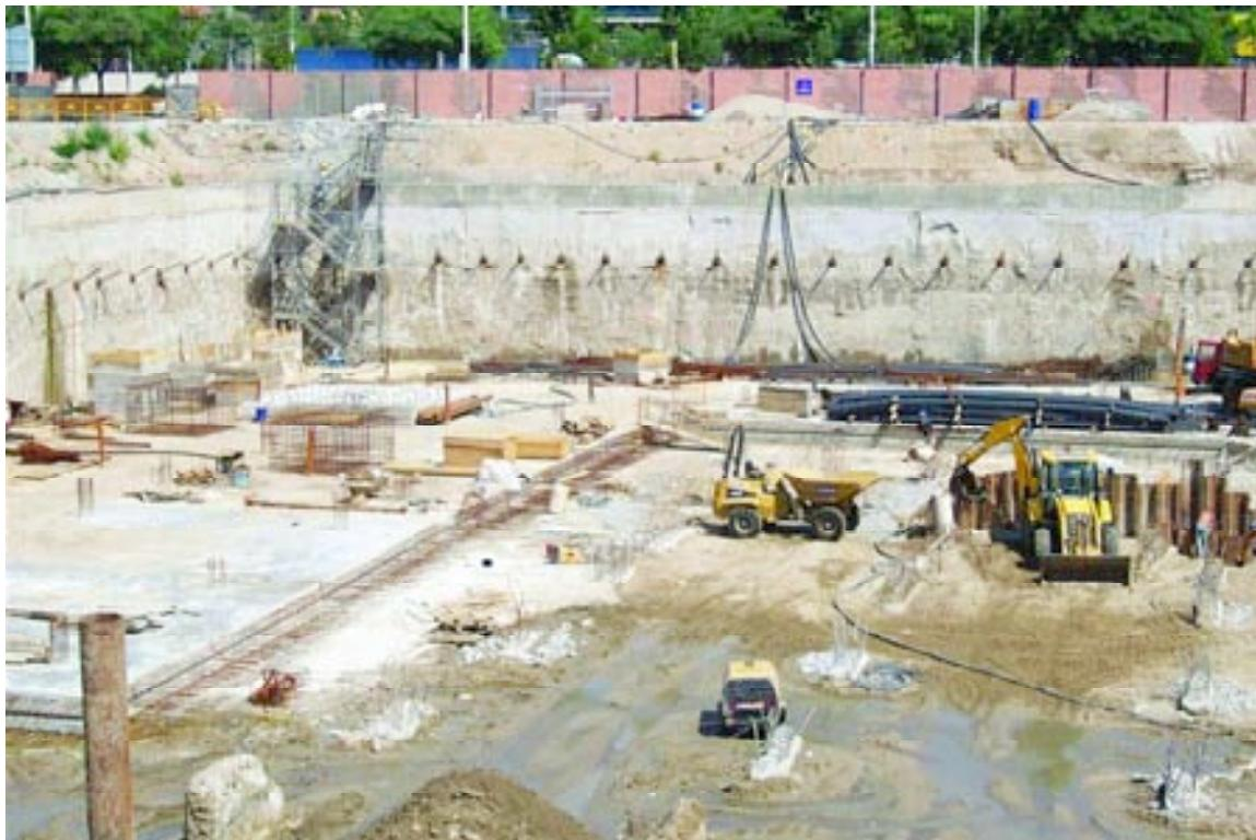
Figura 6. Ejecución de pantallas ancladas y losa de fondo.
