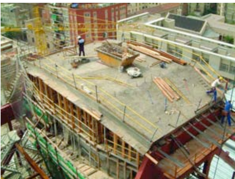
Figura 20. Vista de la estructura del elemento de suspensión durante el pretensado de la losa superior. Figure 20. View of the hanging structure during the prestressing of the upper slab.
