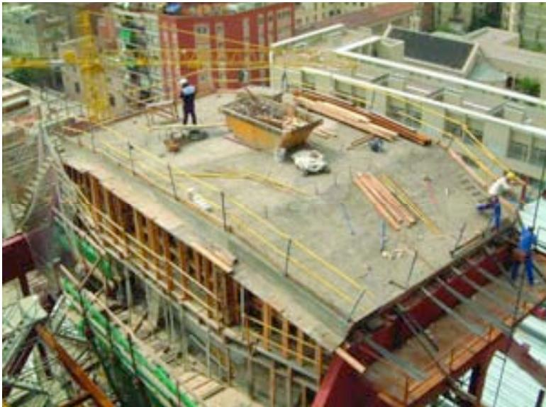
Figura 20. Vista de la estructura del elemento de suspensión durante el pretensoado de la losa superior.
