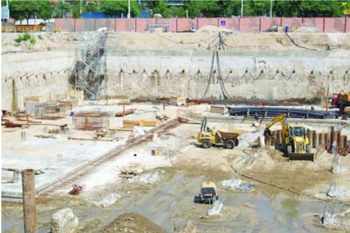
Figura 6. Ejecución de pantallas ancladas y losa de fondo. Figure 6. Construction of anchored retaining walls and foundation slab.
