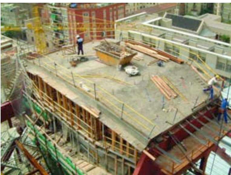
Figura 20. Vista de la estructura del elemento de suspensión durante el pretensado de la losa superior. Figure 20. View of the hanging structure during the prestressing of the upper slab.
