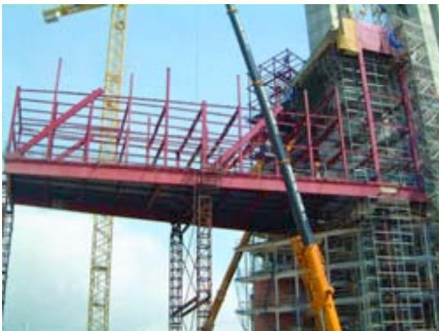
Figura 18. Ejecución del portaaviones en fase 3.
