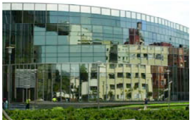
Figura 34. Edificio Cascada. Figure 34. Cascade Building.
