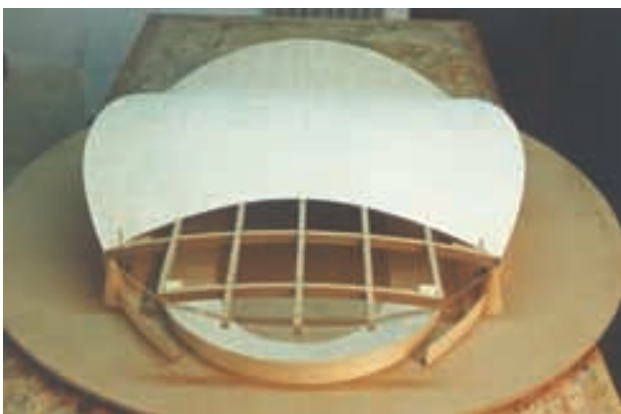
Figura 28. Modelo a escala de la cubierta del velódromo. Figure 28. Scale model of the roof of the velodrome.
