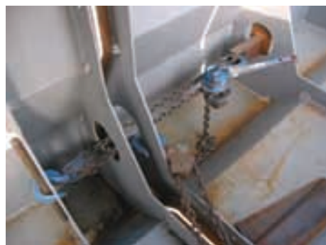
Figura 44. Utilización de los rigidizadores como auxiliares en el ensamble de cajones. Figure 44. Use of the stiffeners as auxiliary elements for the erection of caissons.
