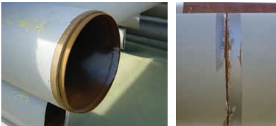
Figura 36. Soldaduras en línea. Preparación de la camisa y unión. Figure 36. Inline welds. Preparation of the sleeve and joint.
