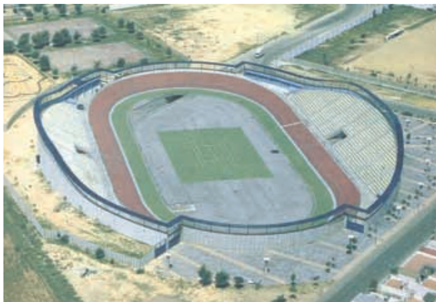
Figura 1. Estado inicial del recinto. Figure 1. Initial state of the site.
