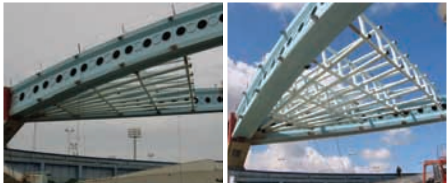
Figura 56. Aspecto de la malla durante el montaje en la zona de voladizos. Figure 56. Appearance of the mesh during erection in the jut area.
