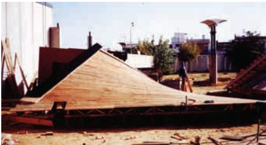
Figura 52. Confección de los encofrados de madera. Figure 52. Preparation of the wood formwork.
