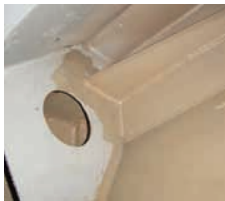
Figura 42. Refuerzo de los rigidizadores en puntos de concentración de fuerzas. Figure 42. Reinforcement of the stiffeners at stress concentration points.
