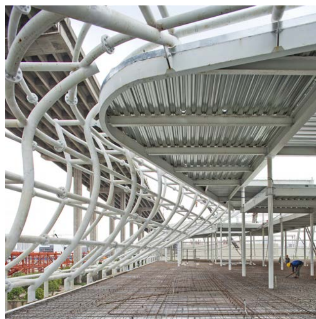
Figura 7. Área de oficinas. La fachada, junto con los soportes interiores, sustentan los forjados y cubiertas, resueltos con estructuras mixtas
