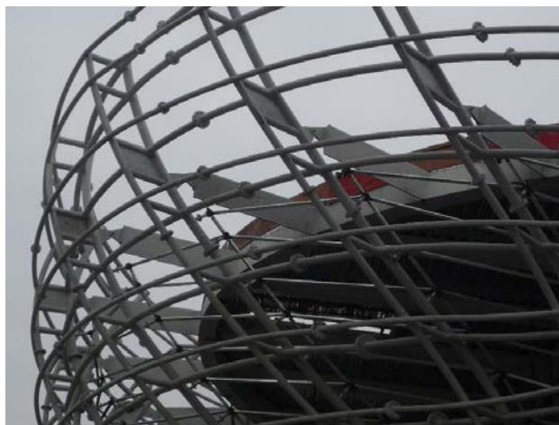
**Figura 20.** Detalle de la cubierta de la Sala Expositiva 2. Las vigas triangulares se unen por medio de bulones a la fachada, rigidizada por paneles en esa zona
