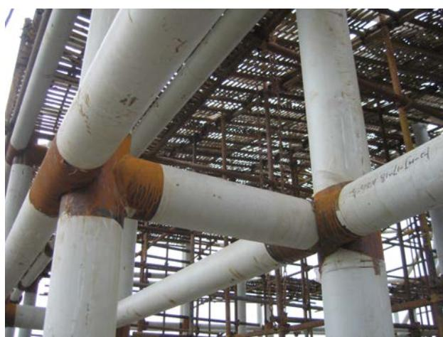
**Figura 13.** Detalle de la unión excéntrica. Los tubos verticales son pasantes, mientras que los horizontales son cortados
