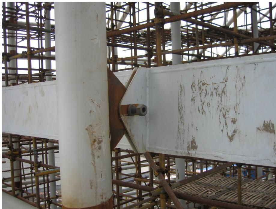
**Figura 17.** Unión bulonada en construcción, conectando viga de borde con tubo de fachada mediante orejetas
