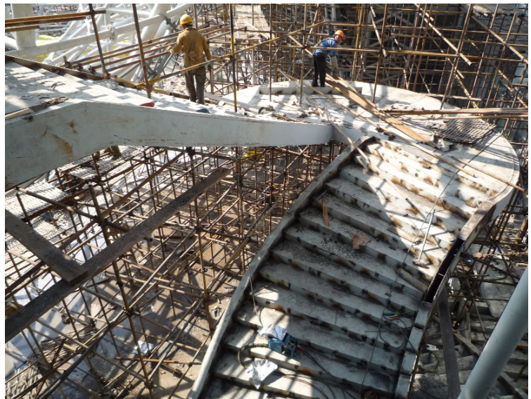
Figura 23. Escalera curva volada en construcción Figure 23. Cantilever curved stairs under construction
