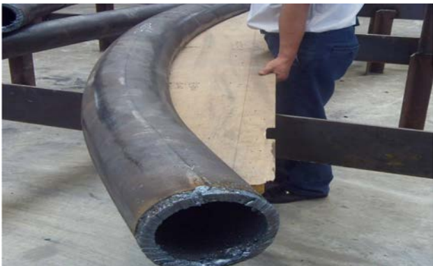
Figura 32. Comparación de tubo curvado con una plantilla de madera Figure 32. Curved tubes being checked against a wood template
