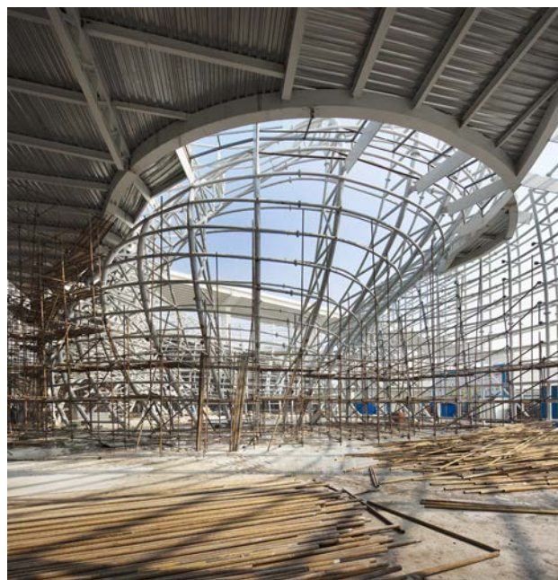
Figura 21. Vista desde la que se puede apreciar la esbeltez de las vigas triangulares Figure 21. View where the slenderness of the triangular beams may be grasped
