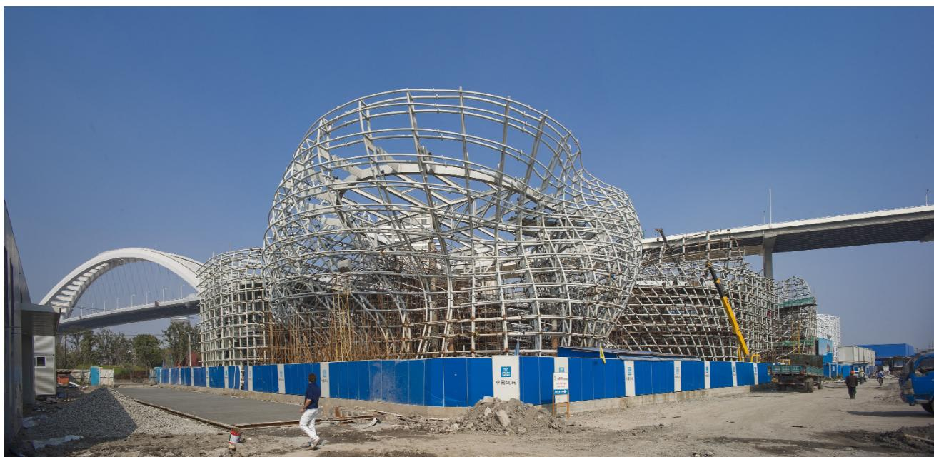
Figura 4. Perspectiva general del pabellón en construcción, con el Puente Lupu de fondo
