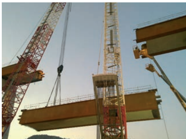
Figura 24. Vista durante montaje de vanos y colocación de tramo de cierre
