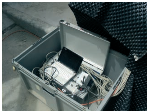
Figura 10. Monitorización de los movimientos del tablero en estribos durante la fase de ejecución del viaducto Figure 10. Monitoring of deck displacements at abutments during the construction stage of the viaduct
