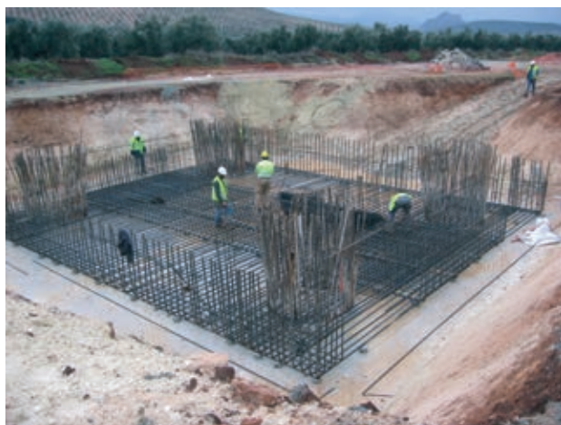
Figura 15. Montaje de la ferralla de los encepados de las pilas tipo Figure 15. Reinforcement assembling at the pilecaps of typical piers
