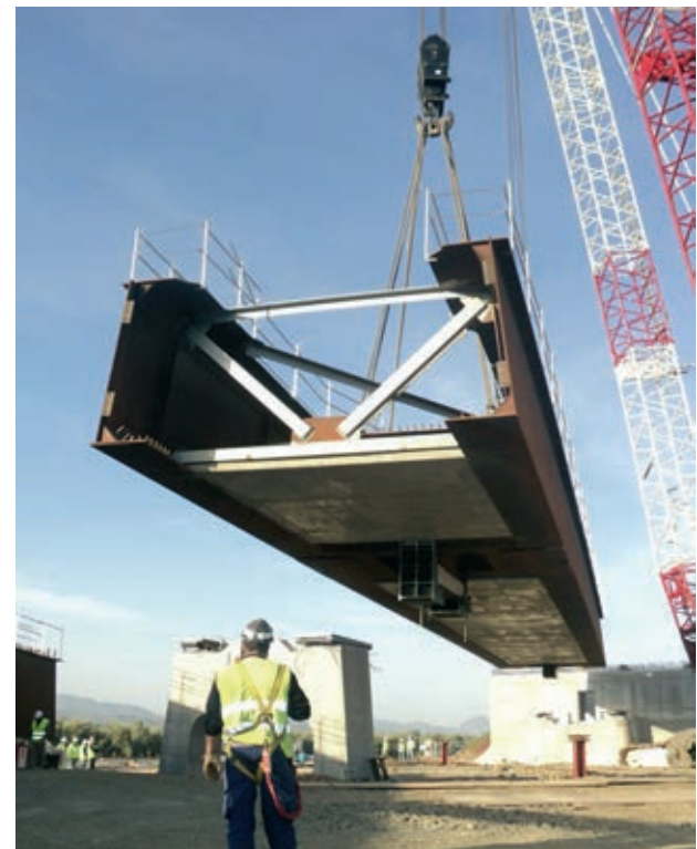
Figura 23. Izado de piezas tras la ejecución parcial de la losa inferior del tablero Figure 23. Lifting of pieces after partial execution of bottom slab
