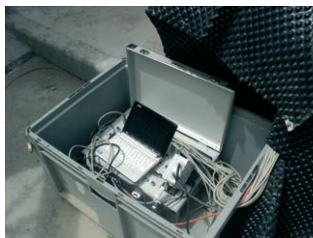
Figura 10. Monitorización de los movimientos del tablero en estribos durante la fase de ejecución del viaducto Figure 10. Monitoring of deck displacements at abutments during the construction stage of the viaduct
