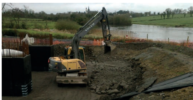
Figura 10. Estribo norte en ejecución.
