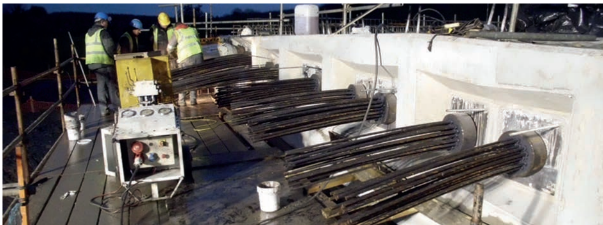
Figura 14. Vista de los anclajes de postesado interior en zona de estribo.
