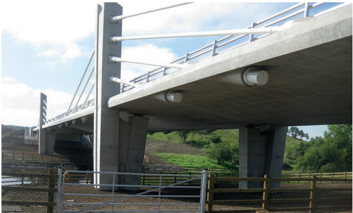
Figura 17. Capots de protección de anclajes de los tirantes bajo el tablero.
