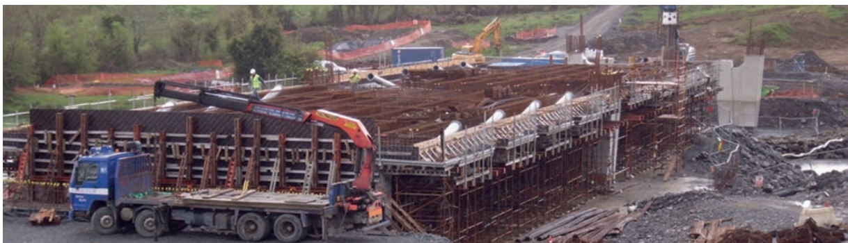
Figura 13. Vista de cimbra y tablero.
