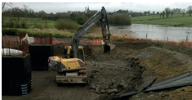
Figura 10. Estribo norte en ejecución.
