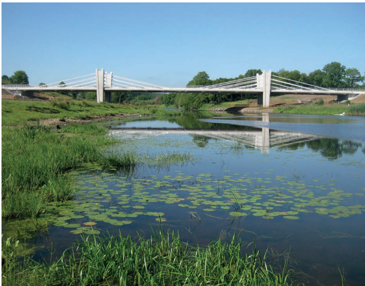
Figura 18. Acabado final del puente.
